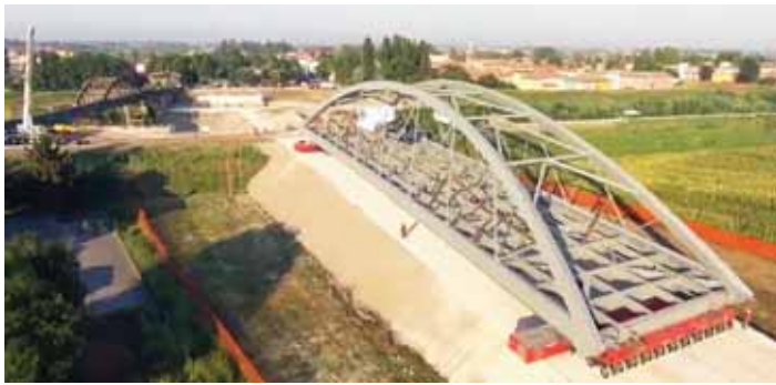
Fig. 19 - Avvicinamento dal campo di montaggio al fiume (vedasi sulla sinistra il vecchio ponte)
