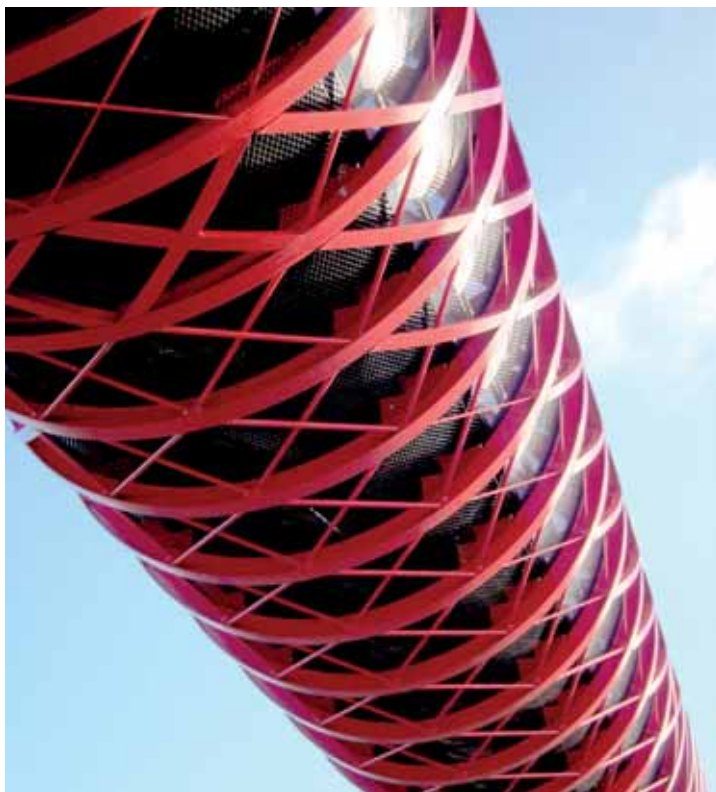
Fig. 20 – Vista della passerella dai binari, in cui ben si evincono la sequenza di anelli e le diagonali a sezione tonda da 20mm. (©William Chevillon)
