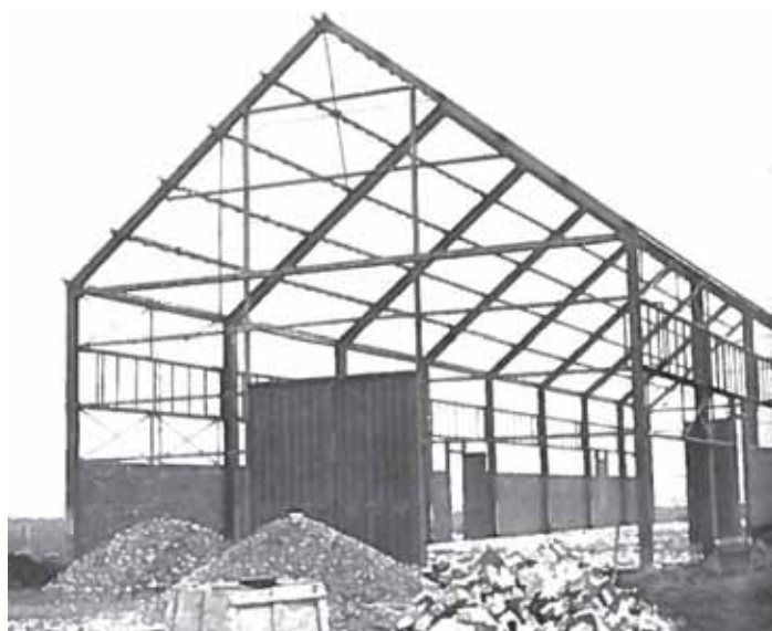
Fig. 16 - F. de Miranda, struttura prefabbricata per chiese.
