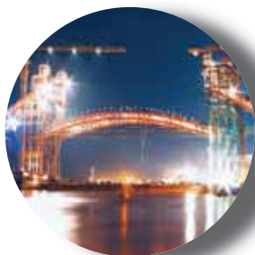
Vietnam, Sollevamento sezione centrale di un ponte con martinetti
