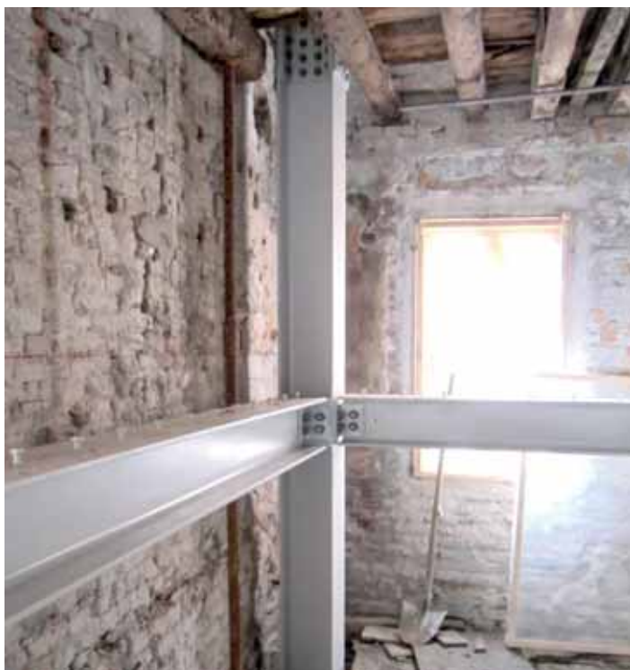
Fig. 13 - Particolare inserimento nuove strutture in acciaio
