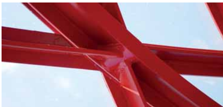
Fig. 21– Dettaglio dell'incrocio saldato tra un anello e le diagonali, che in tal caso hanno sezione a T. (©HDA)
