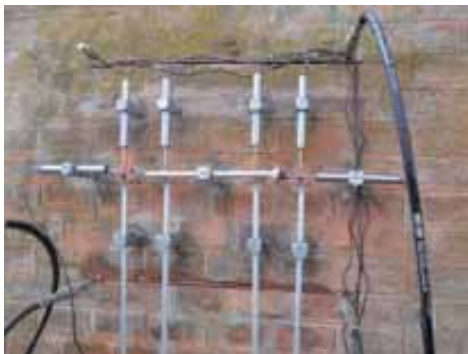
Fig. 8 - Prove con martinetto piatto singolo e doppio su spalle e pile
