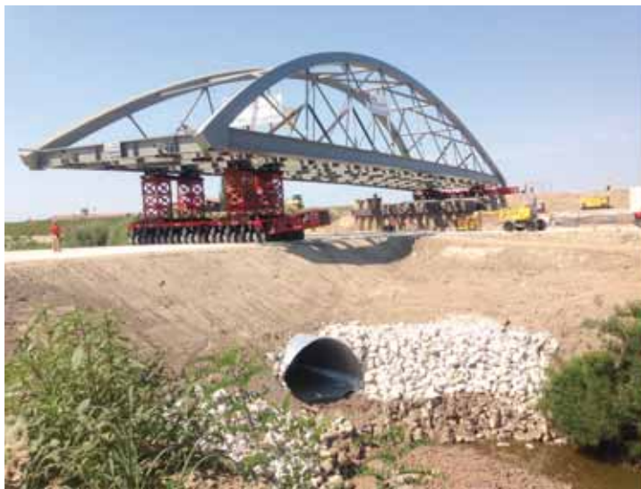
Fig. 22 - Immagini del Varo: bypass e confronto ponte nuovo ed esistente
