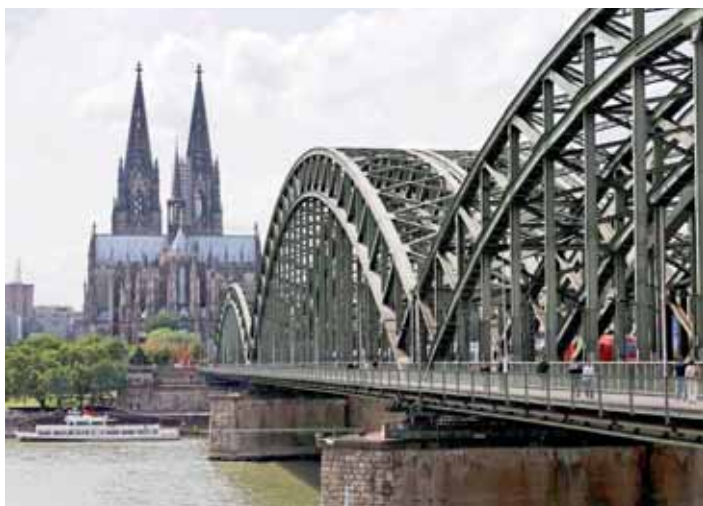
Fig. 6 – Ponte di Colonia
