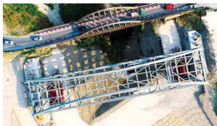
Fig. 24 - Immagini del varo - Traslazione finale
