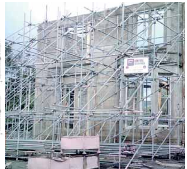
Fig. 11 - Opzione 2: Sistema di ritegno in tubolari metallici
