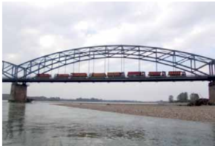
Fig. 6 - Prove di carico statico. Misure delle deflessioni e monitoraggio degli appoggi.
