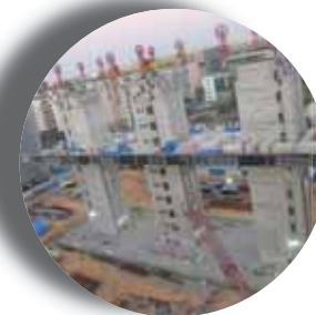
Installazione di un ponte da 500 ton con carrelli e martinetti
