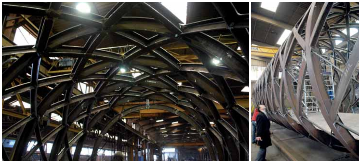
Fig. 14 - Viste delle fasi di produzione della carpenteria metallica, prefabbricata per tronconi. (©HDA)
