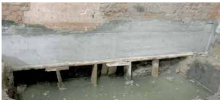
Fig. 18 - Riparazioni murature ammalorate
