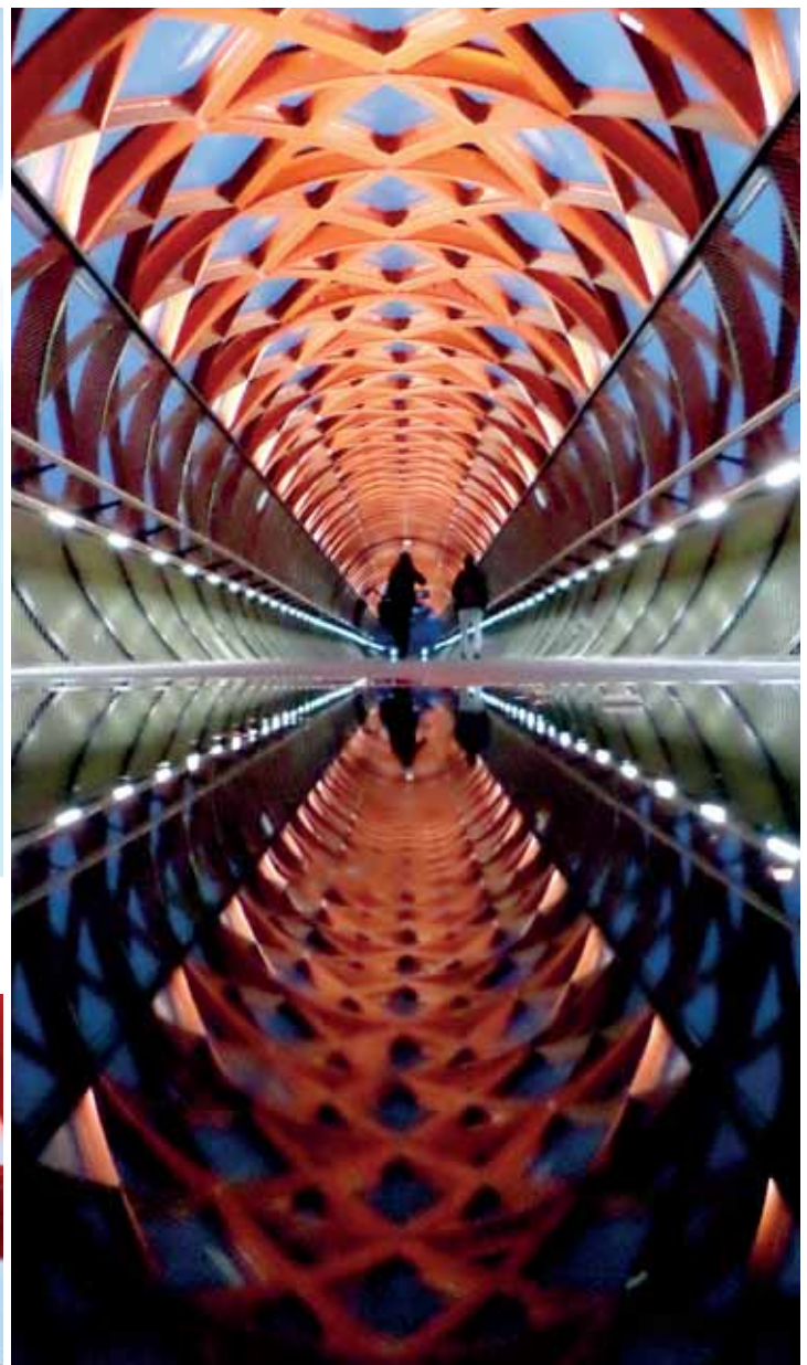
Fig. 22 – Vista notturna della passerella dall'interno con la percezione delle finiture: la copertura in plexiglas trasparente, le lastre di calcestruzzo prefabbricate come solaio, le lamiere stirate come parapetti. (©William Chevillon)
