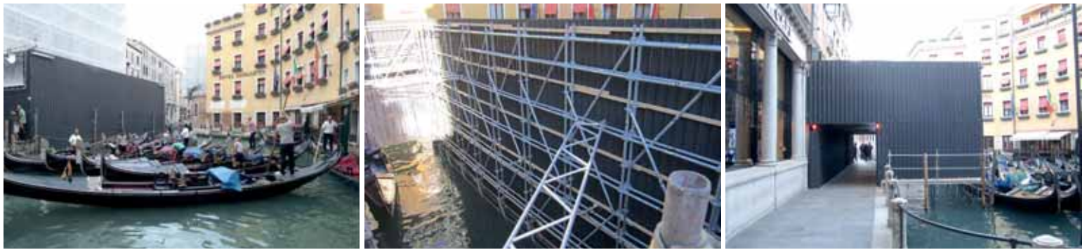
Fig. 6 - Sistemazione temporanea del Bacino Orseolo con il cantiere in attività
