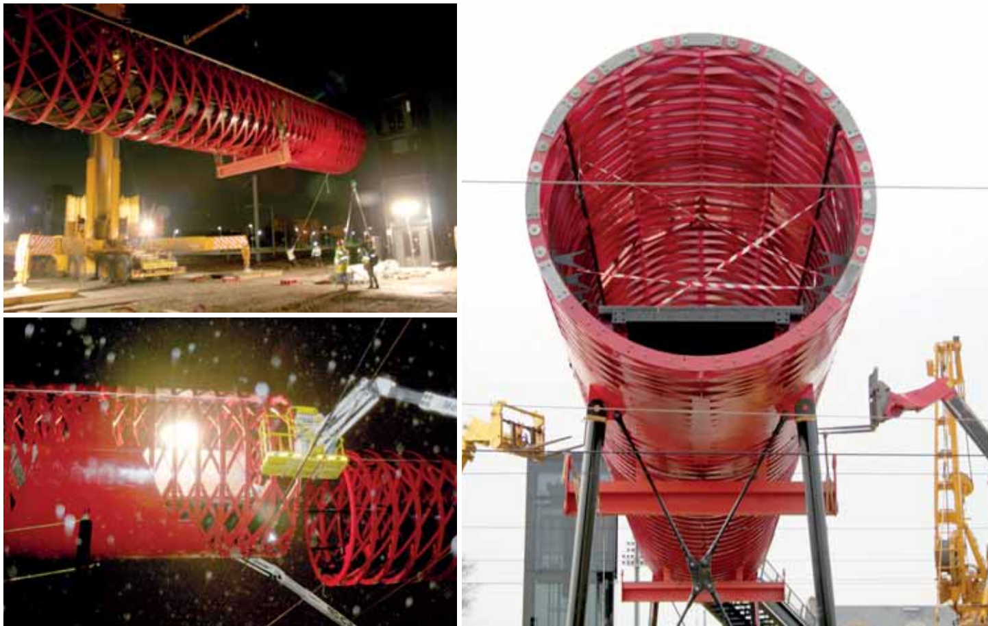
Fig. 17 – Viste della fase di sollevamento del tubo, della posa e dell'assemblaggio della passerella sulle coppie di pali sopra i binari ferroviari (©HDA)
