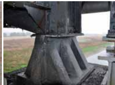
Fig. 9a - Ispezione visiva degli appoggi
