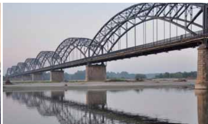
Fig. 4 - Ponte della Gerola sul Po oggi.
