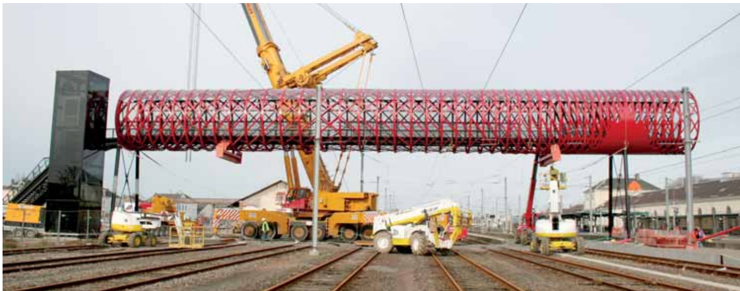
Fig. 18 – Vista del sollevamento per cui sono state posizionate e fissate barre trasversali provvisorie ai supporti di sollevamento, connesse tramite zoccoli di rinforzo locale e da sicurezza nella distribuzione delle forze. (©HDA)
