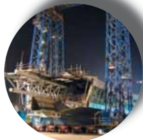
Vietnam, Sollevamento sezione centrale di un ponte con martinetti
