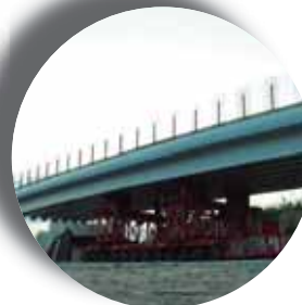
Installazione di un ponte da 500 ton con carrelli e martinetti
