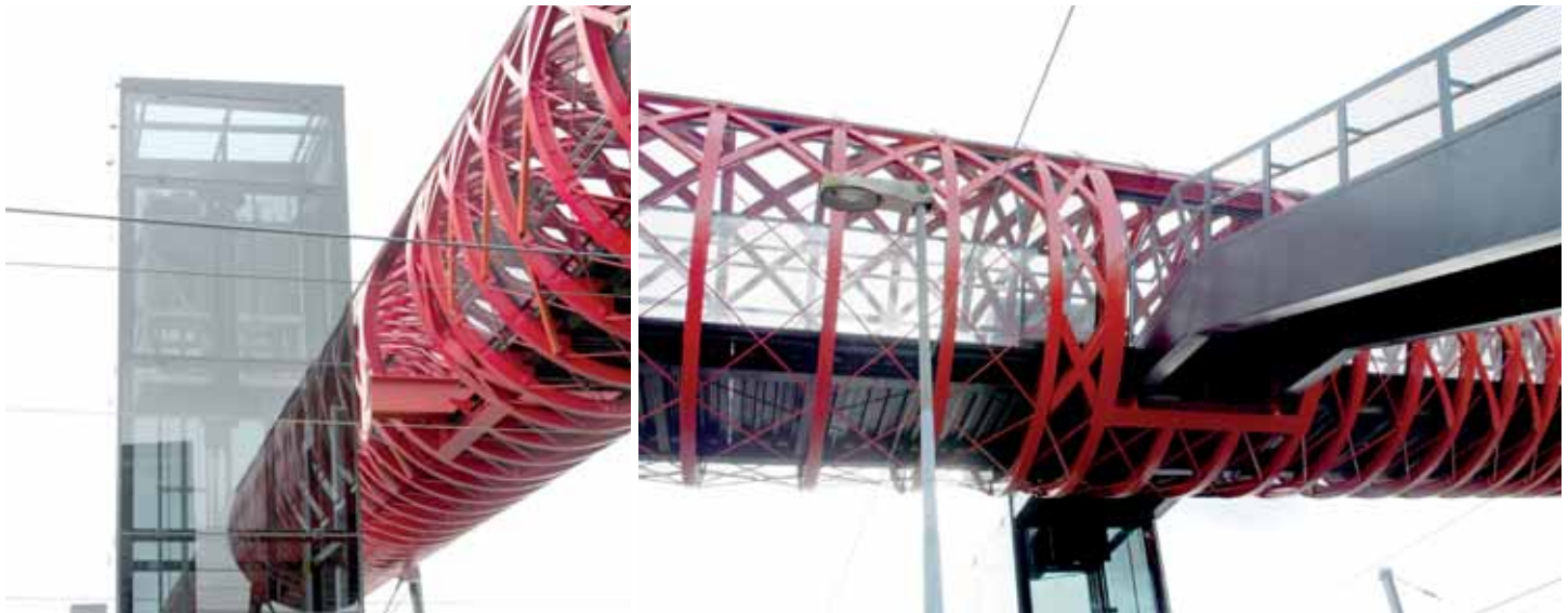
Fig. 19 – Fasi di collegamento della passerella con gli ascensori e le scale. (©HDA)
