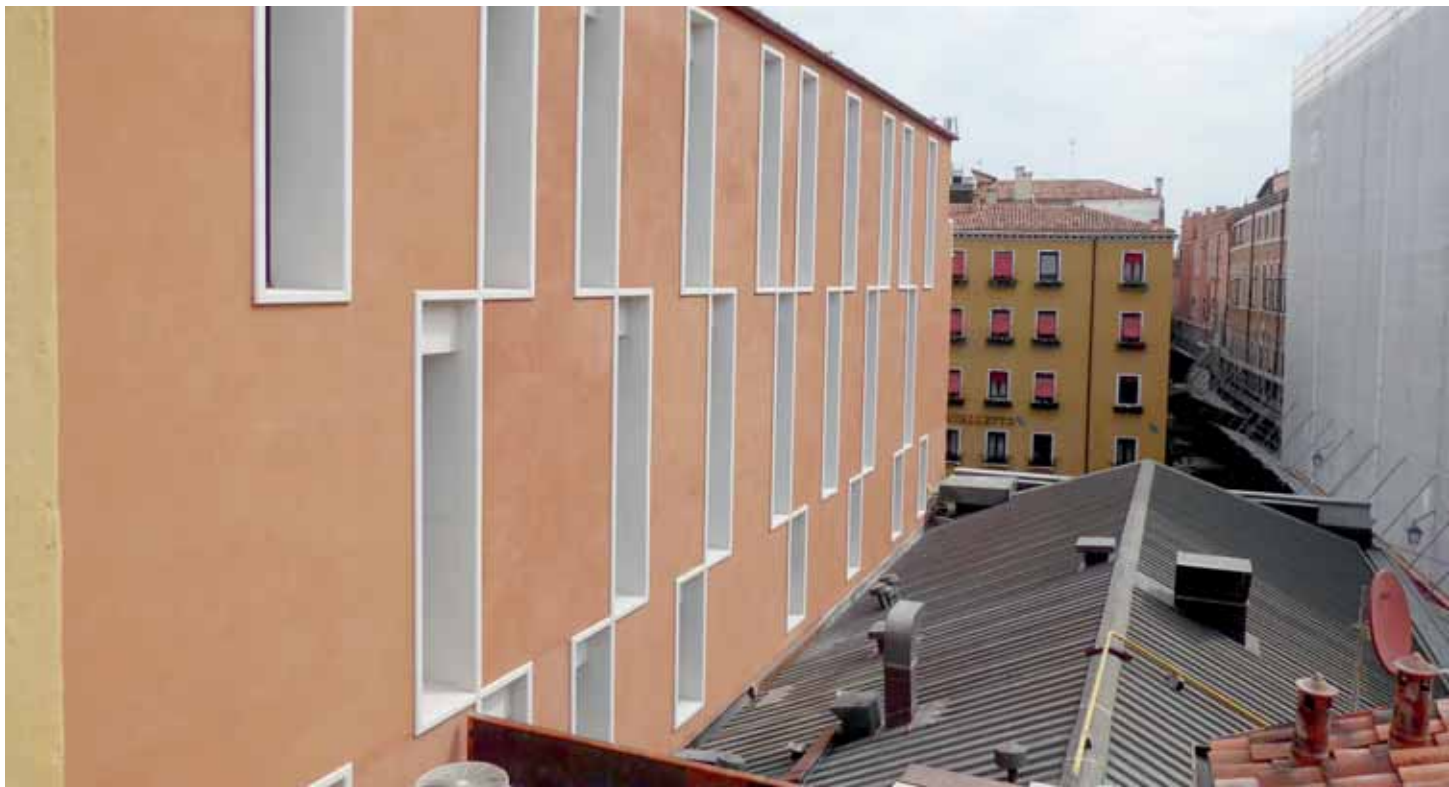
Facciata sud sopra Hard Rock Café ©Immagini gentilmente concesse da TA Architettura - Arch. Alberto Torsello
