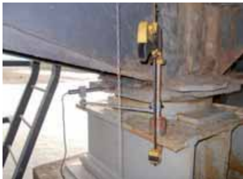
Fig. 7 - Prove di carico statico - Misura delle deflessioni e monitoraggio degli appoggi
