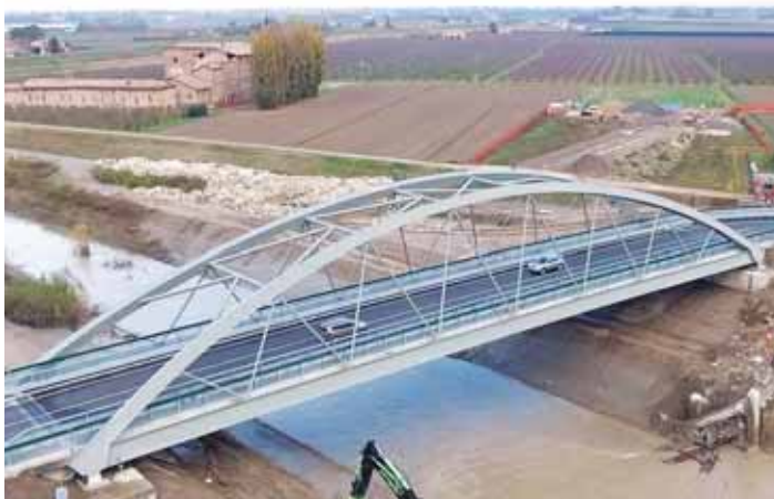
Fig. 26 - Ponte a traffico aperto
