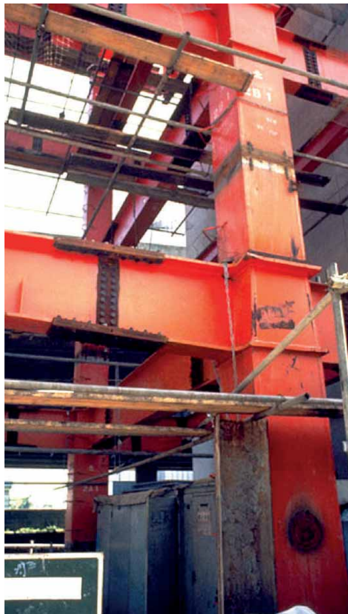
Fig. 29 – Giunto trave-colonna con moncone di trave saldato – particolare
