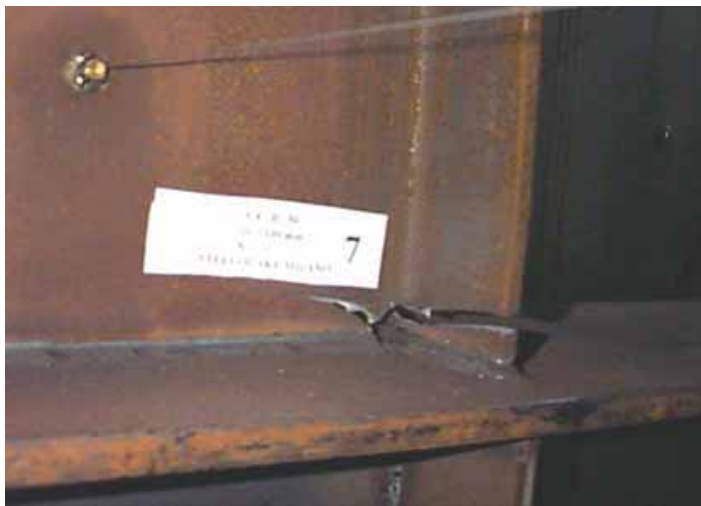
Fig. 15 - saldatura vista dall'interno. Collasso improvviso (sudden). La estensione delle rotture, visibile nella figura e nelle fig. 14 e 19, è dovuta al fatto che la prova porta a compimento il singolo ciclo iniziato.
