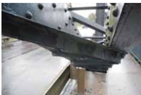
Fig. 13 - 14 - Prelievo di di talloni per prove di laboratorio
