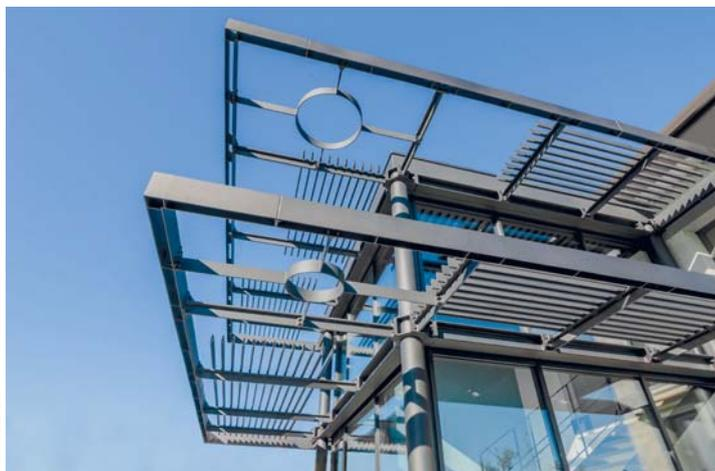
Fig. 20 - Smart Cube, vista laterale degli elementi di frangisole.
