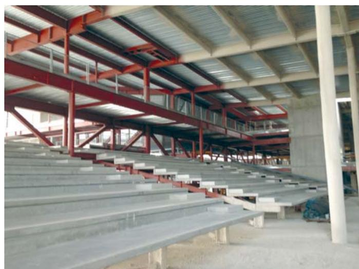
Fig. 14 – Struttura delle gradonate delle sale cinematografiche
