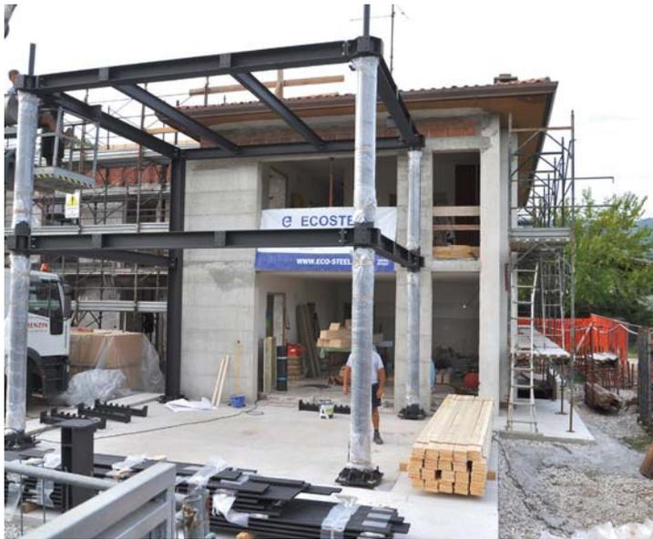
Fig.33 - Smart Cube, posa delle colonne a tutta altezza.
