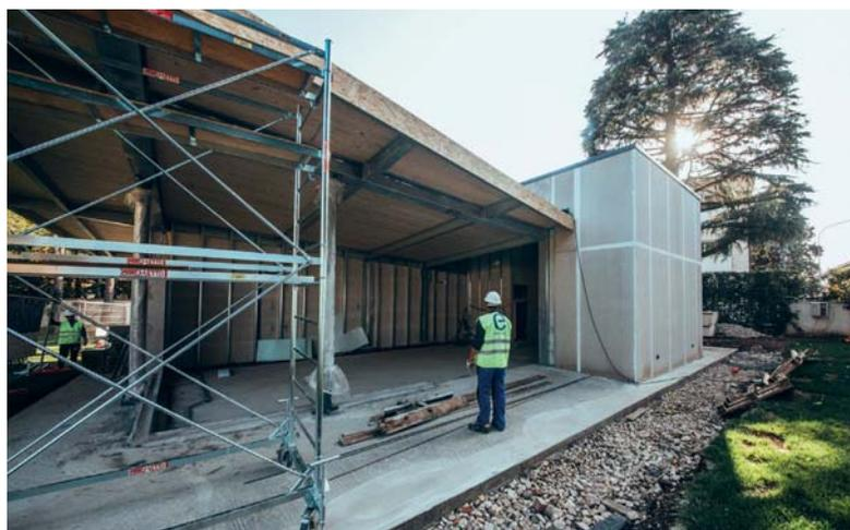
Fig. 5 - Blade House, utilizzo di struttura in acciaio e solaio in x-lam.
