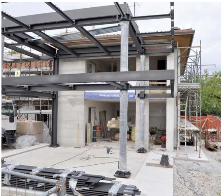
Fig.35 - Smart Cube, aggancio dei cordoli della struttura a sbalzo per frangisole.
