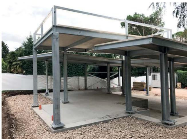
Fig. 6 - Blade House, struttura delle falde a diversa inclinazione.
