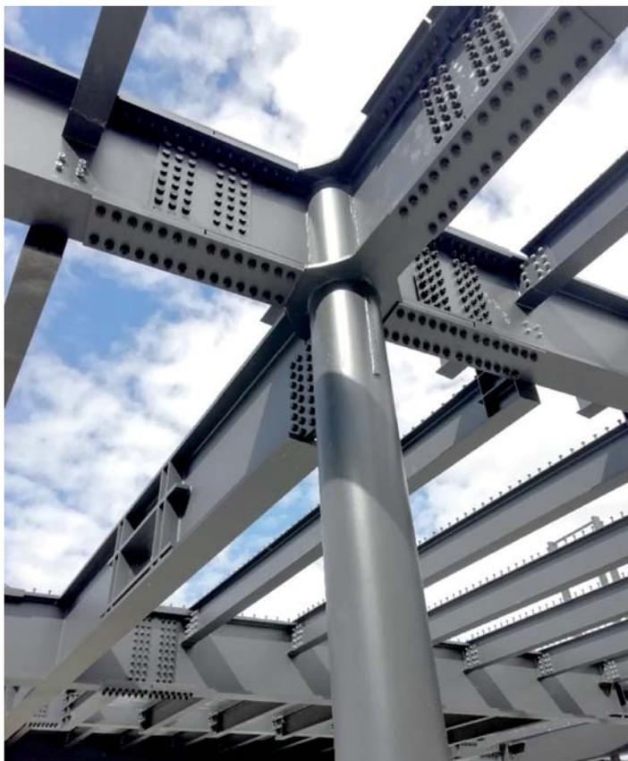
Fig. 4 - Dettaglio nodo travi principali - pilastri
