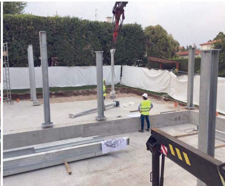
Fig.10 - Blade House, posa delle colonne.
