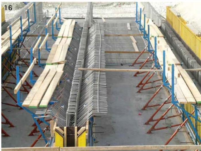
Fig. 17: La Perla del Qatar. Particolare delle barre ad aderenza migliorata in acciaio inossidabile EN 1.4436 (AISI 316L). Fig. 18: La Perla del Qatar. L'opera ha visto l'impiego di più di 2.000 t di barre in acciaio inox.
