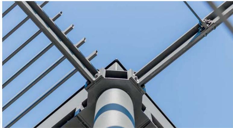
Fig.28 - Smart Cube, nodo di aggancio tra colonna e travi in copertura.
