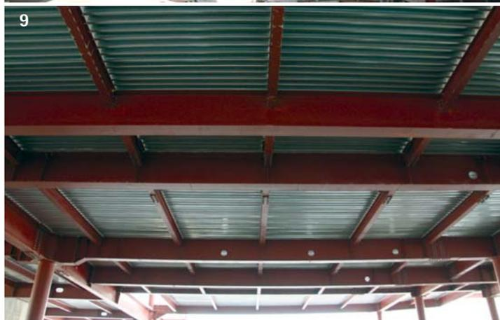
Fig. 7 – Vista di parte della struttura principale. Fig. 8 – Vista di parte della struttura principale con inserimento centine del lucernario centrale Fig. 9 – Vista impalcato composito in acciaio calcestruzzo realizzato con getto su lamiere grecate
