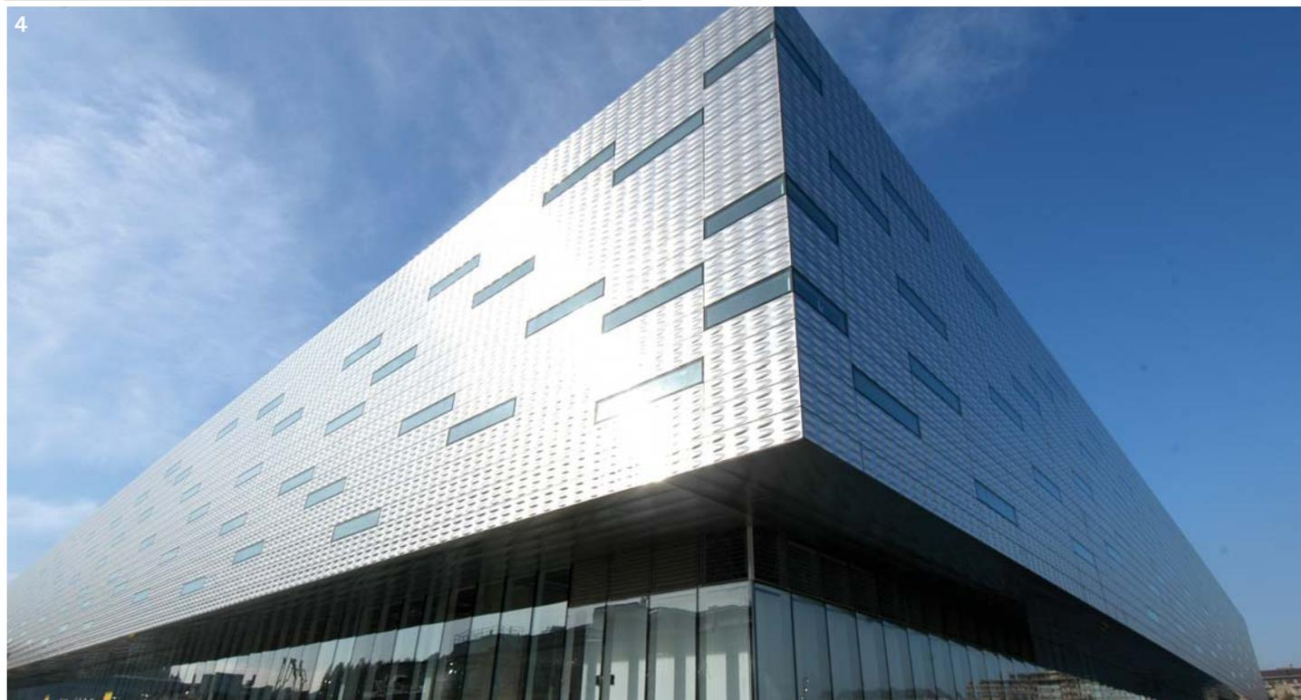
Fig. 3 - Palasport Olimpico di Torino. Oltre 2.000 pannelli in lamiera di acciaio inossidabile EN 1.4404 (AISI 316L) sono stati utilizzati per il rivestimento del volume superiore dell'impianto polifunzionale coperto di Torino. Fig. 4 - Palasport Olimpico di Torino. Le lamiere in inox sono caratterizzate da bugnature ellittiche.
