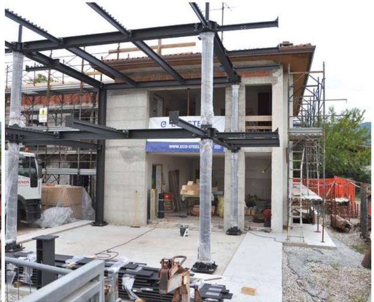
Fig.34 - Smart Cube, aggancio delle travi a T supporto frangisole.
