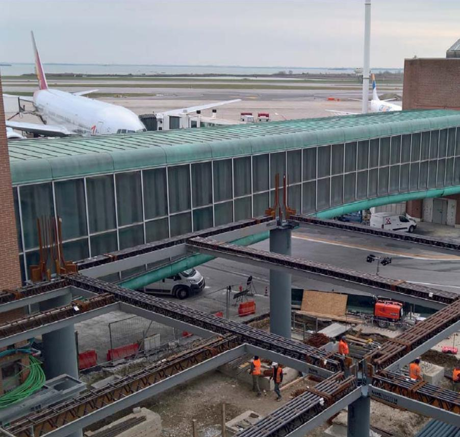
Travi e pilastri NPS<sup>®</sup> a struttura mista acciaio-calcestruzzo scelti perché in grado di garantire :
