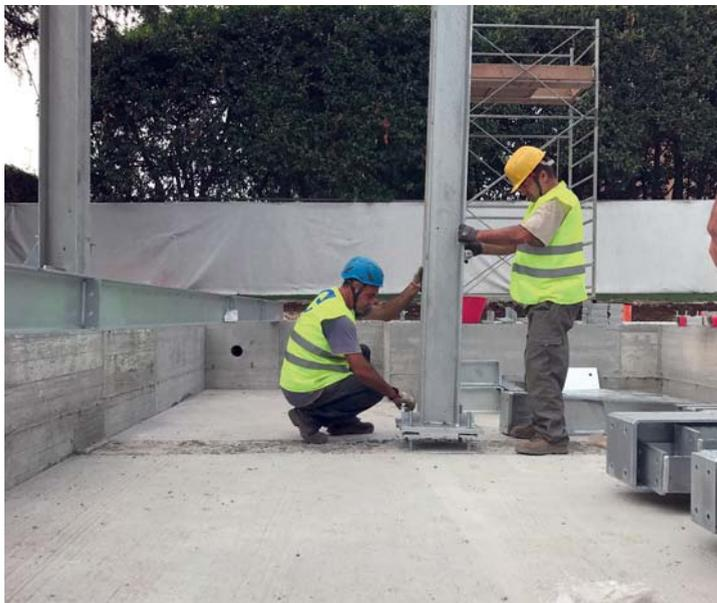
Fig.9 - Blade House, posa delle colonne.
