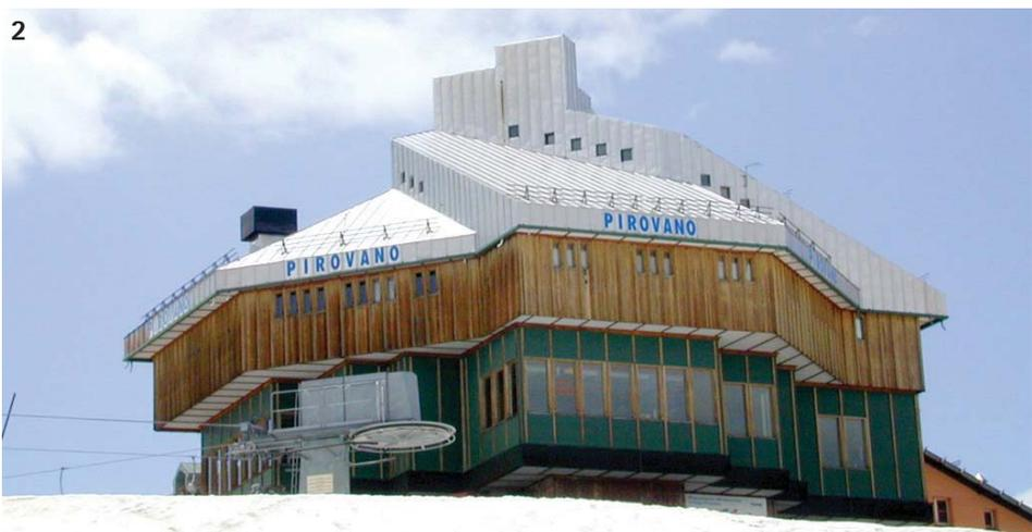
Fig. 1 - Chrysler Building. Per il rivestimento della sua sommità è stato impiegato l'acciaio inox AISI 302. Fig. 2: Hotel Pirovano. La copertura del tetto e dei piani superiori dell'hotel è in acciaio inossidabile EN 1.4301 (AISI 304).
