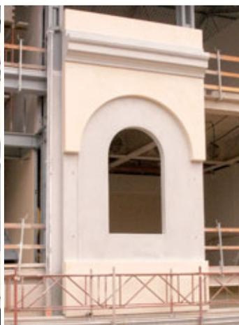
Fig. 29 - Montaggio di un pannello prefabbricato in grc.
