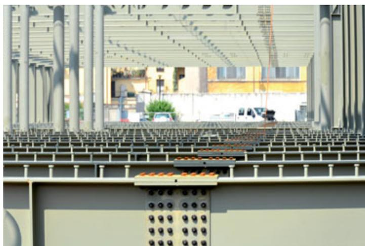
Fig. 22 – Dettaglio delle le travi principali con i pioli di collegamento dei solai.
