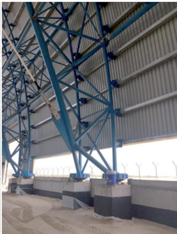
Fig. 10 - Dettaglio dell'imposta degli archi
