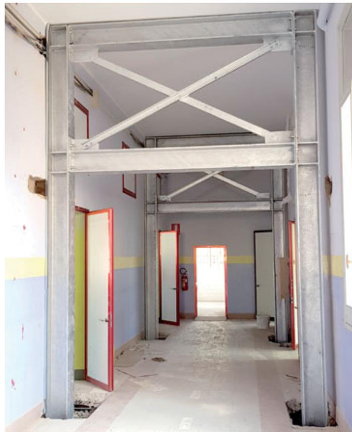
Fig. 15 - Telai controventanti montanti in cantiere.
