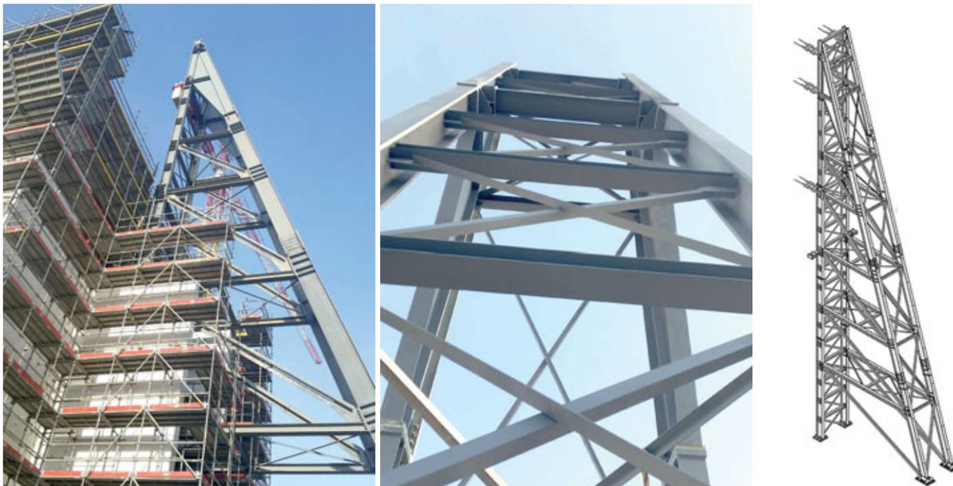
Fig. 6 - Immagini della struttura provvisoria in carpenteria metallica messa in opera e 3D della stessa
