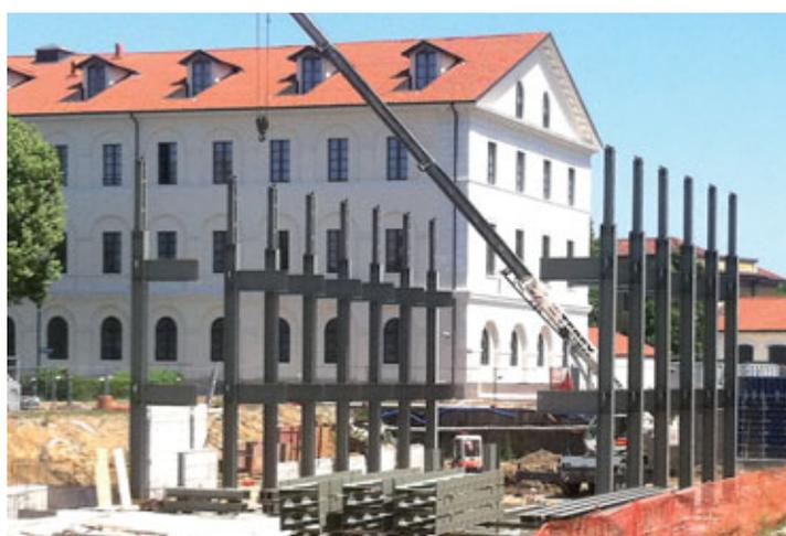
Fig. 23 – Montaggio delle colonne ad altezza di piano.
