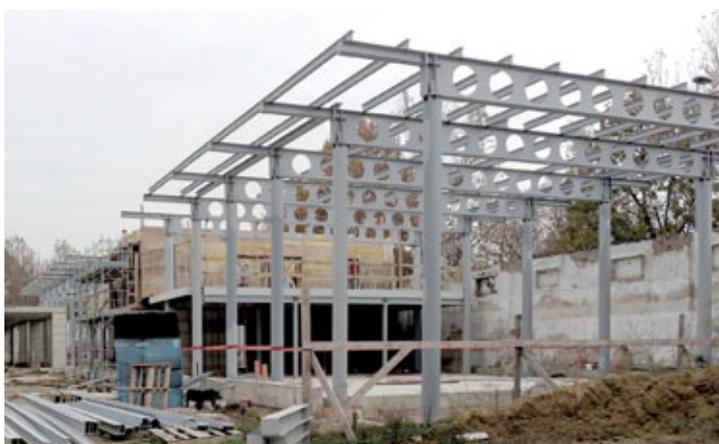
Fig. 34 - Montaggio della carpenteria.
