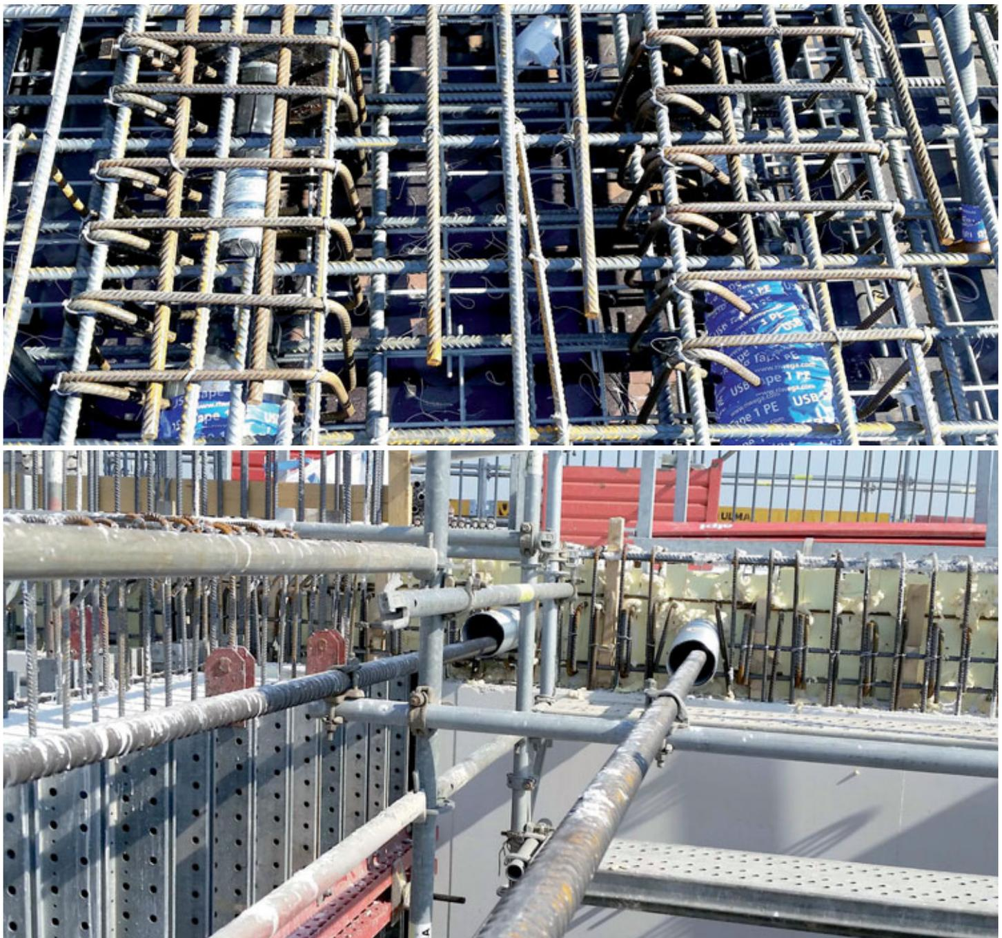
Fig. 10 - Testate passive di una coppia di barre dywidag (sopra). Barre dywidag uscenti dal solaio gettato in opera per collegamento con traliccio (sotto).
