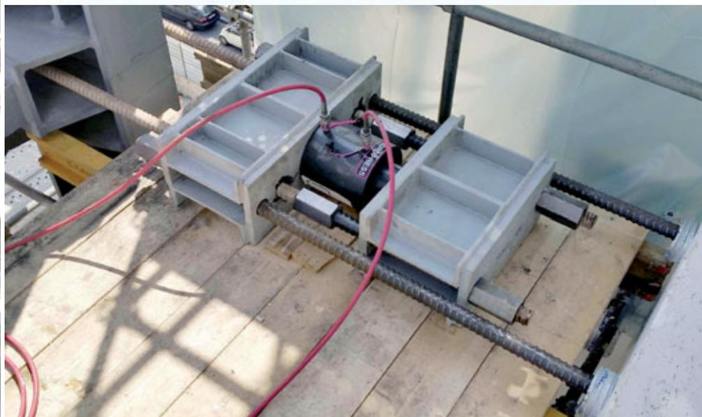
Fig. 7 - Alcuni nodi della struttura provvisoria Fig. 8 - Sistema per il tensionamento delle barre dywidag annegate sul solaio in c.a. della torre in carpenteria metallica
