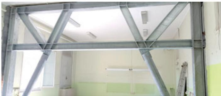
Fig. 14 - Telai controventanti montanti in cantiere.
