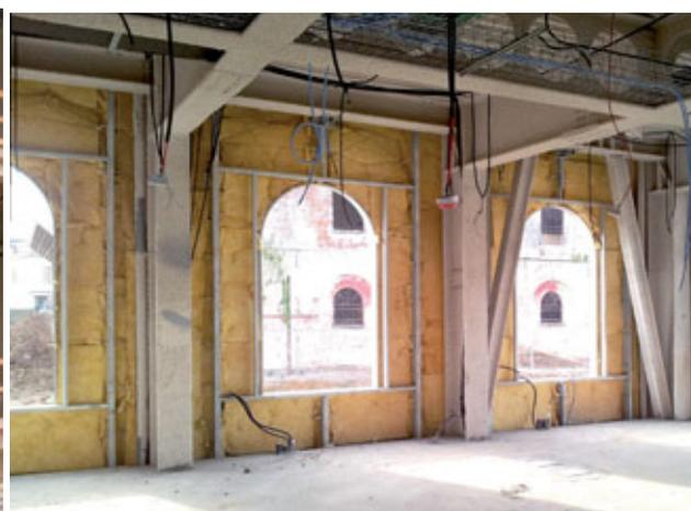
Fig. 30 - Completamento del tamponamento del piano rialzato.
