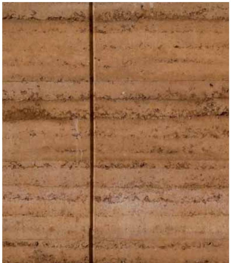
Fig. 23 – Dettaglio della linea di induzione delle fessurazioni delle murature in pisé. © Massimiliano Milan
