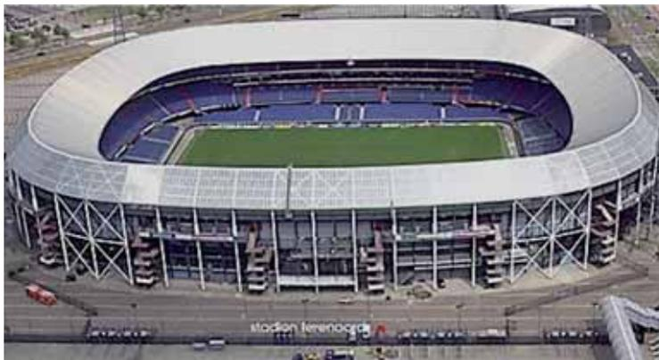
Fig. 3 - Il Feijenoord Stadion, di Rotterdam, soprannominato de Kuip (La tinozza). 65.000 spettatori. Copertura a due falde. Copre solo le tribune alte. È visibile la macchina per la manutenzione. Nel 2014 il Feyenoord ha deciso di rinnovare lo stadio portandolo a 70.000 posti, con una copertura rimovibile. Nel 2020 il progetto è stato abbandonato.
