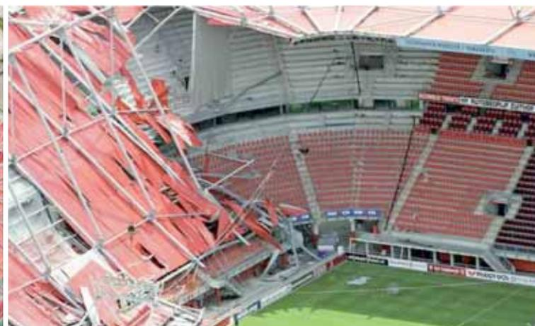
Fig. 5 - Il 7 luglio 2011 è crollata una parte del tetto dello stadio mentre era in fase di ristrutturazione. La struttura, nella configurazione finale, era redundant. Tuttavia nel corso della costruzione, parti della struttura erano in condizioni di mensola pressoché isostatica. La redundancy è bene sia presente prevedendo anche le fasi temporanee di costruzione.
