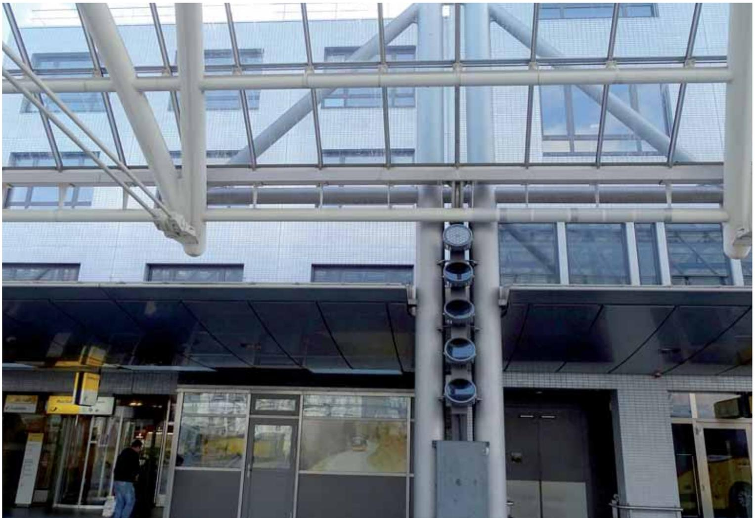
Fig. 14 - Stazione degli Auto-postali di Coira - Colonne principali di sostegno
