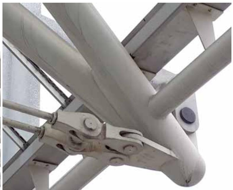
Fig. 15 - Stazione degli Auto-postali di Coira - Dettaglio di appensione degli archi ai montanti principali
