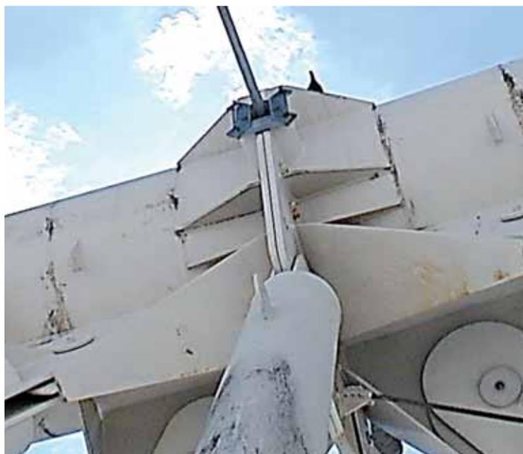
Fig. 8 - Piccione in vista in prossimità alla sede dell'ancoraggio di una fune portante. Nel tempo le sedi sono divenute nidi di piccioni.
