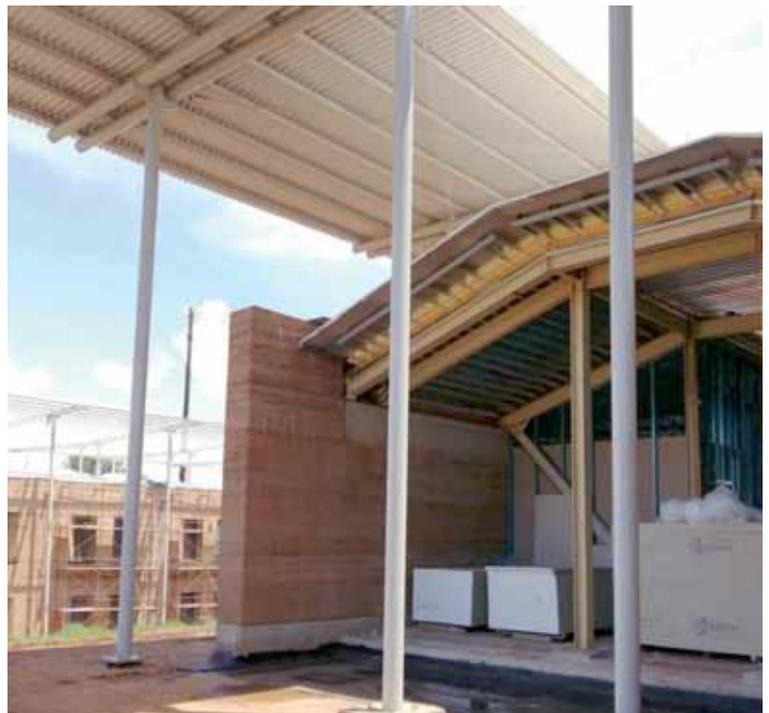
Fig. 44– Vista dell'intradosso del sistema di ombreggiamento dell'ala sud in corrispondenza del fronte ovest. © Emergency NGO Technical Department
