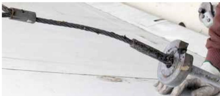
Fig. 10 - Tirante privo di corrosione a destra, e pressoché corrosivo nel tratto a sinistra. Il tirante, fatto di fili di diametro di pochi mm, è particolarmente sensibile alla corrosione. Sono stati sostituiti con tiranti in acciaio inox.
