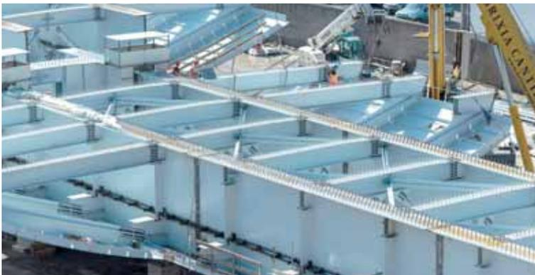
Fig. 10 - Assemblaggio delle travi principali superiori ai fondi e collegamento ai traversi.
