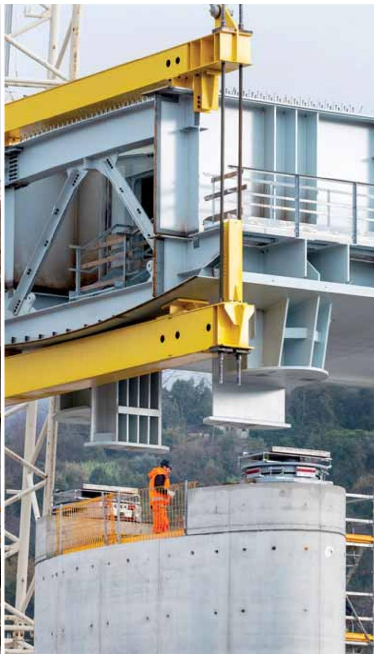
Fig. 2 - Posizionamento dell'impalcato sugli appoggi definitivi.
