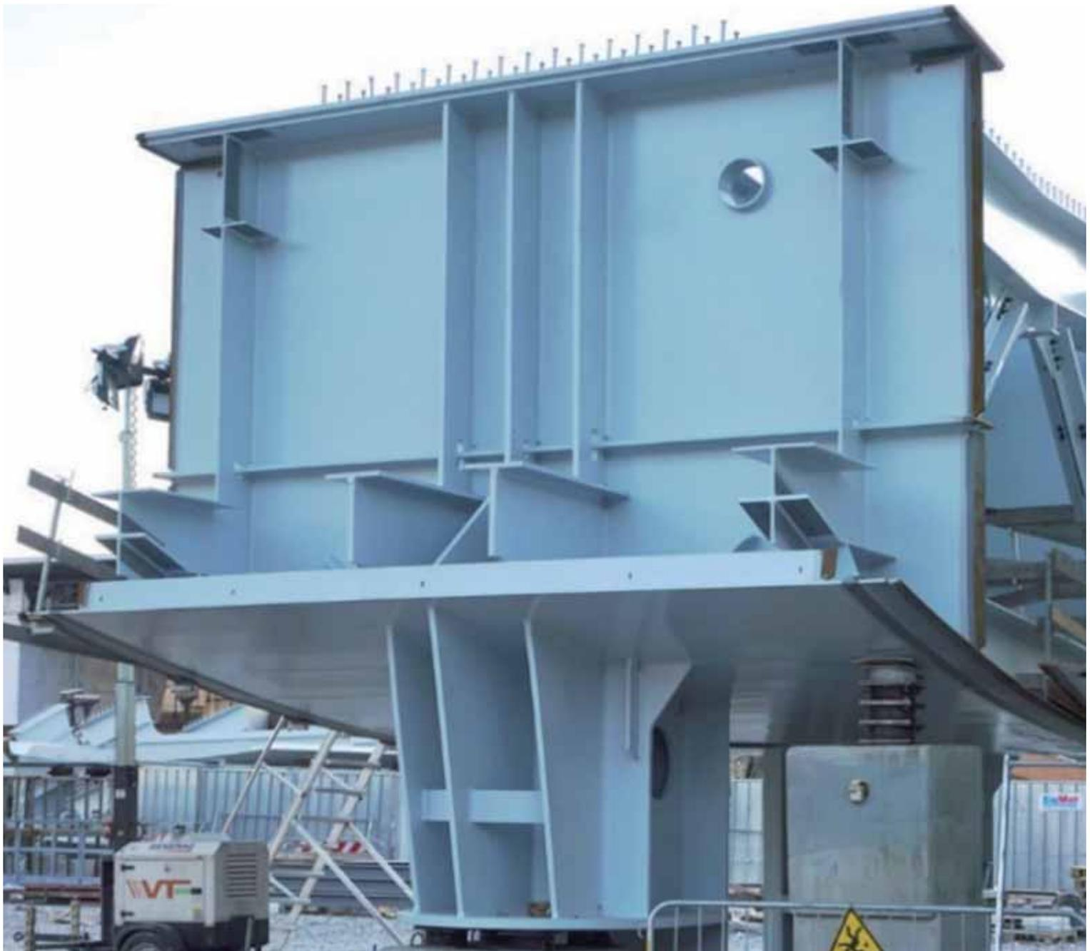
Fig. 8 – Concio di pila con gambe saldate
