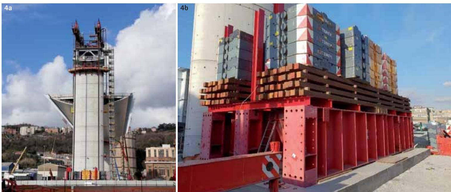
Fig. 4 – Sistema di bilanciamento di un concio di pila e contrappeso
