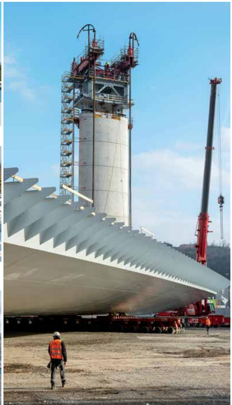
Fig. 12 - Spostamento con carrelli SPMT di una campata da 100 m.
