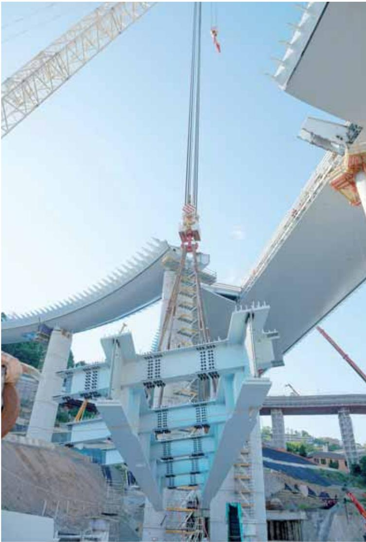
Fig. 25 - Sollevamento struttura di innesto della Rampa.
