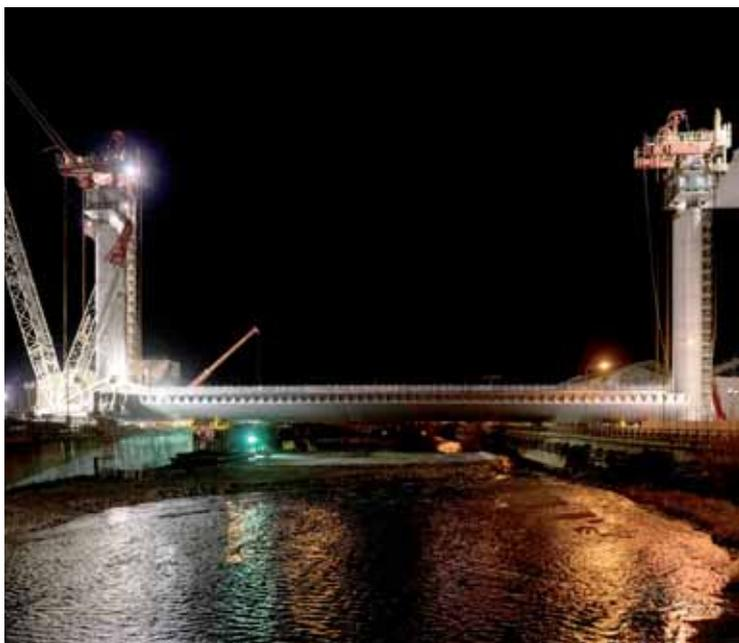
Fig. 24 - Campata da 100 m sopra il fiume Polcevera pronta per il sollevamento.
