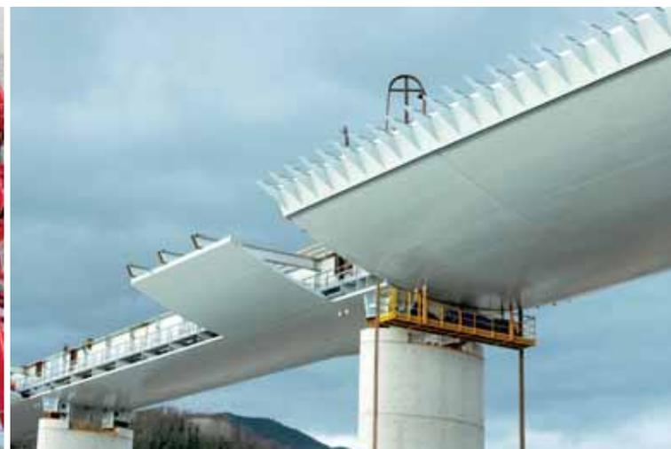
Fig. 4 - Struttura di bordo portante.
