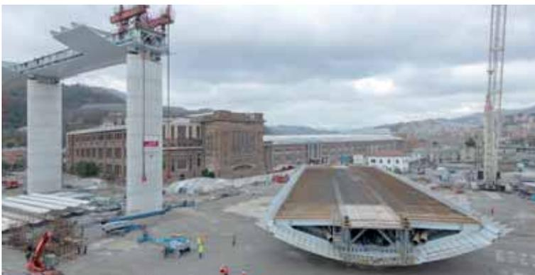
Fig. 11 - Spostamento con carrelli SPMT di una campata da 100 m.
