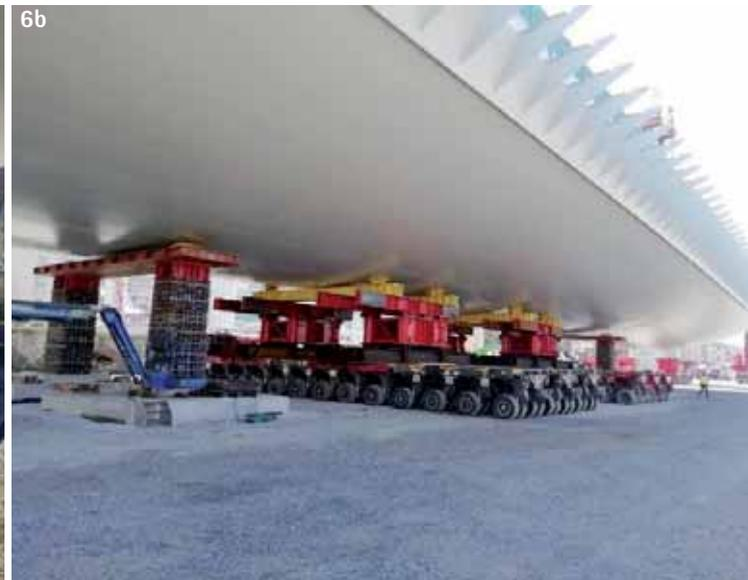
Fig. 6 – Sollevamento di 5 m dell’impalcato e inserimento dei mezzi di trasporto
