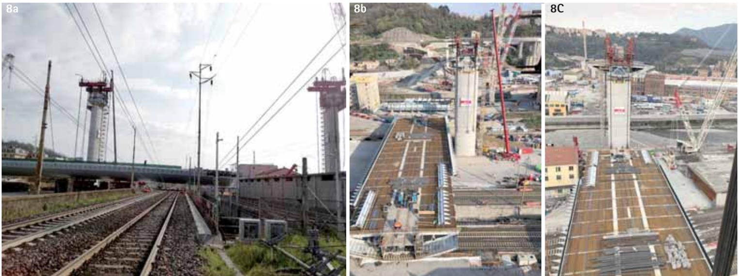
Fig. 8 – Movimentazione dell'impalcato di 100 m in corrispondenza della Ferrovia
