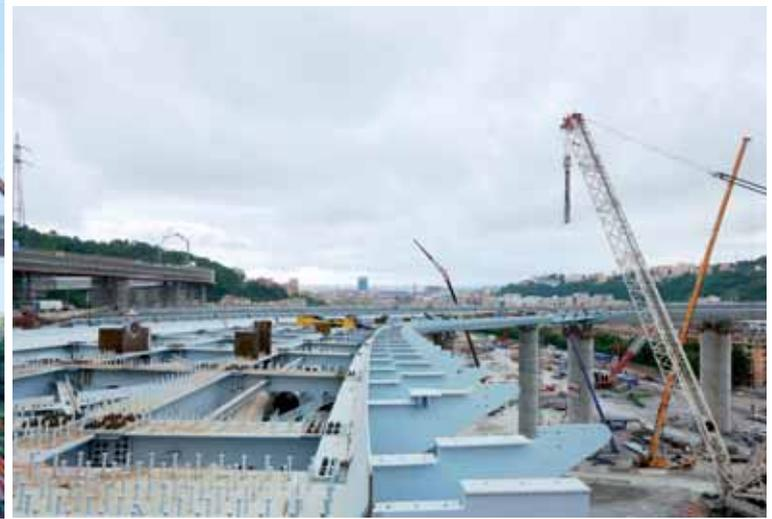
Fig. 27 - Sollevamento e completamento della Rampa.
