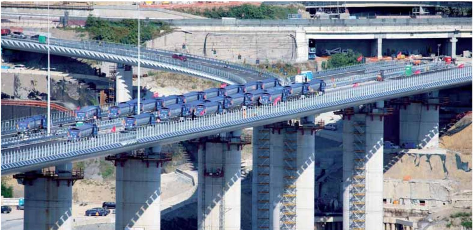
Fig. 28 - Prove di carico durante il collaudo dell'opera.
