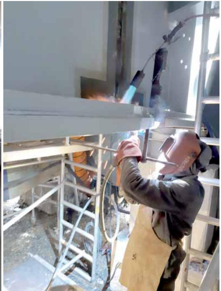
Fig. 40 - Mantenimento del preriscaldamento durante la saldatura
