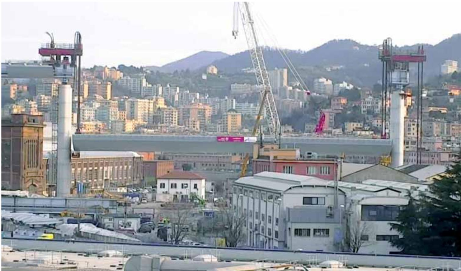
Fig. 2 – Sollevamento di una campata L=100 m tipica con Strand Jack System
