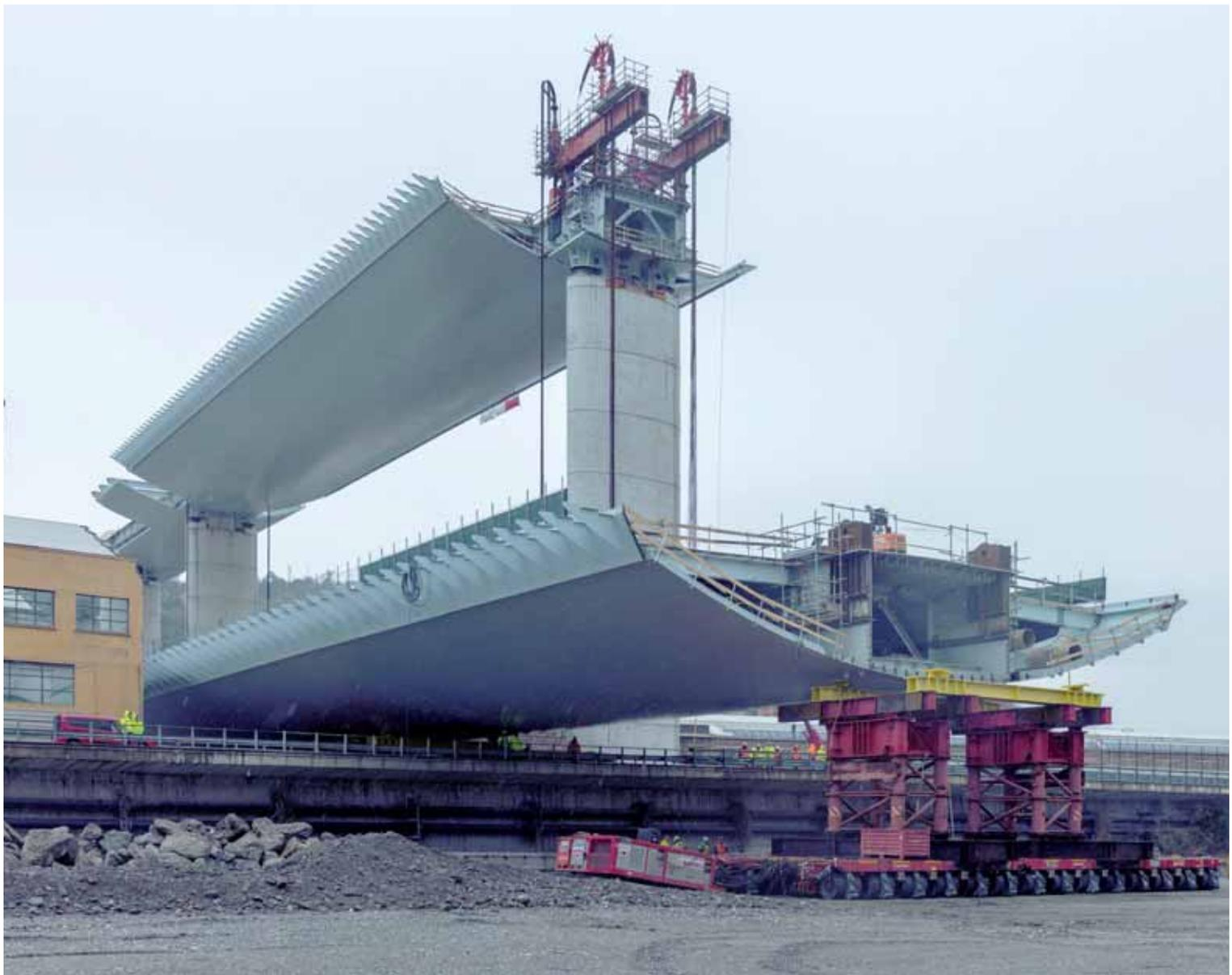
Fig. 23 - Presa in carico della campata con carrelli SPMT in alveo del Polcevera.
