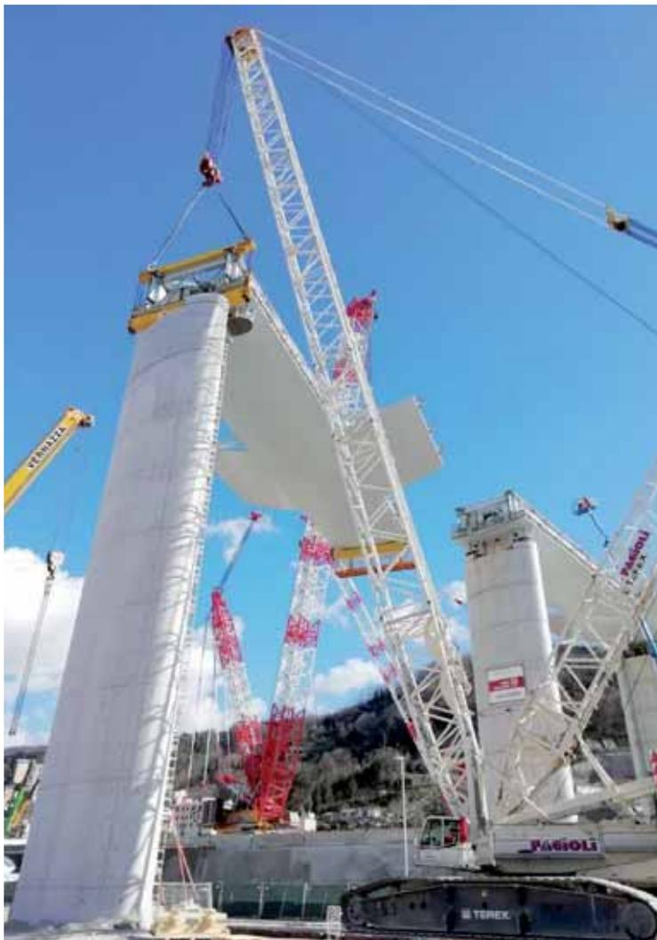
Fig. 9 – Sollevamento tipico in tandem della campata da 50 m
