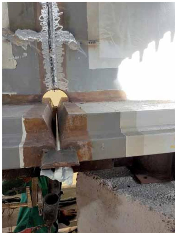
Fig. 9 - Applicazione di supporto ceramico su un cianfrino ad "X"
