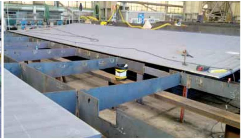
Fig. 19 - Assemblaggio sulle selle
