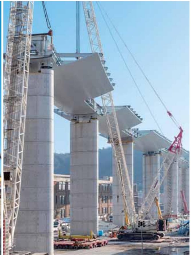
Fig. 17 - Sollevamento in tandem della campata fra le pile 3 e 4.
