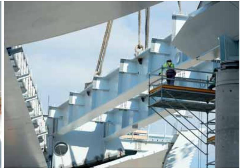
Fig. 26 - Sollevamento collegamento della struttura di innesto al ponte.
