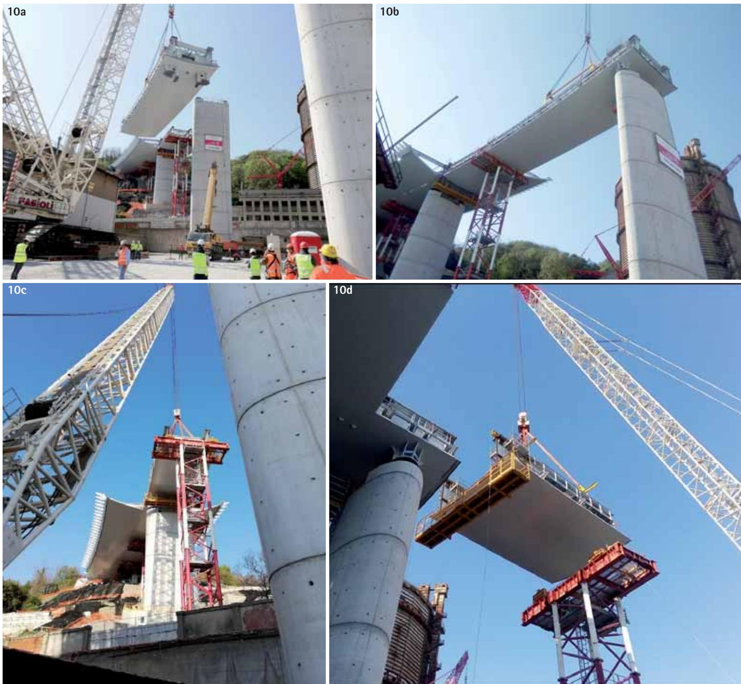
Fig. 10 – Sollevamento tipico in singola di un conco con l'ausilio di torri temporanee
