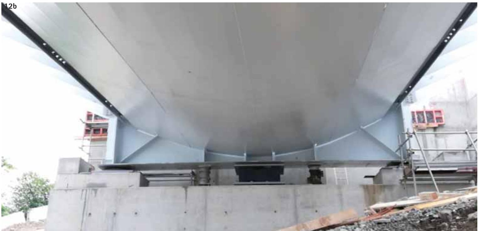
Fig. 12 – Intradosso impalcato rampa e diaframma di spalla rampa
