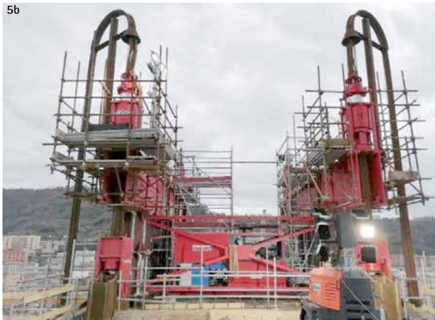
Fig. 5 – Strutture temporanee di supporto alla Macchina di Sollevamento “strand jack system”
