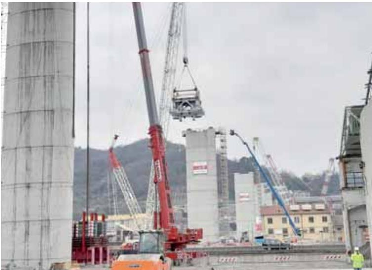
Fig. 35 - Posizionamento concio di pila
