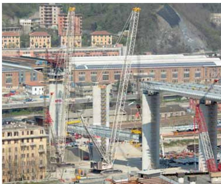
Fig. 14 - Sollevamento in tandem della campata fra le pile 12 e 13 (1 di 2).
