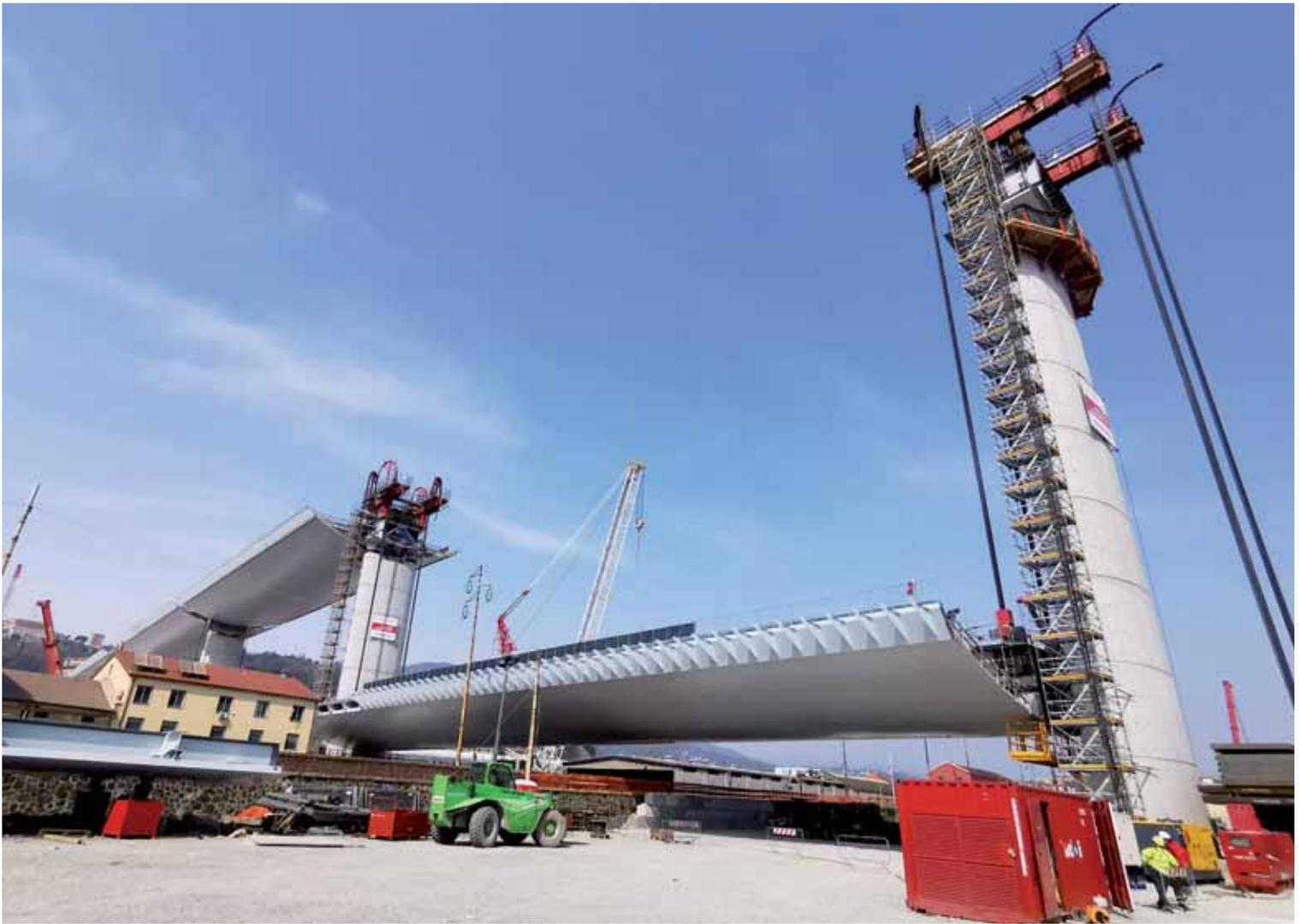
Fig. 21 - Campata da 100 m sopra la ferrovia pronta per il sollevamento.
