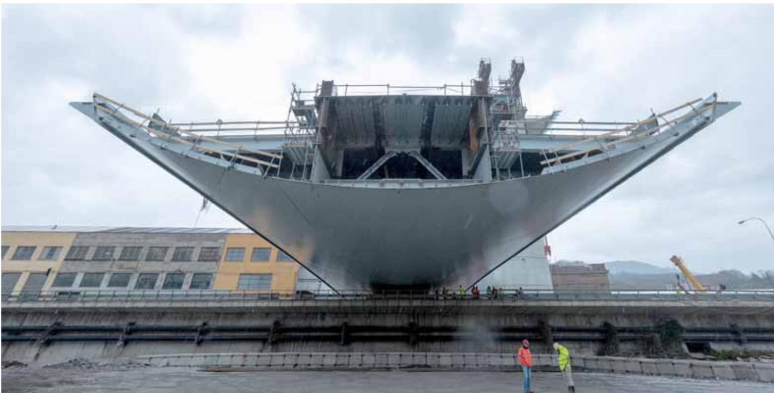
Fig. 22 - Campata da 100 m a sbalzo sul fiume Polcevera durante la movimentazione.
