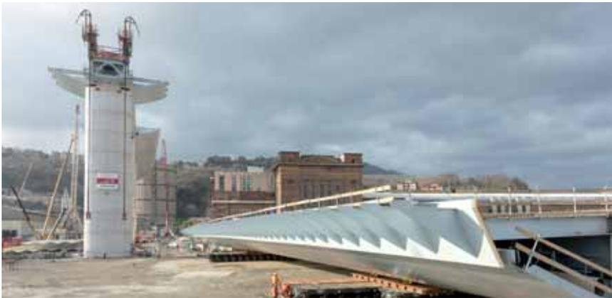
Fig. 18 - Spostamento con SPMT di una campata da 100 m e attrezzatura per sollevamento con Strand - Jack.
