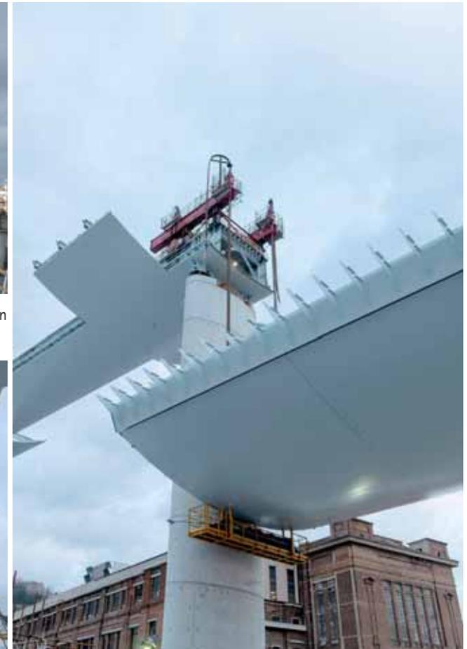
Fig. 20 - Fase di sollevamento della campata da 100m fra le pile 8 e 9 (2 di 2).
