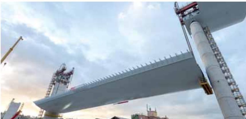
Fig. 19 - Fase di sollevamento della campata da 100m fra le pile 8 e 9 (1 di 2).
