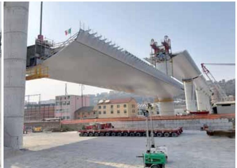
Fig. 36 - Sollevamento della campata da 100 m con "strand jacks"
