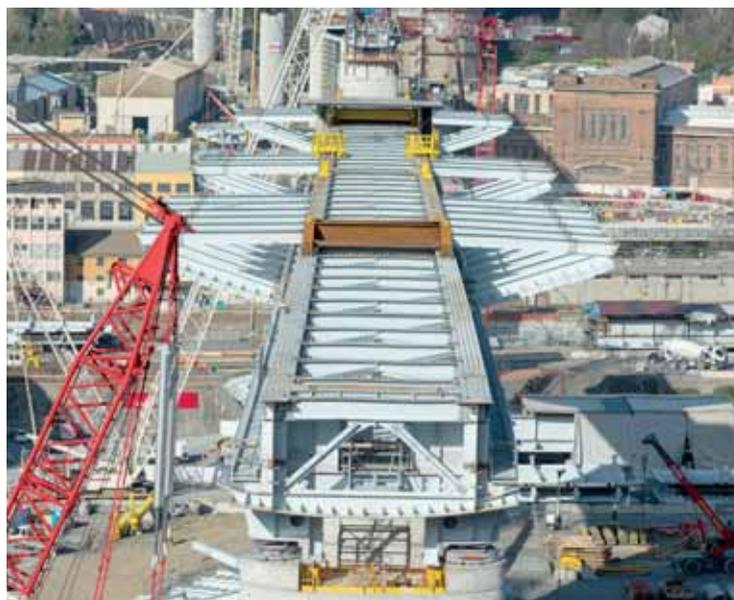
Fig. 13 - Quattro campate in quota lato Levante montate in sequenza.
