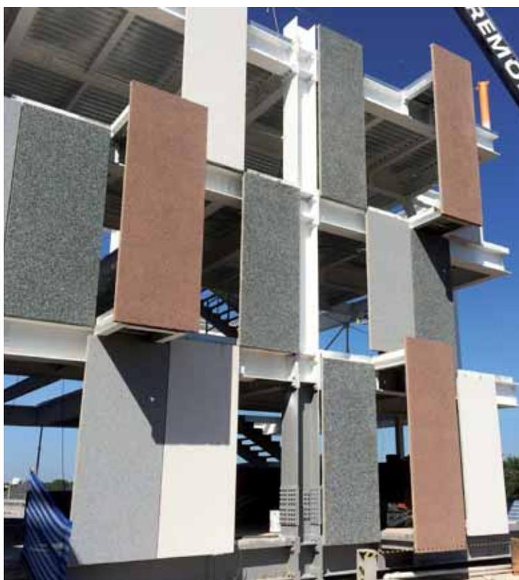
Fig. 16 - Vista della fase di assemblaggio in cantiere dei pannelli cementizi
