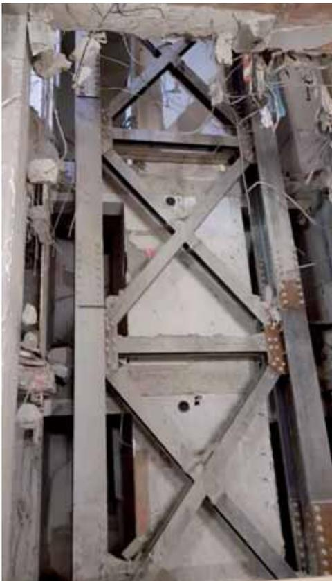
Foto h. Completamento montaggio controvento transfer lato galleria attraverso demolizione locale solai esistenti
