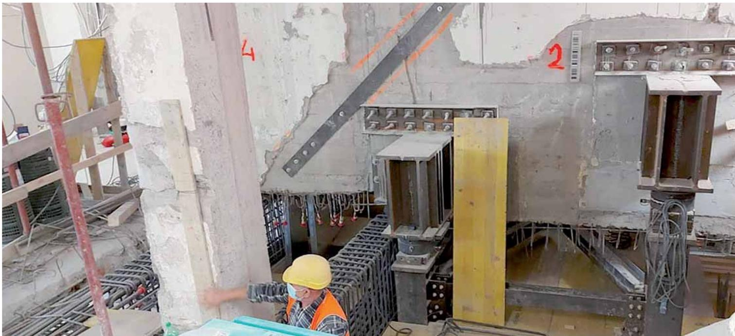
Foto o. Fasi finali prima del CHK B – Posa armature travi ad arco e solettone.
