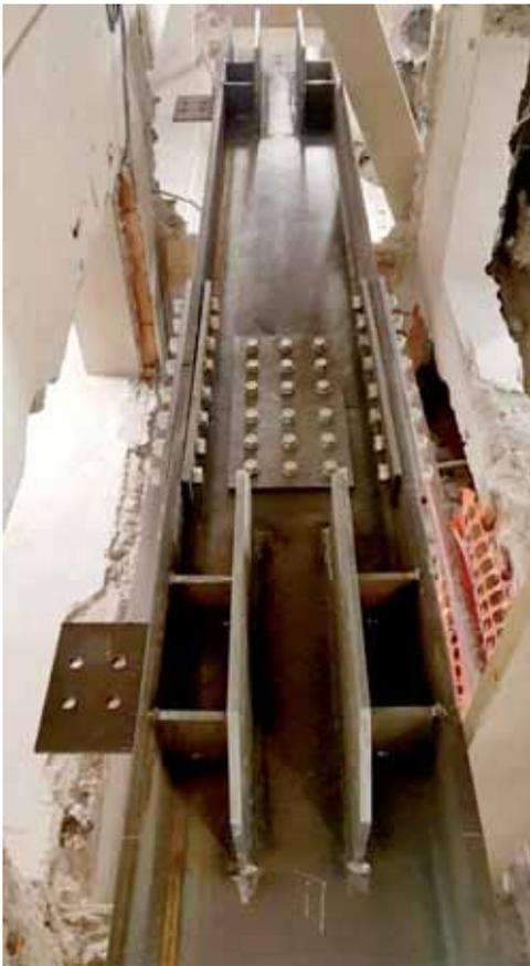
Foto e. Particolare elevazione colonna con copri-giunti d'ala e d'anima e nodi di attacco dei controventi di parete. Demolizioni locali per consentire il calo e l'assemblaggio dei conci.
