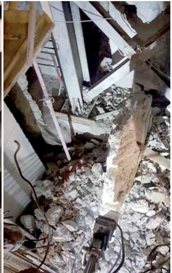
Foto g. Particolare demolizione cono di base del cavedio tecnico in c.a. esistente a lato della fondazione provvisoria.
