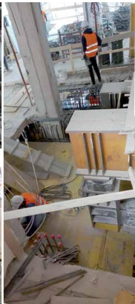
Foto c. Casseri solaio di trasferimento definitivo in c.a.
