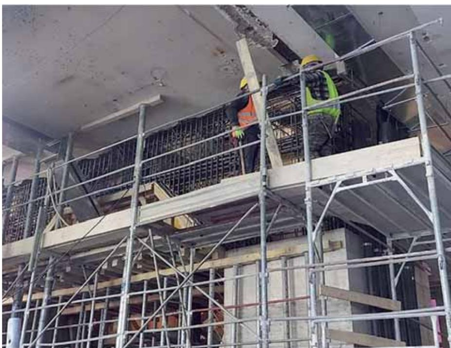
Foto o bis. Fasi finali prima del CHK B – Posa armature travi ad arco e solettone.
