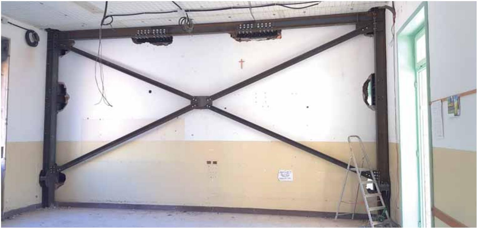
Fig. 9 – Controventatura al piano terra
