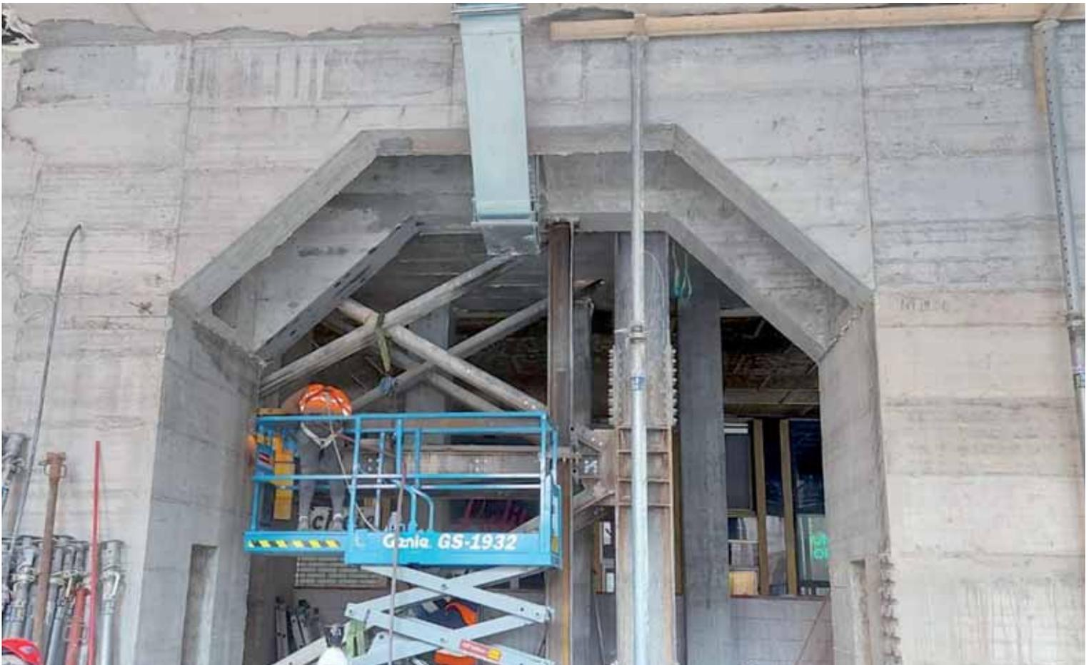
Foto m. Smontaggio transfer metallico a maturazione raggiunta strutture definitive in c.a.
