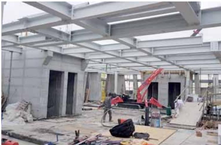
Foto d. Alcune fasi di montaggio della struttura in carpenteria metallica della copertura
