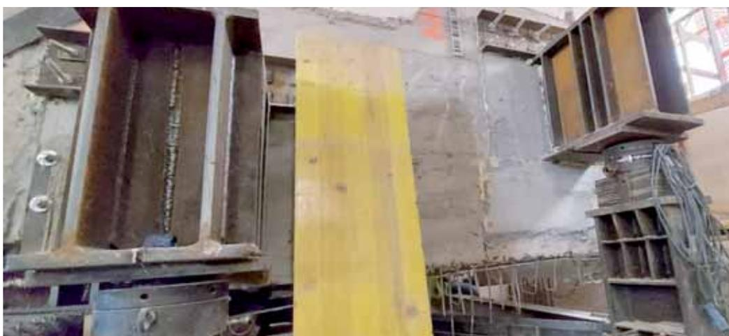
Foto b. Travi metalliche innestate ai muri, in contrasto sui martinetti idraulici.
