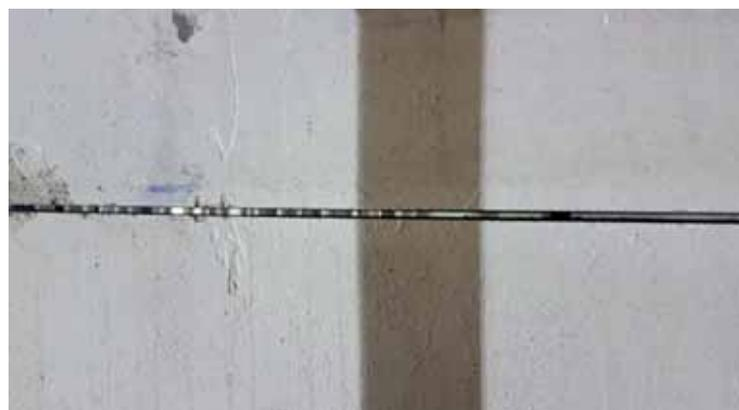
Foto n. Fase del CHK A – Taglio a disco verificato con distacco completo dei muri portanti della scala.
