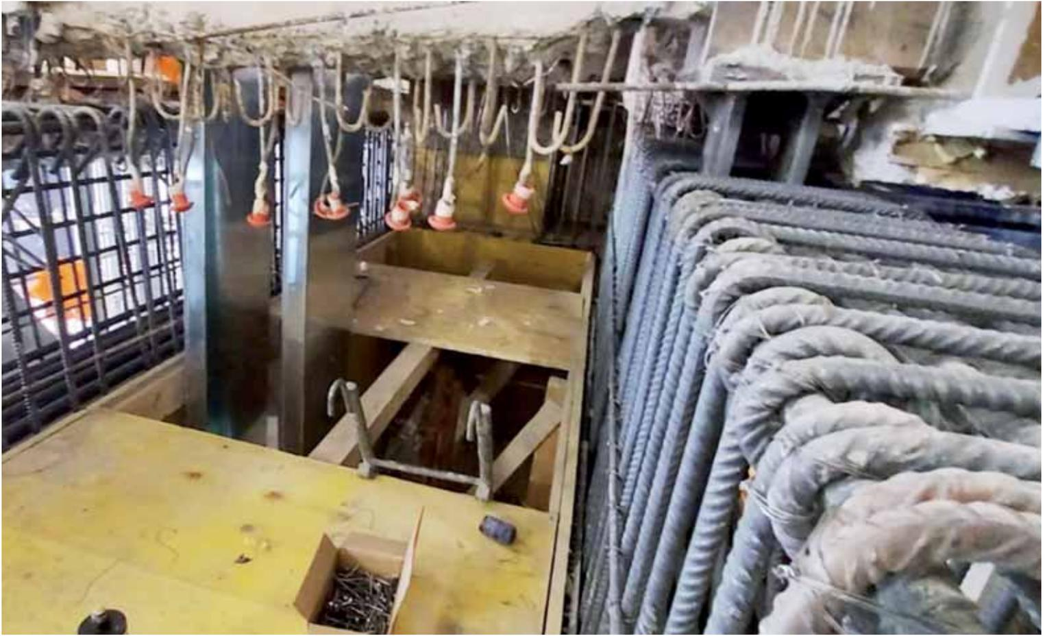
Foto l. Particolare ripresa armature muri esistenti e posa armature travi in c.a.
