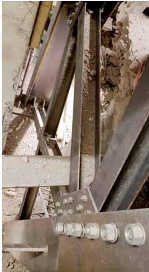
Foto f. Fase di montaggio e imbastimento del 1° cono, controvento del sistema transfer lato galleria.
