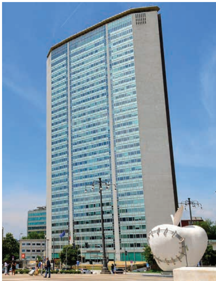
Fig. 2 | Grattacielo Pirelli (Milano): costruzione 1959, facciata in alluminio anodizzato [1].
