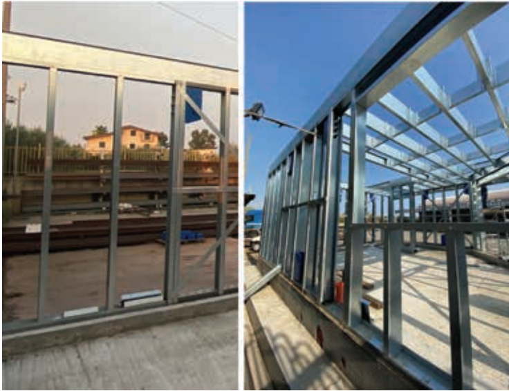
Fig. 19: Dettaglio delle pareti gravitazionali
