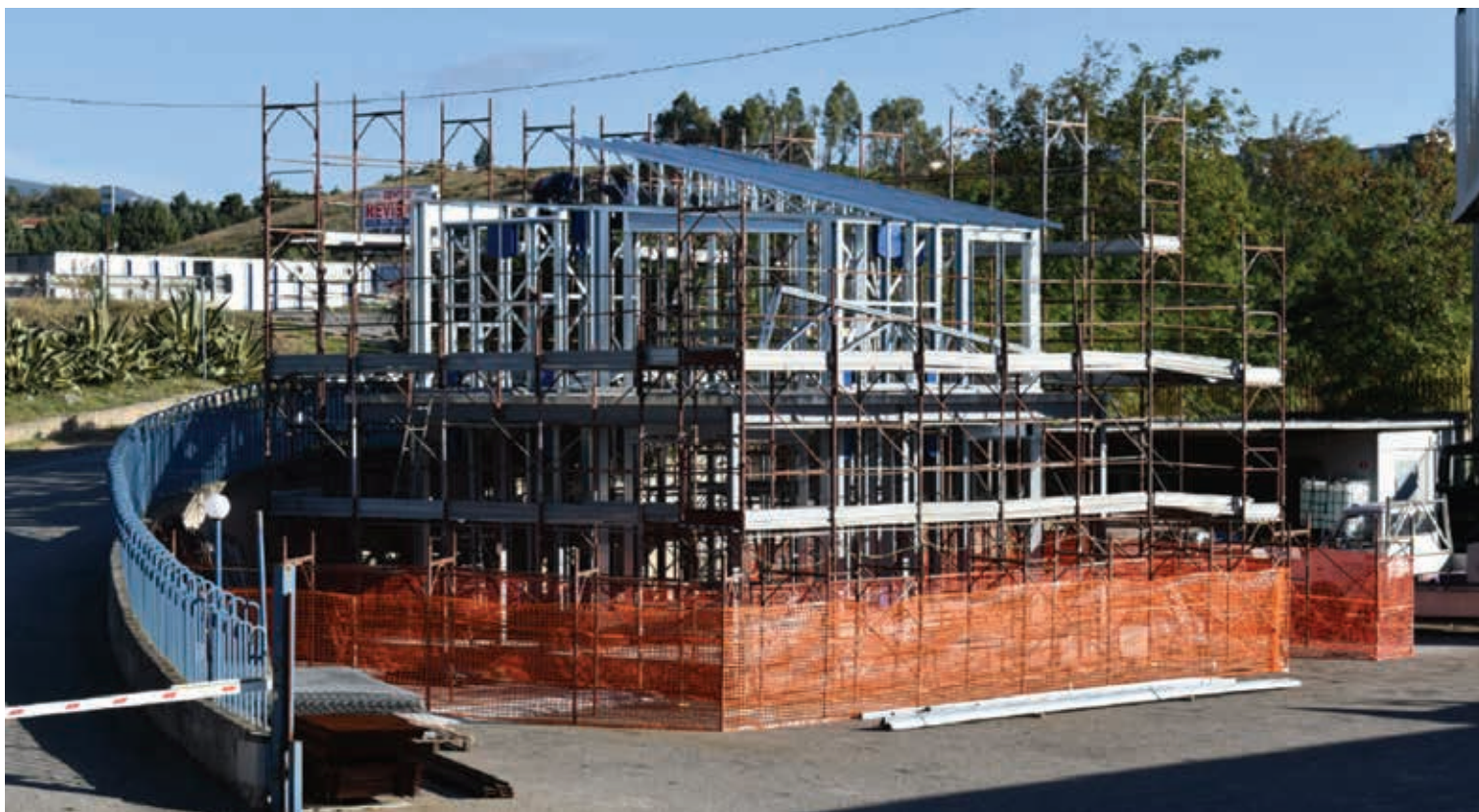
Fig. 23 | Realizzazione dello spazio espositivo: ultimazione delle strutture
