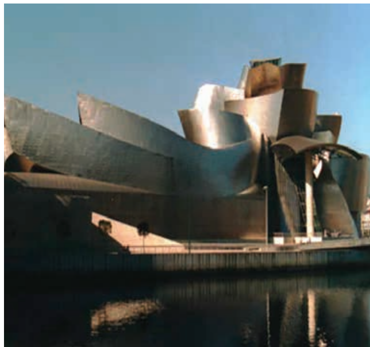
Fig. 3 | Museo Guggenheim: Bilbao, Frank O. Gehry, costruzione 1998, rivestimento in titanio [1]
