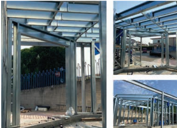
Fig. 20: Dettaglio delle aperture
