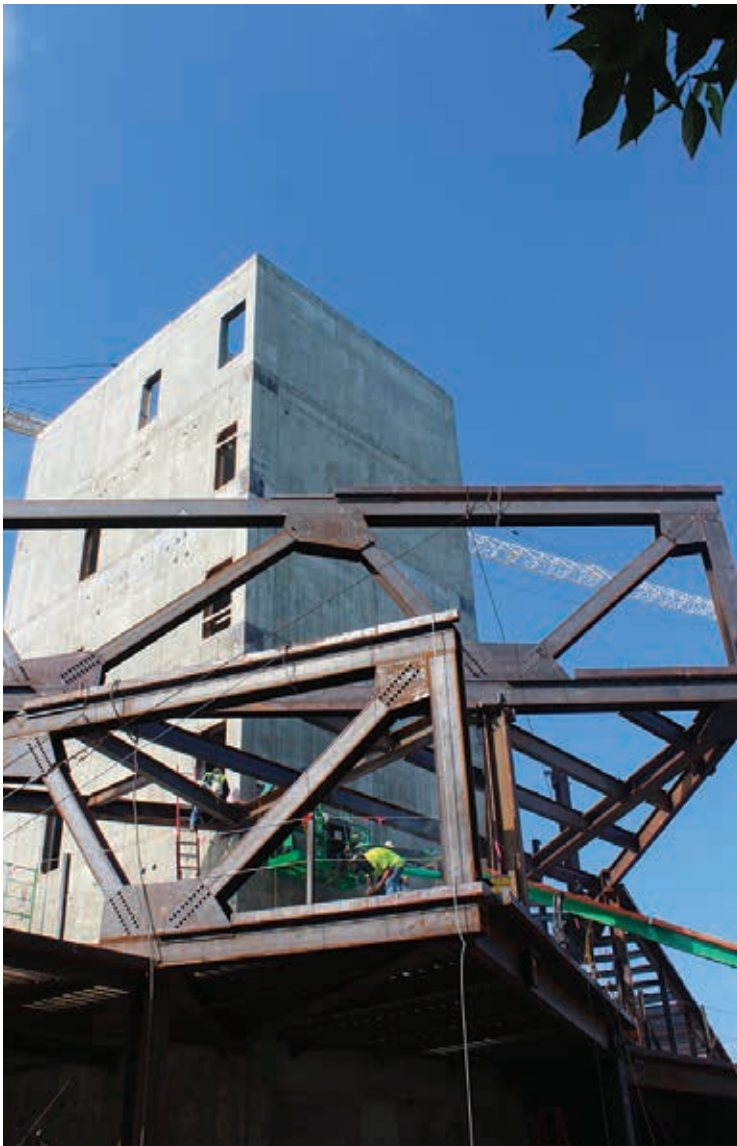
Fig. 21a e 21b | La fase di cantiere durante il montaggio, con autogrù, delle travi reticolari (© Silman).
