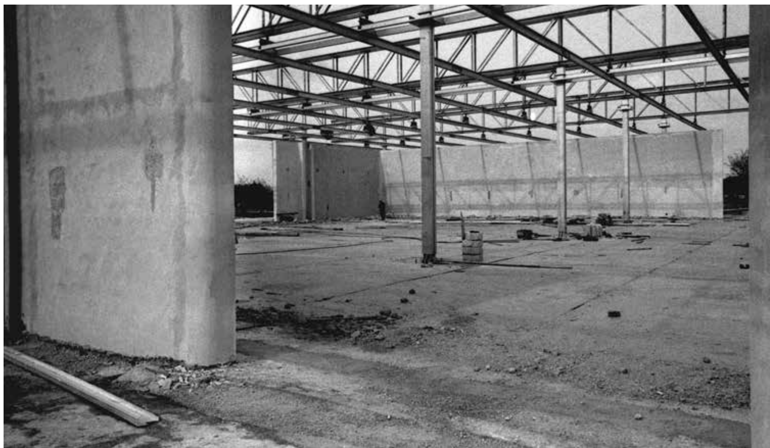
Fig. 25 | Le pareti in tufo perimetrali e la costruzione metallica, progettata dall'ingegnere napoletano Amodio e fornita da una ditta veneta, esperta in strutture zincate (Franco Sargiani).
