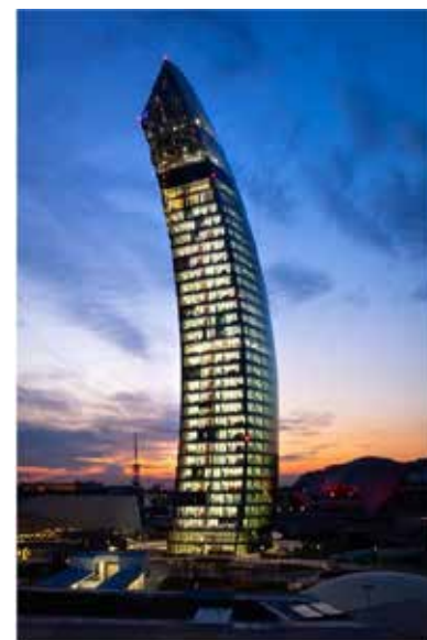
Torre PWC, Milano. Copyright: Studio Libeskind
