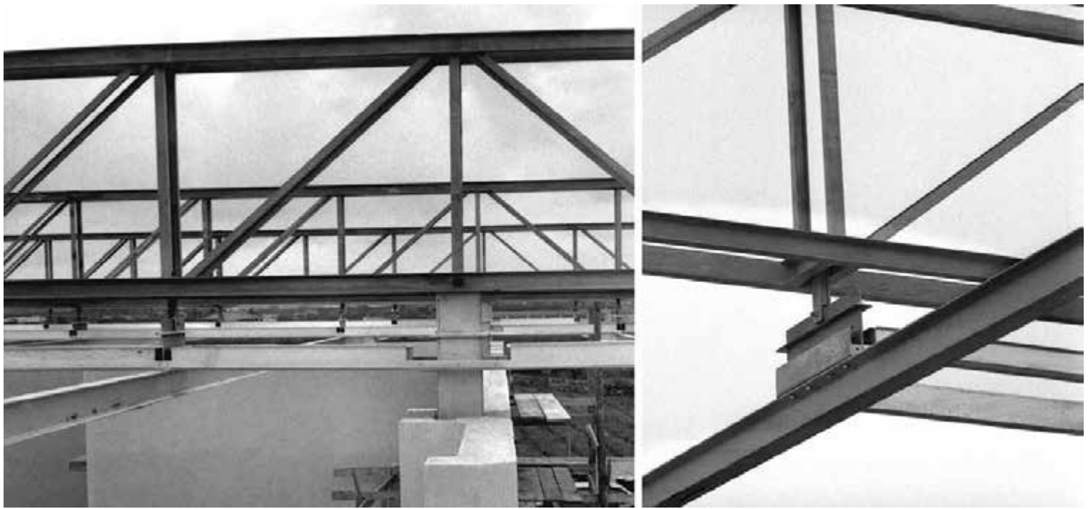
Fig. 26 | Il montaggio delle reticolari di copertura e il sistema di sospensione dell'ordito secondario (Franco Sargiani).
