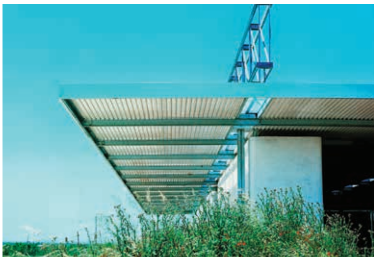
Fig. 28 | La copertura distaccata quanto basta dai muri in tufo per la formazione di un'asola in grado di garantire una ventilazione costante (Franco Sargiani).
