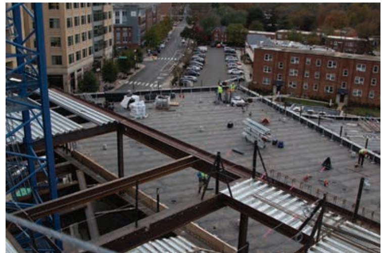
Fig. 24 | Fase di cantiere con la messa in opera dei solai (© Silman).
