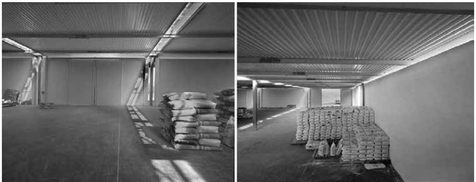
Fig. 27 | Gli spazi interni, illuminati dalla luce zenitale che filtra attraverso i lucernari lunghi e stretti posti in corrispondenza delle reticolari sovrapposte (Franco Sargiani).
