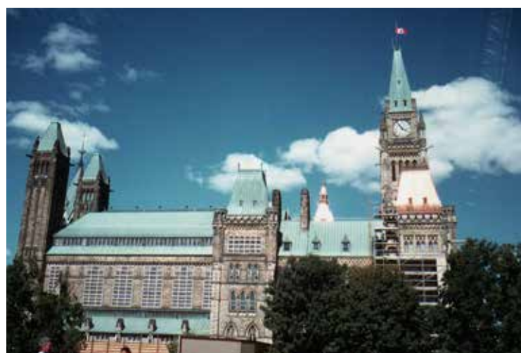
Fig. 1 | Palazzo del Parlamento (Ottawa): coperture in rame, alcune di esse sostituite dopo circa 80 anni di esposizione [1].
