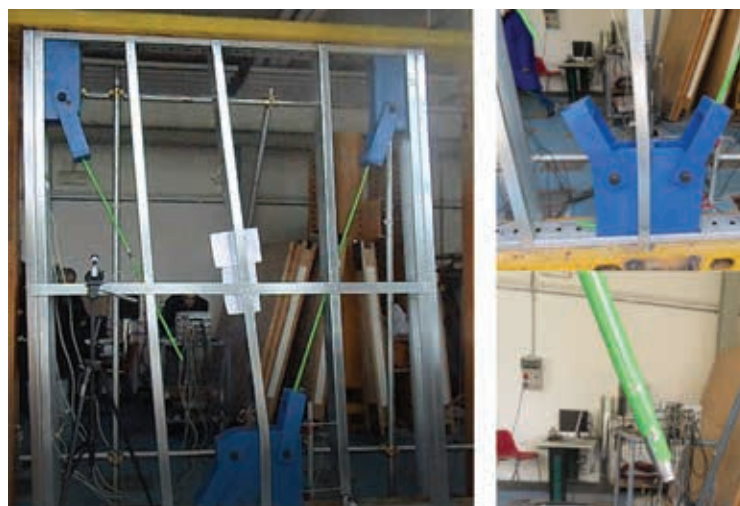
Fig. 10 | Collasso per rottura a trazione del controvento
