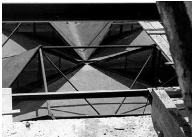
Fig. 14 | Le strutture tronco-piramidali dei moduli di copertura che accolgono il sistema dei lucernari (Pica Ciamarra Associati).
