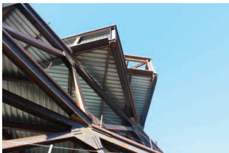
Fig. 14a 14b | Vista dal basso dei volumi a sbalzo ruotati rispetto all'asse, nell'immagine di destra con il rivestimento in mattoni bianchi e nell'immagine di sinistra nudi con il solo scheletro strutturale in travi di acciaio e solai leggeri in pannelli di lamiera grecata (©BIG_WILS e Silman).
