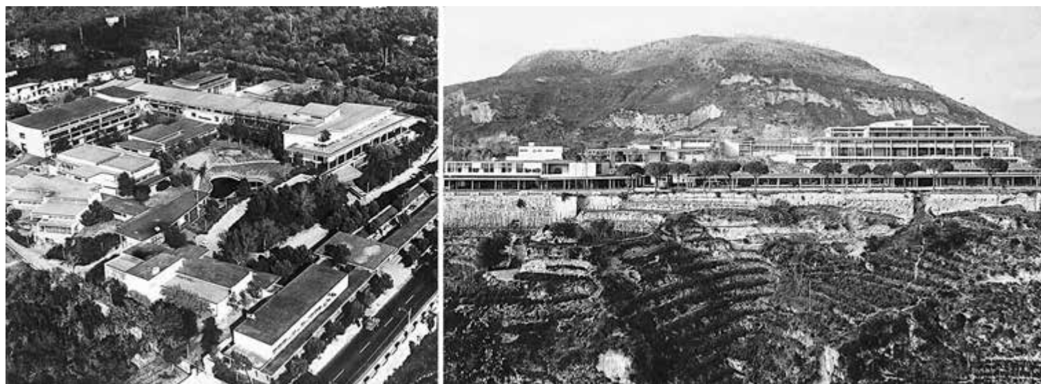
Fig. 4 | La fabbrica Olivetti di Pozzuoli, ing. L. Cosenza, 1951-54 (www.storiaolivetti.it).
