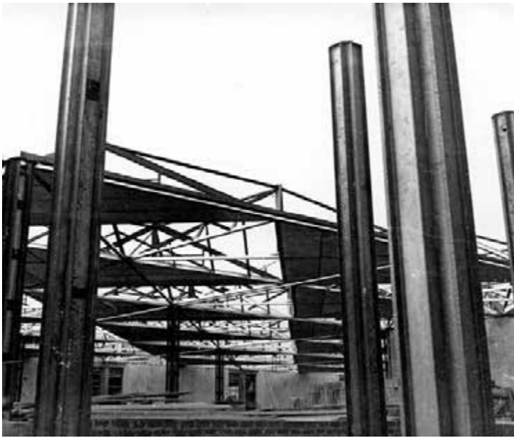
Fig. 12 | Il montaggio delle colonne e dei moduli di copertura degli spazi per la produzione (Pica Ciamarra Associati).
