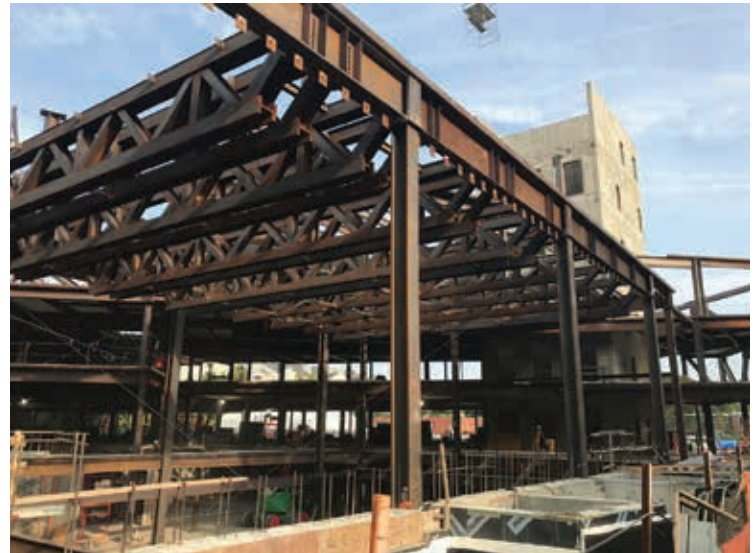
Fig. 22 | Sopra il teatro, le travi reticolari ribassate sono state la soluzione ottimale per soddisfare le esigenze di espansione futura, il routing MEP e profondità del pavimento consentite (© Silman).
