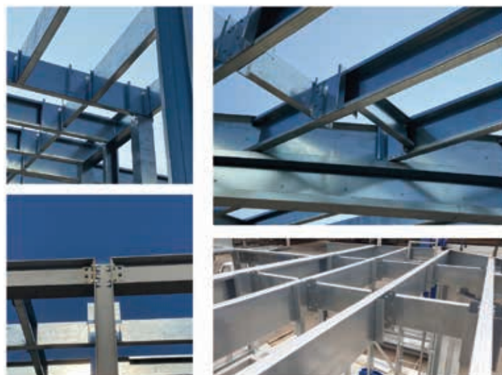
Fig. 17 | Dettagli della struttura del solaio
