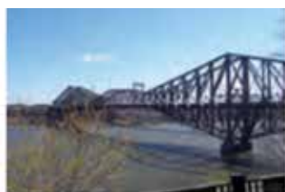
Ponte di Quebec City, oggi.
