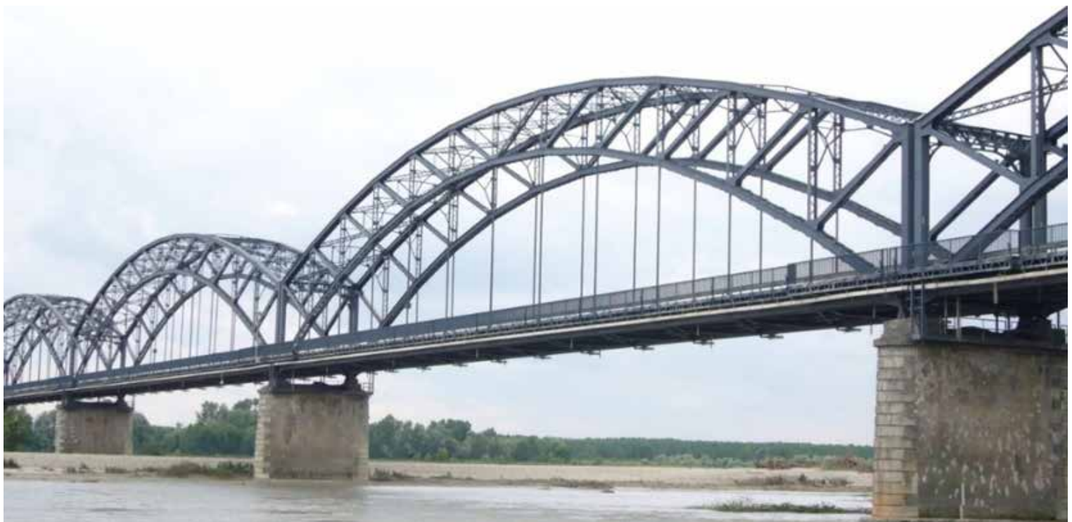
Fig. 13 | Esempio di ponte metallico centenario con struttura a arco a spinta eliminata [29]
