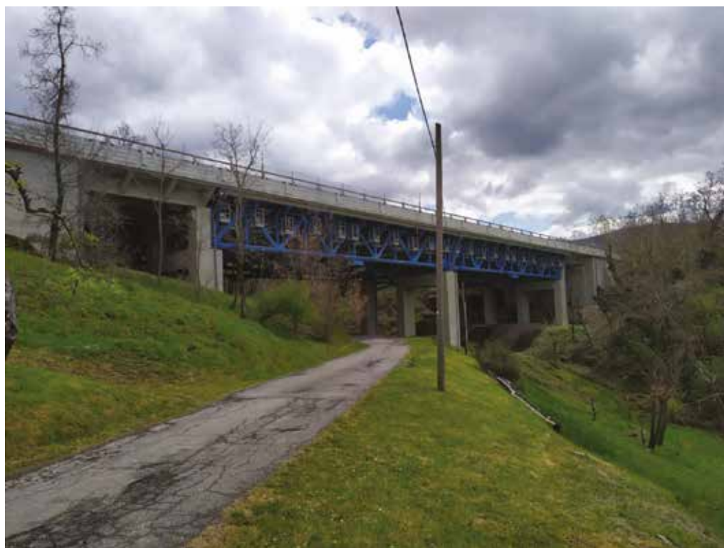
Fig. 2 | Viadotto Rio Faldo
