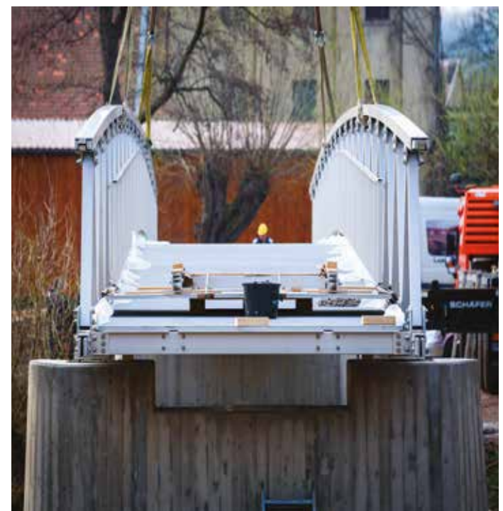
Fig. 10 | Vista del tronco centrale della superstruttura già fissata a uno dei piedritti centrali (©n'Rico Kreim)
