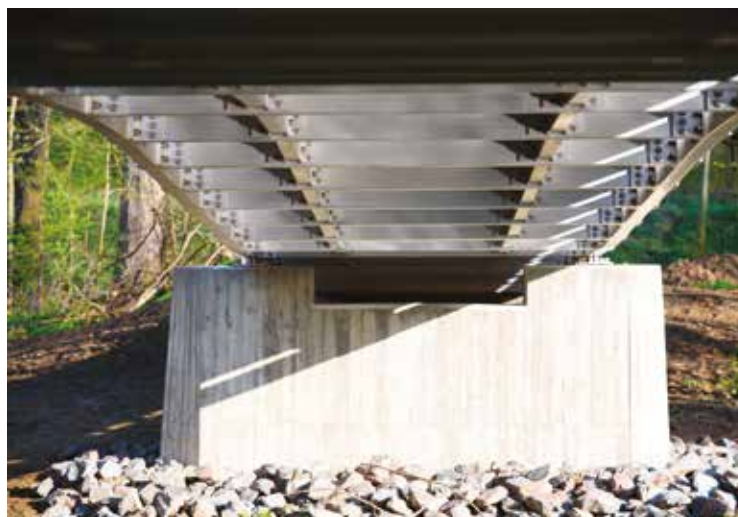
Fig. 5a | Vista dell'intradosso del ponte metallico (©n'Rico Kreim)
