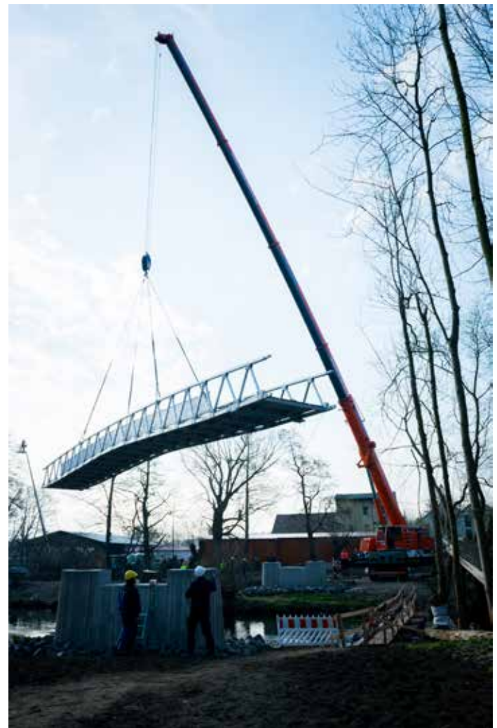
Fig. 9 | Fase di alloggiamento in sito del primo segmento prefabbricato del ponte (©n'Rico Kreim)
