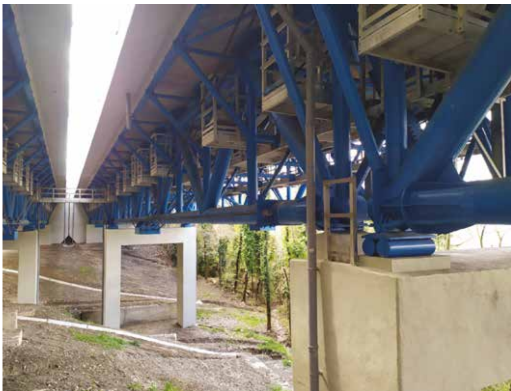
Fig. 1 | Viadotto Rio Gamberi
