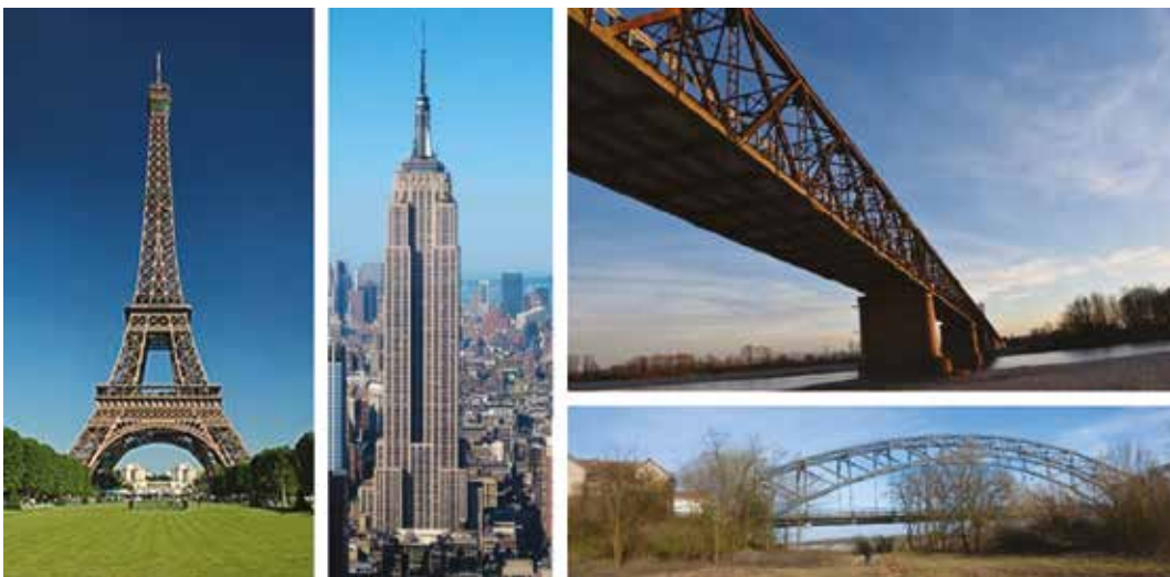
Fig 2 | Strutture di acciaio del passato, ancora oggi pienamente efficienti.
