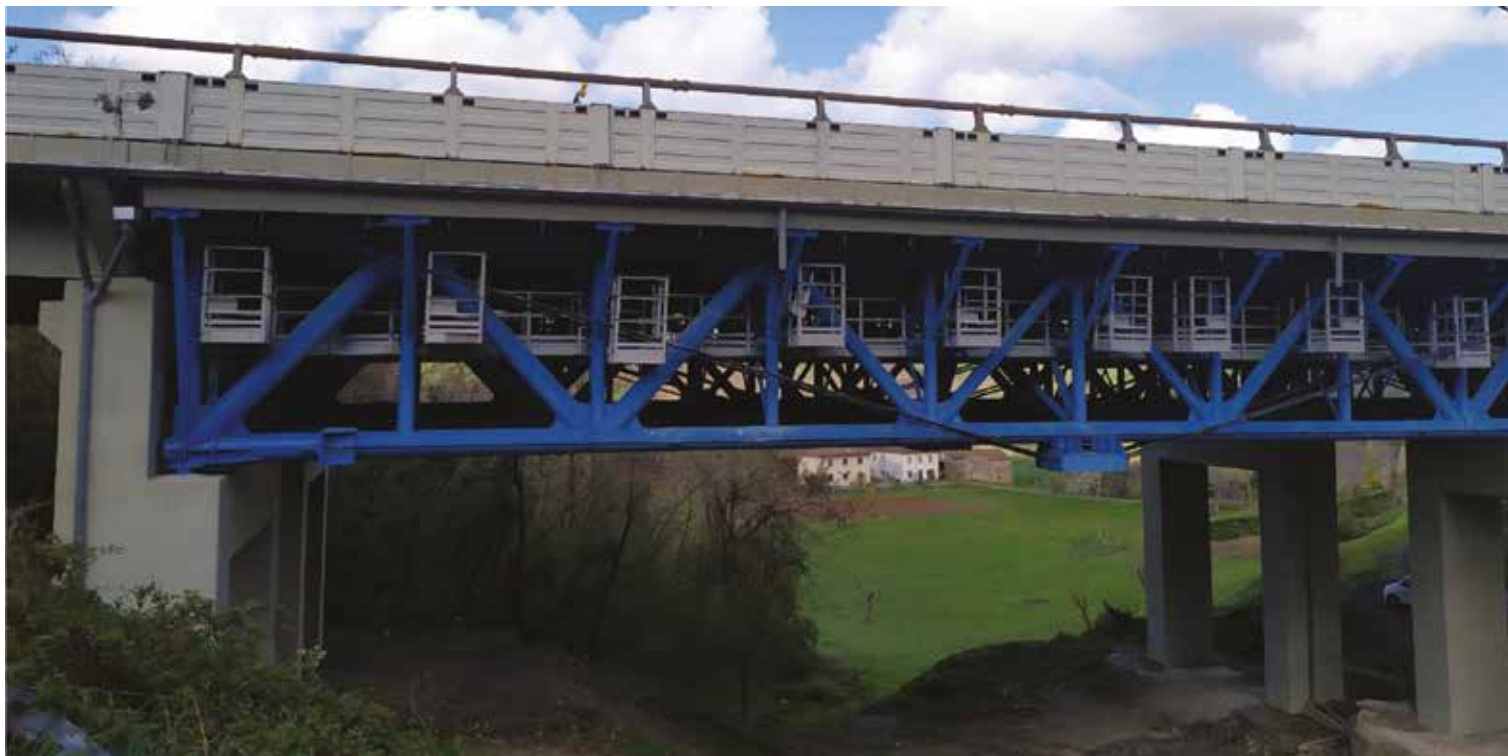
Fig. 13 | Travatura reticolare principale con profili tubolari
