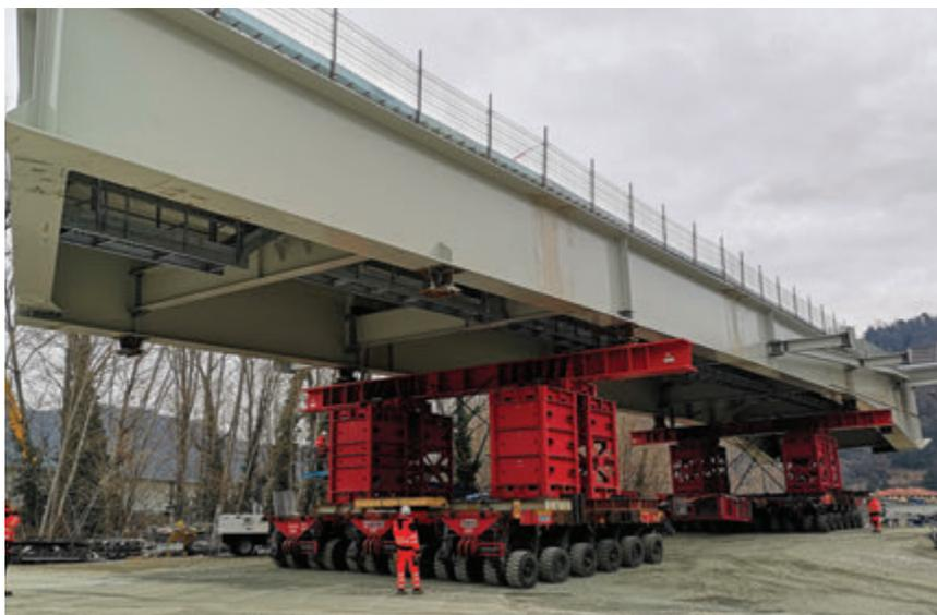
Fig. 12 | La partenza del secondo macroconco tra SpA e P1 dall'area di assemblaggio in golena
