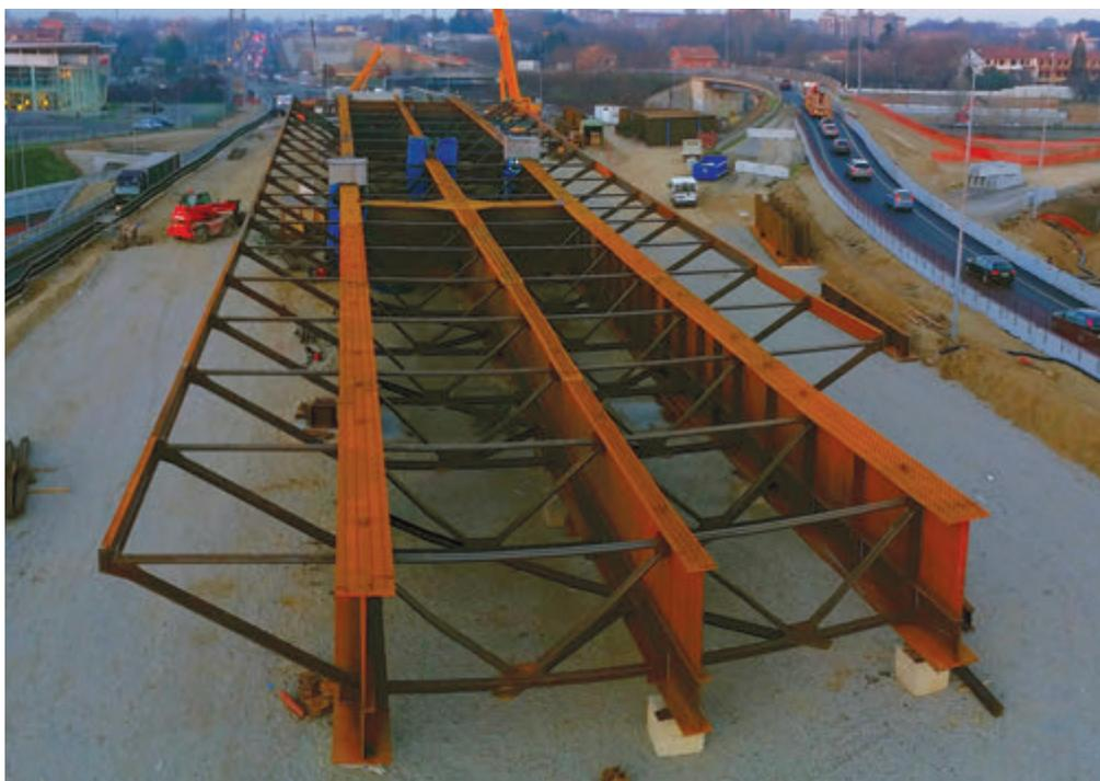
Fig. 3 | L'assemblaggio dell'impalcato dietro spalla S1
