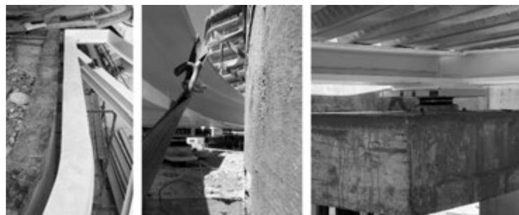
Fig. 19. | Fase di grouting appoggi e controllo dimensionale giunti strutturali
