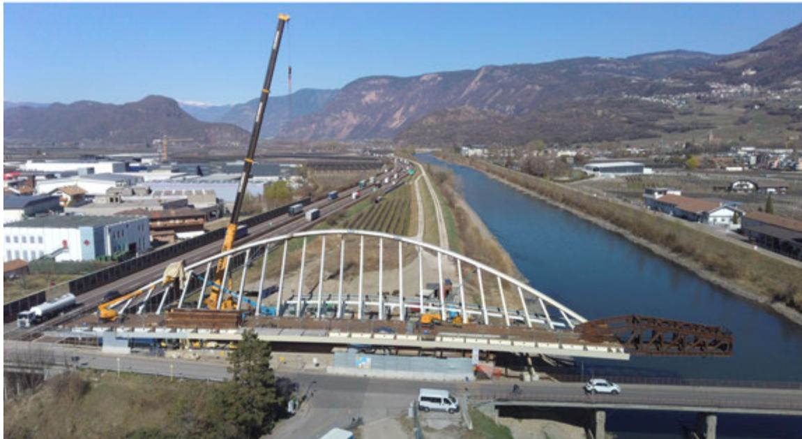
Fig. 26 | Configurazione provvisoria e recupero delle deformazioni
