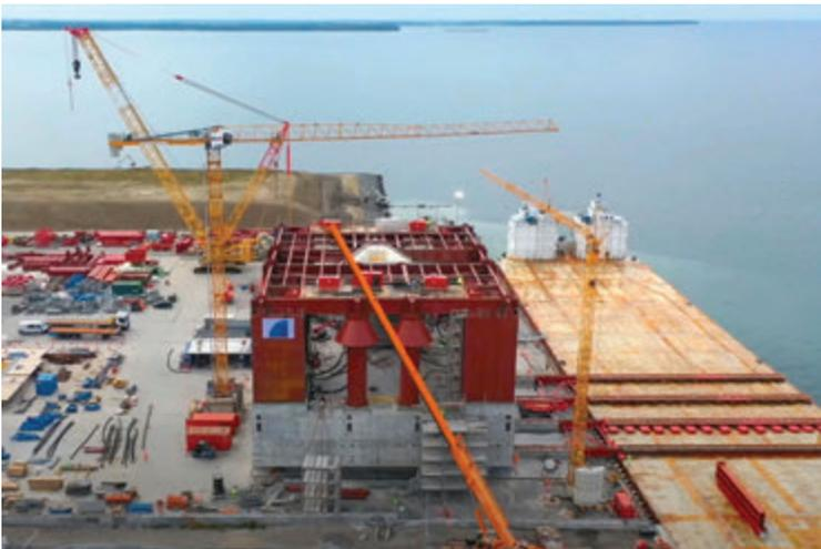
Fig. 13 | Le strutture SSS in fase di completamento, ed il percorso di load-out verso la barge semi-sommersibile.
