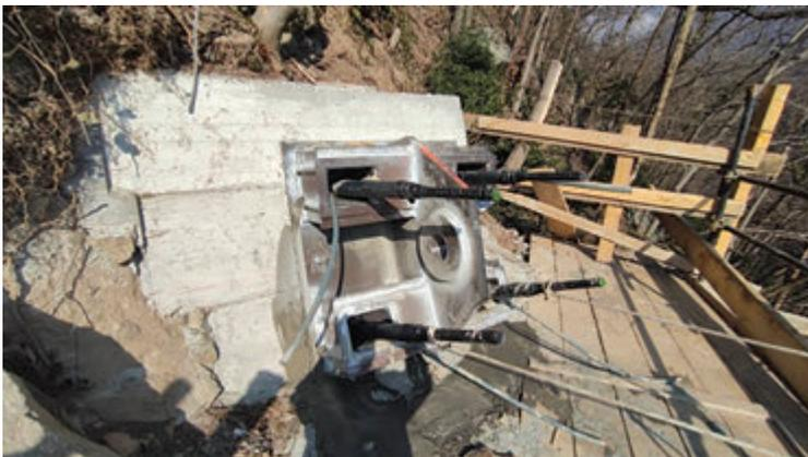
Fig. 10 | Fondazione dei cavi stabilizzanti
