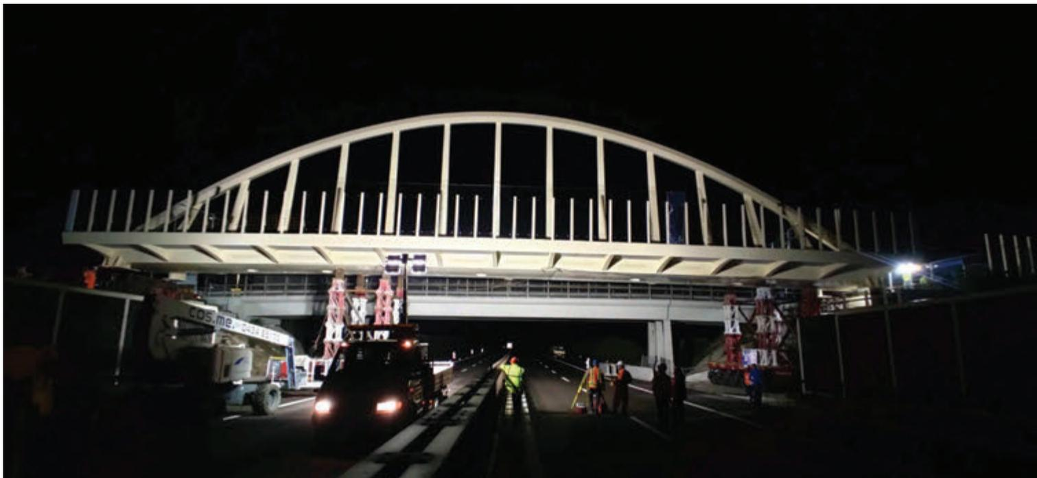
Fig. 29 | Posizionamento finale dell'impalcato
