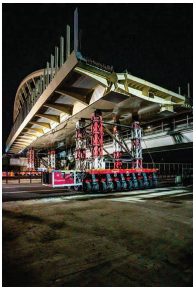
Fig. 28 | Presa in carico impalcato ai piedi della spalla di lancio
