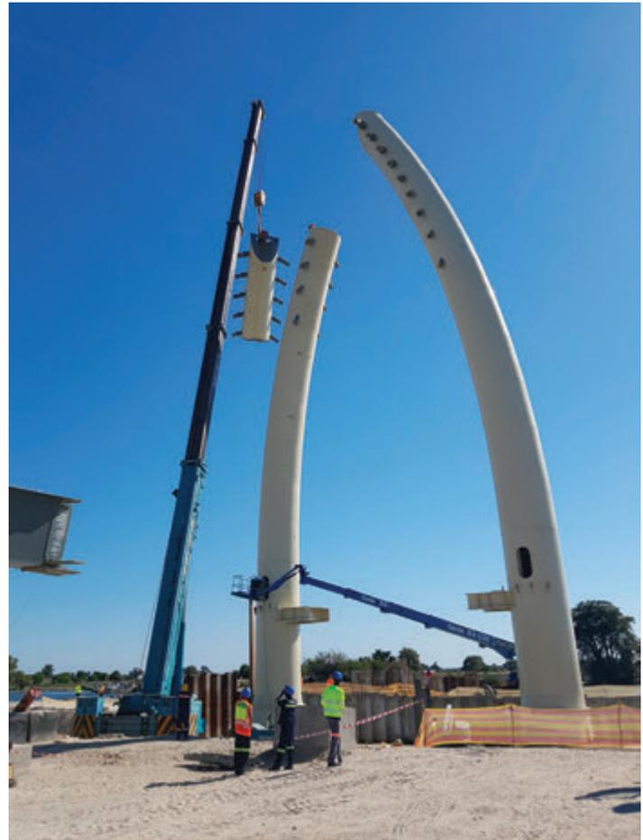
Fig. 15. | Fasi realizzative delle antenne: in evidenza il bilanciamento per sollevamento e l'accessibilità a quota impalcato
