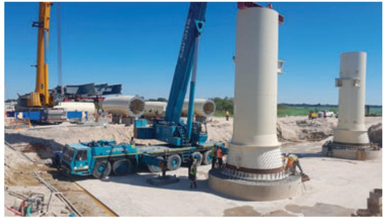
Fig. 10. | Dettaglio dell'incastro di base delle antenne in fase di montaggio
