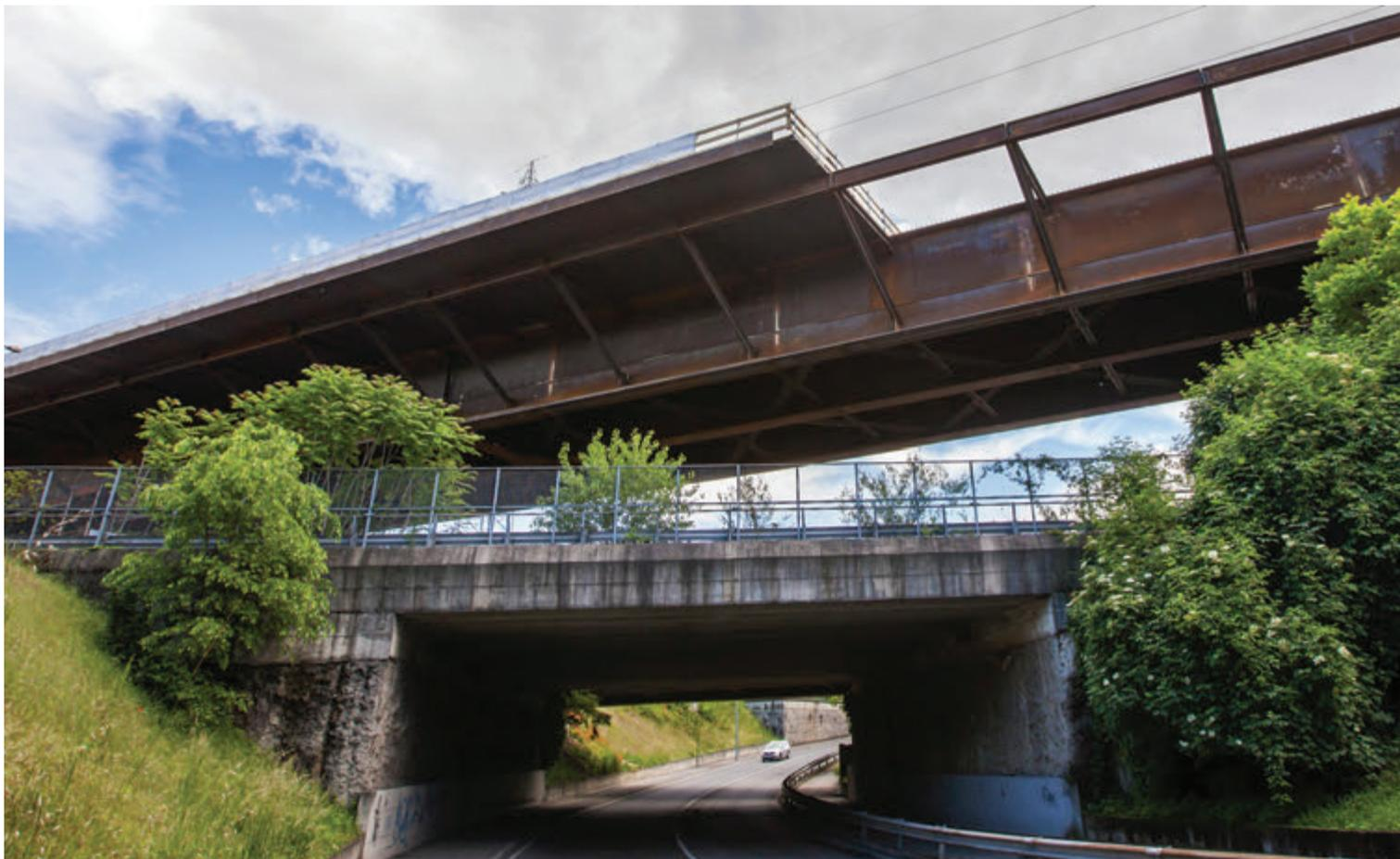
Fig. 1 | I tre livelli durante il varo del nuovo ponte
