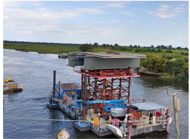
Fig. 19. | La banchina di carico del pontone per la movimentazione conci in alveo (a sx) e un concio in navigazione (a dx)
