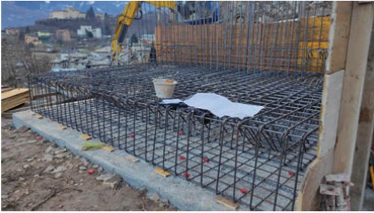
Fig. 8 | Platea di fondazione delle antenne
