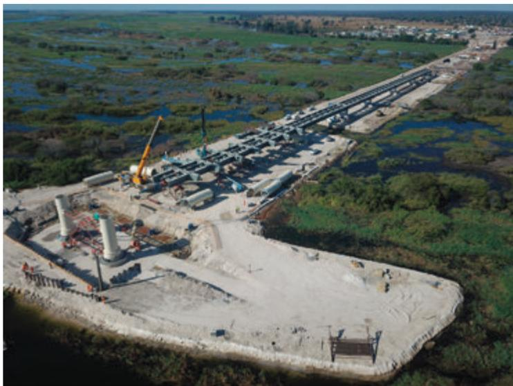
Le antenne, come precedentemente descritto suddivise in macroconci di lunghezza 8÷12 m, sono state assemblate con l'ausilio di gru da 200 e 250 t, utilizzando un unico bilancino studiato e dimensionato per agevolare la movimentazione ed il posizionamento dei conci. Le due gambe delle torri sono montate indipendentemente l'una dall'altra, e la continuità strutturale tra le due viene garantita da un sistema di martinetti ed imbottiture (figura 14).
