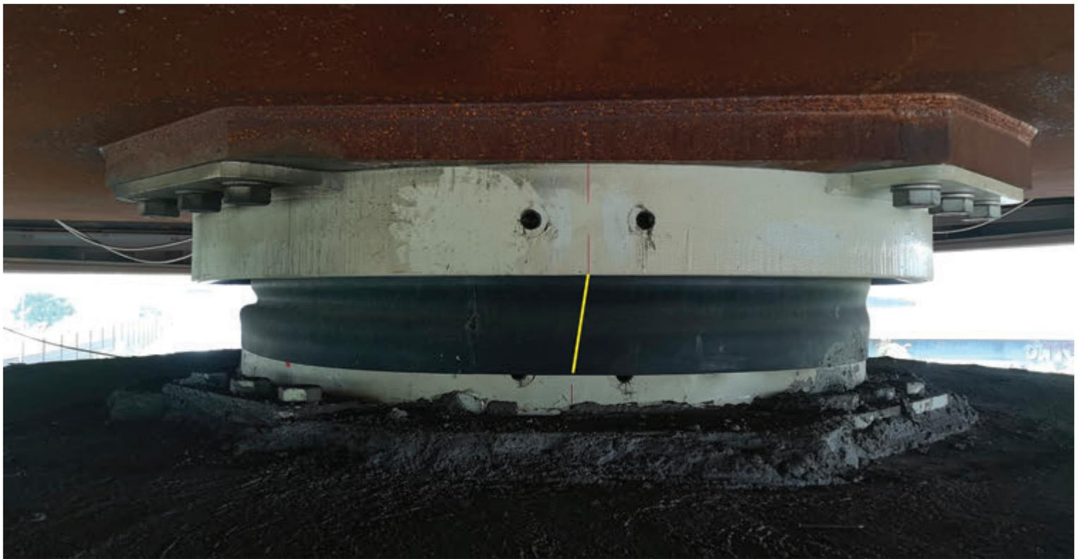
Fig. 9 | L'appoggio su P3 deformato
