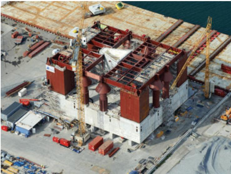
Fig. 12 | Le strutture SSS in fase di montaggio su F1C. Agli spigoli si trovano i cassoni di stabilizzazione per l'affondamento. Sui lati si vedono le colonne con i dispositivi conici anti ghiaccio.
