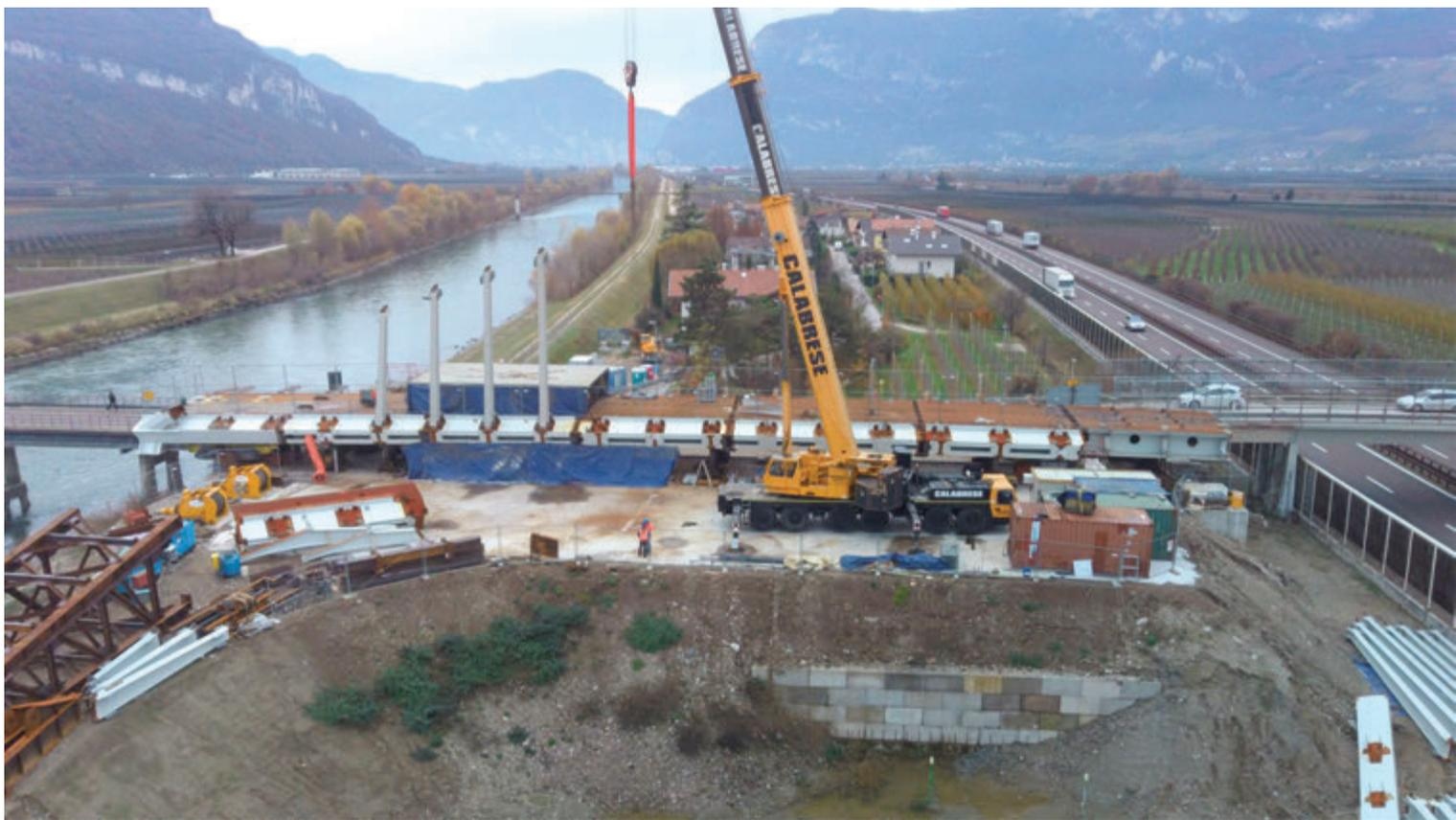
Fig. 24 | Vista delle aree di cantiere durante l'assemblaggio del ponte
