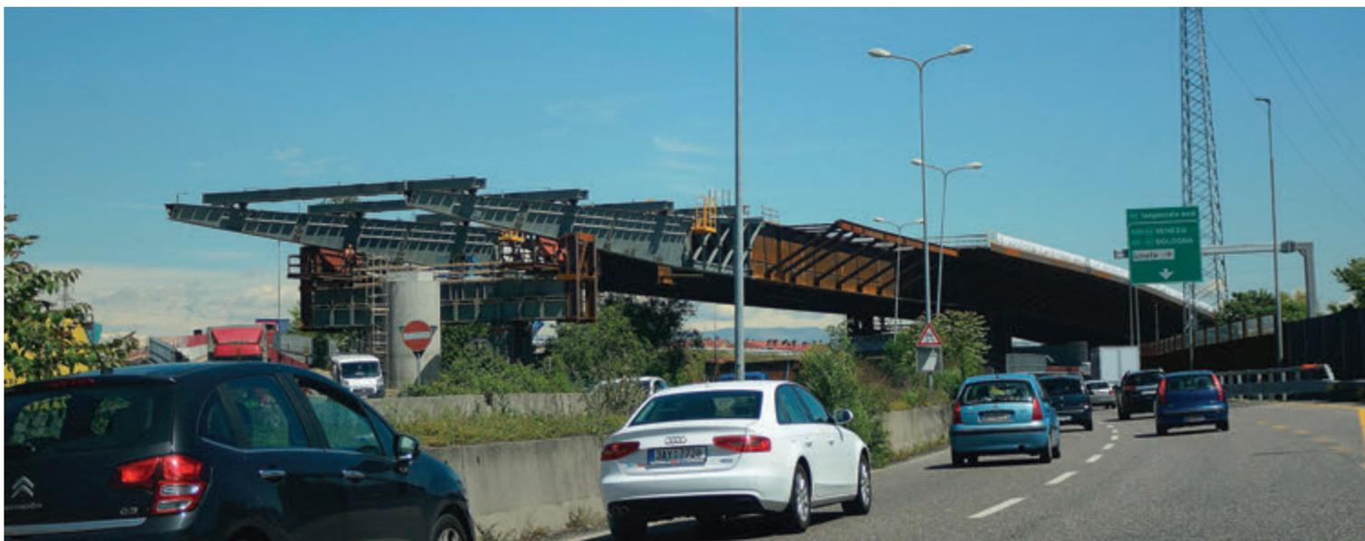
Fig. 8 | Il varo su P2 con attraversamento della S.S.n.35 in presenza di traffico
