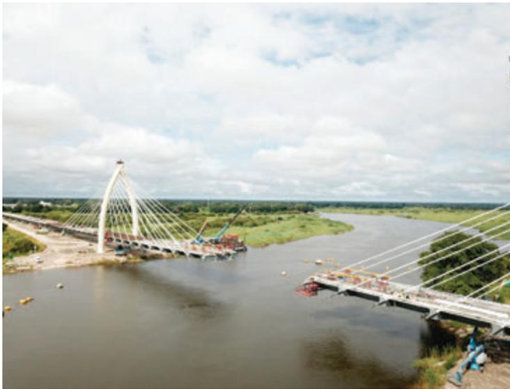
Fig. 18. | Il montaggio della campata da 200 m in avanzamento sopra il fiume
