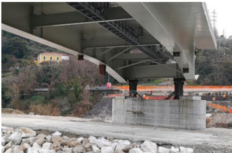
Fig. 7 | I tre leggeri puntoni di stabilizzazione delle piattabande inferiori compresse durante il montaggio e il diaframma di pila sghembo all'intradosso, senza appoggio per la trave di spina
