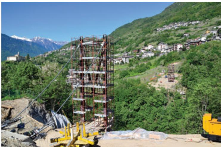
Fig. 14 | Installazione cavi retrostralli
