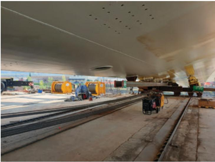
Fig. 19 | Rulliere e trave di guida su spalla Ovest
