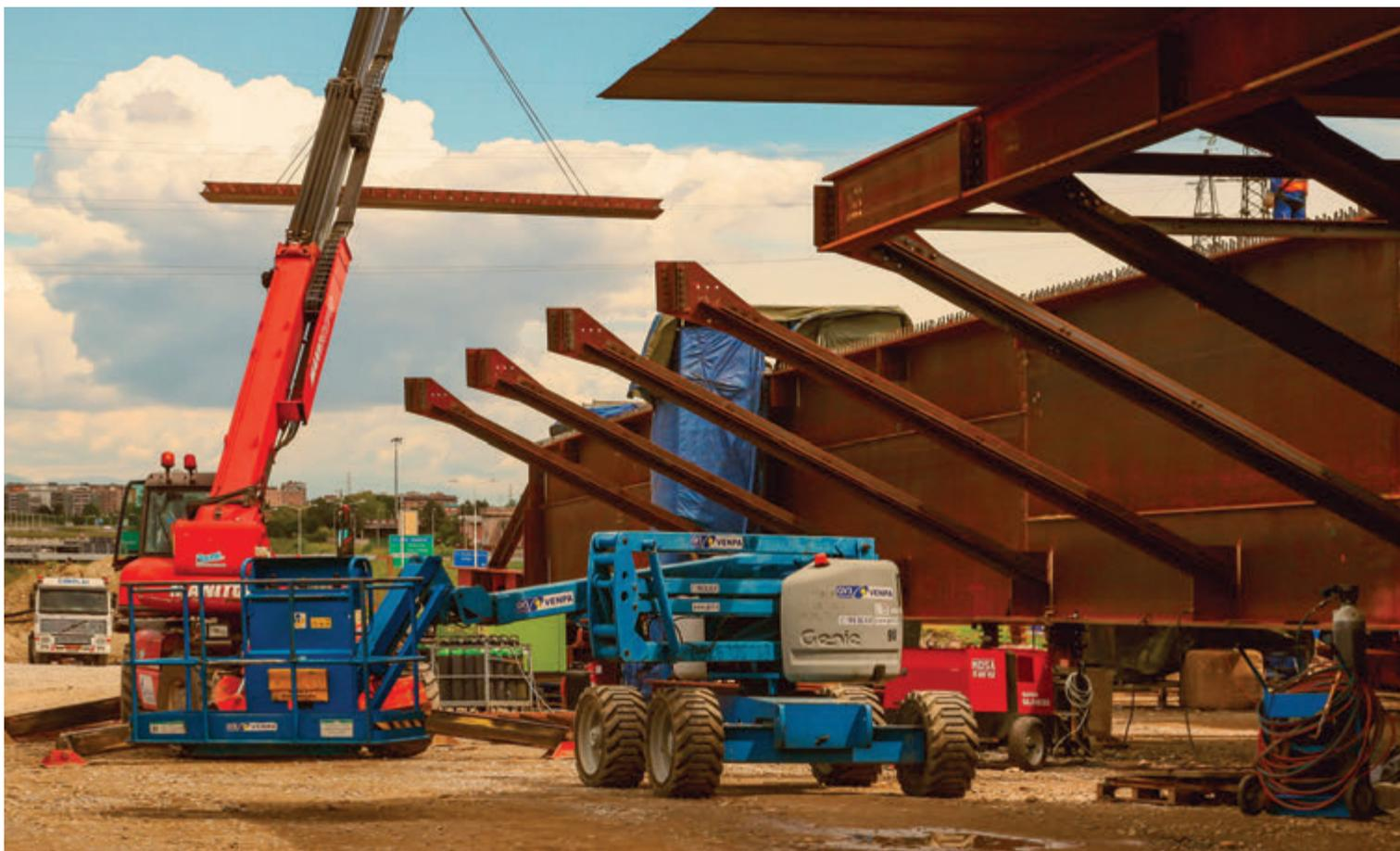
Fig. 5 | L'installazione della trave di spina esterna, in luce tra i remi
