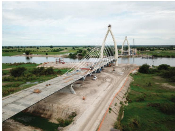
Fig. 17. | Fase di pretesatura degli stralli lato Antenna 1 (a sx) e lato Antenna 2 (a dx)
