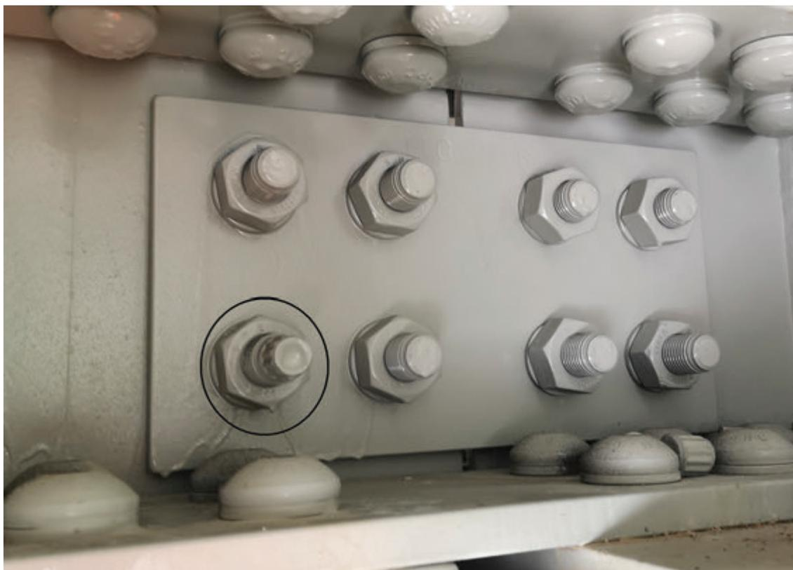
Fig. 15 | Il bullone HRC non tesato col “codolino” ancora presente sul gambo
