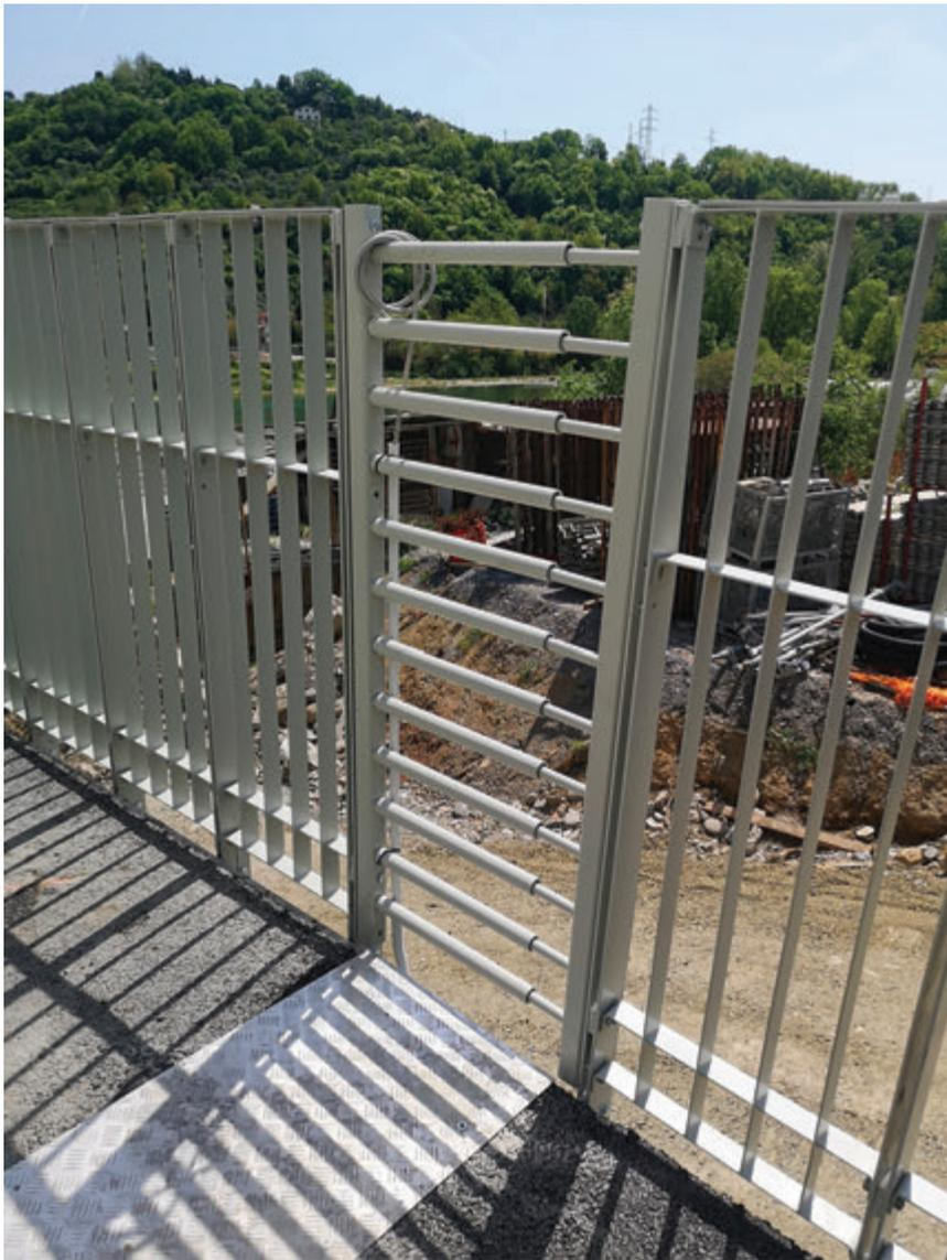
Fig. 11 | il giunto a baionetta del corrimano con scorrimento di +/- 80 mm, inserito tra i moduli di 50 cm.
