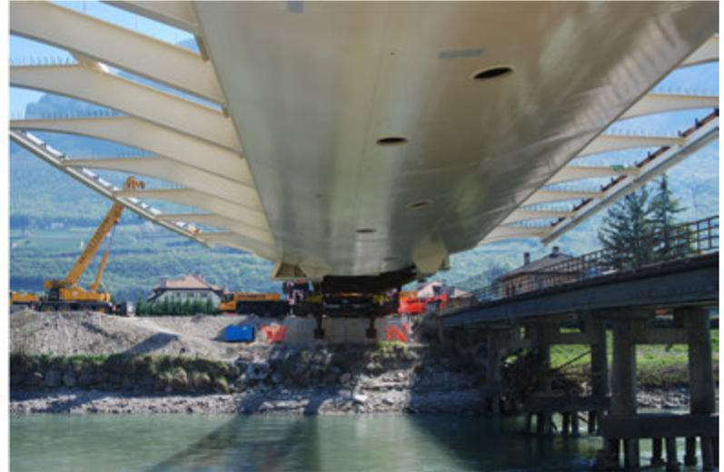
Fig. 9 | Cassone d'impalcato – Vista laterale (a) e da sotto (b)
