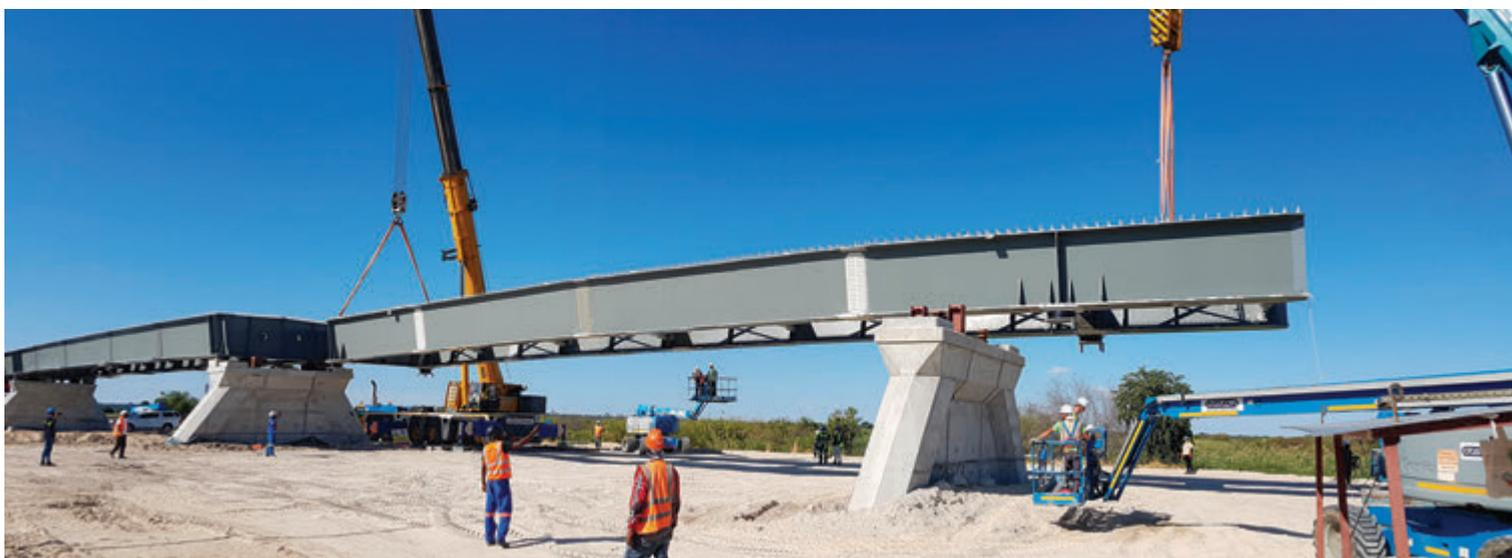
Fig. 14. | Sollevamento con gru di grande portata di una campata delle rampe di luce 45m
