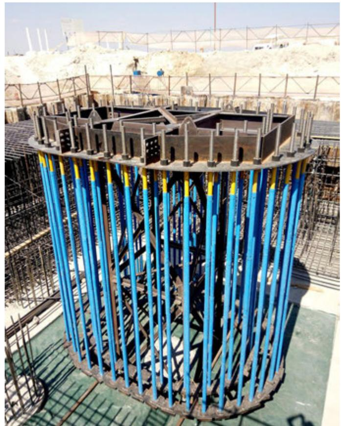
Fig. 16. | Il "matching" tra la dima e la piastra di base (a sx) e il castello in posizione completo di dime e barre (a dx)
