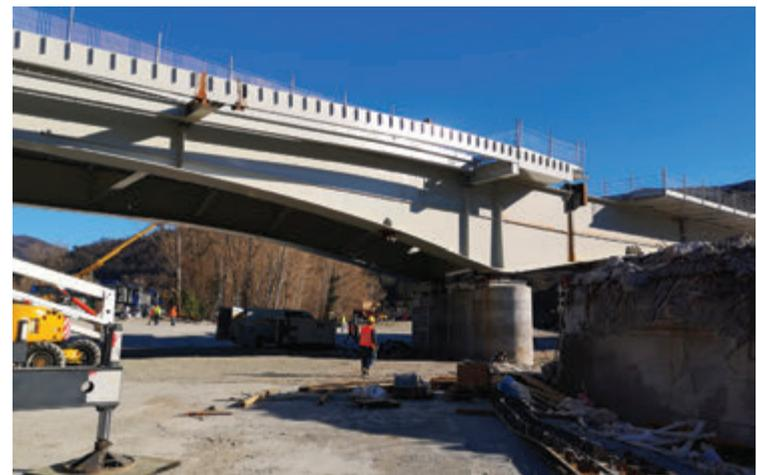
Fig. 8 | la struttura della rampa in discesa da P1 e la successione di lame di ancoraggio del parapetto alla veletta metallica, in primo piano a destra la vecchia pila e posteriormente la sezione del giunto di continuità tra P1 e P2 prima della saldatura
