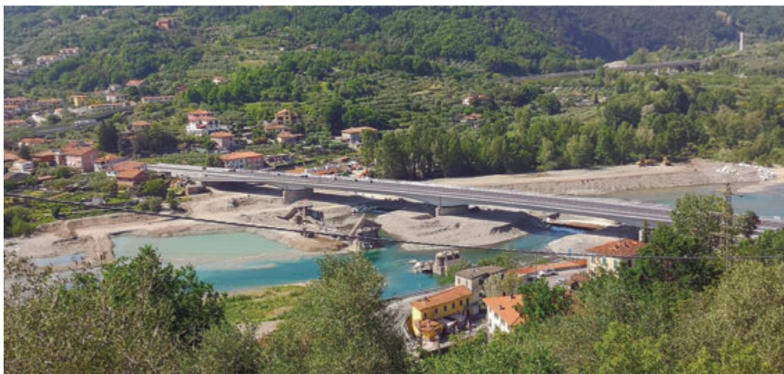
Fig. 3 | Il nuovo ponte con in primo piano le macerie del ponte crollato a maggio 2022, in alto a destra il ponte sospeso di Stadano ricostruito dopo il crollo del 2011
