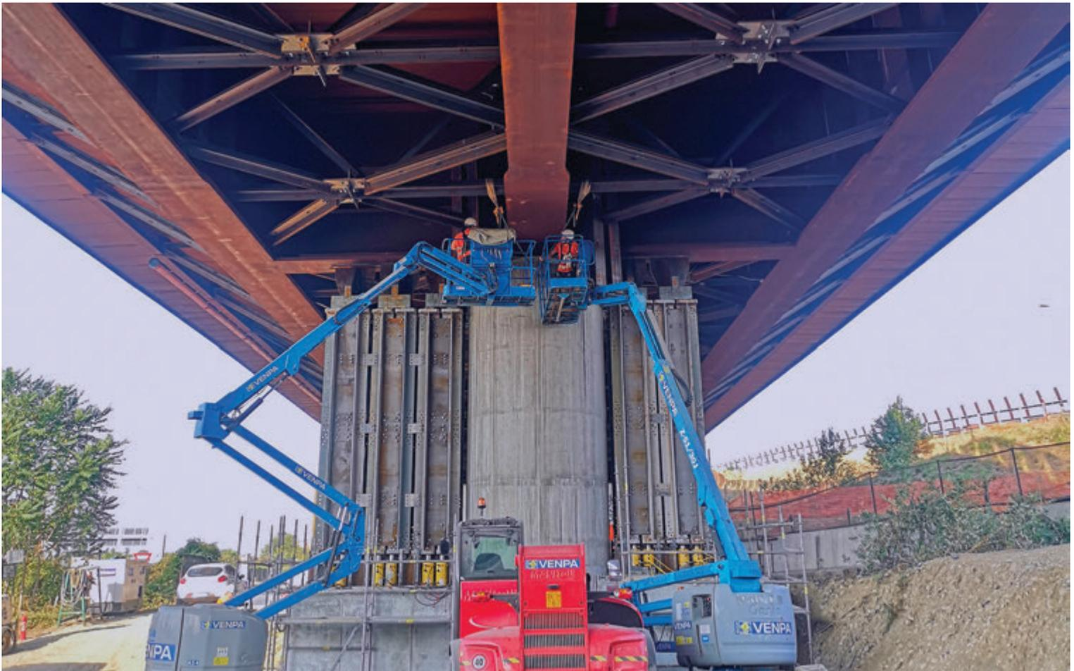
Fig. 11- La sostituzione degli appoggi su P3 e la struttura impiegata per il recupero della rotazione torsionale
