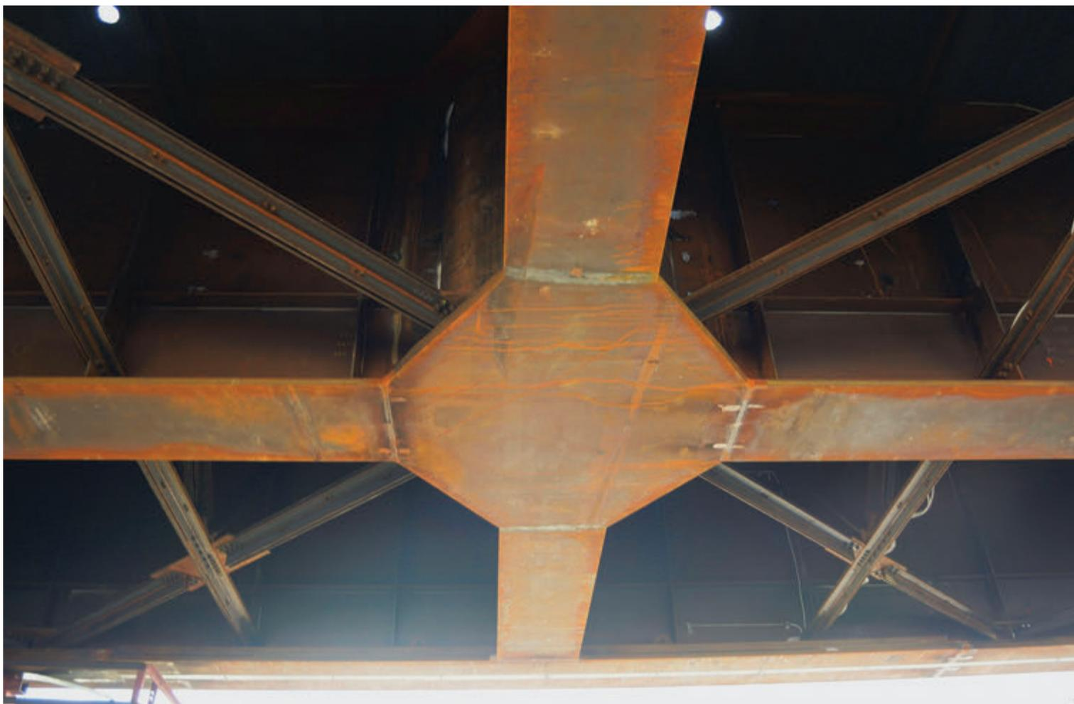
Fig. 4 | Il diaframma di pila nell'incrocio con la trave centrale prima del posizionamento dell'appoggio
