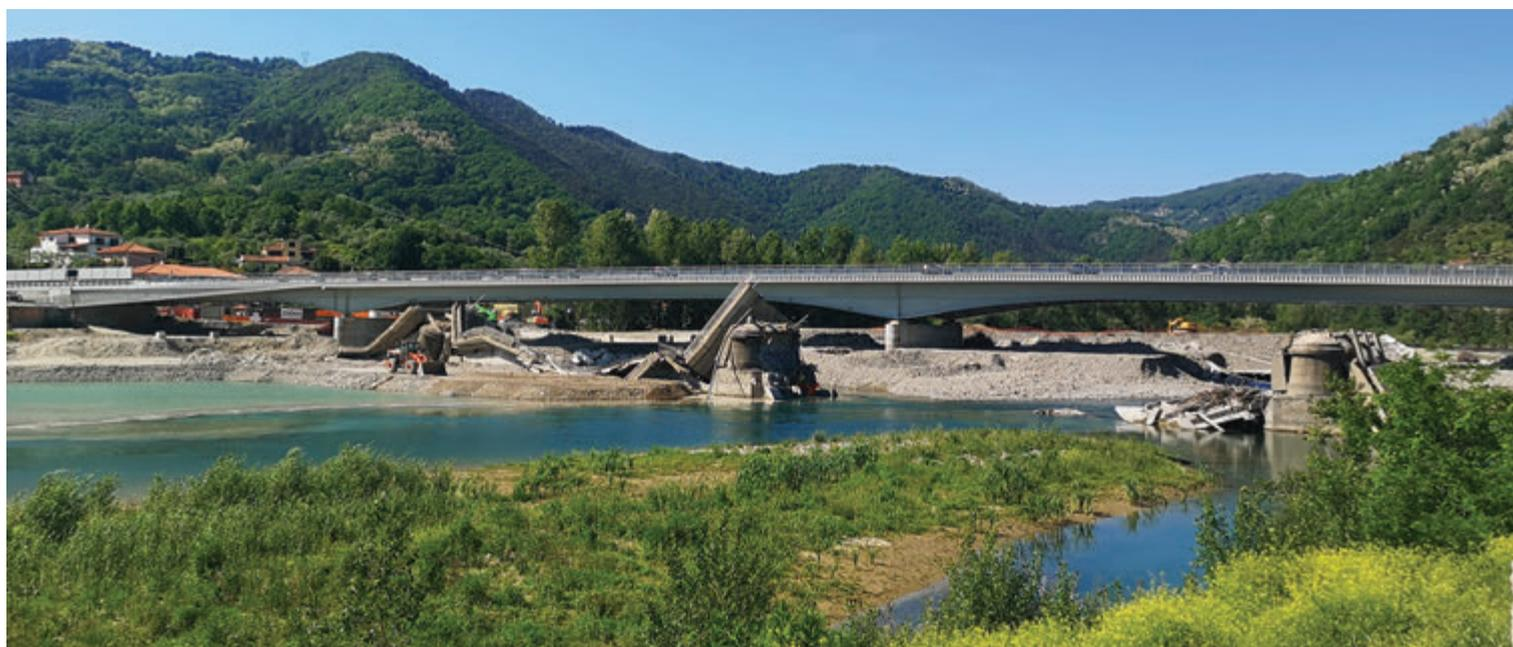
Fig. 16 | Il nuovo ponte aperto al traffico durante la rimozione finale delle macerie del vecchio ponte
