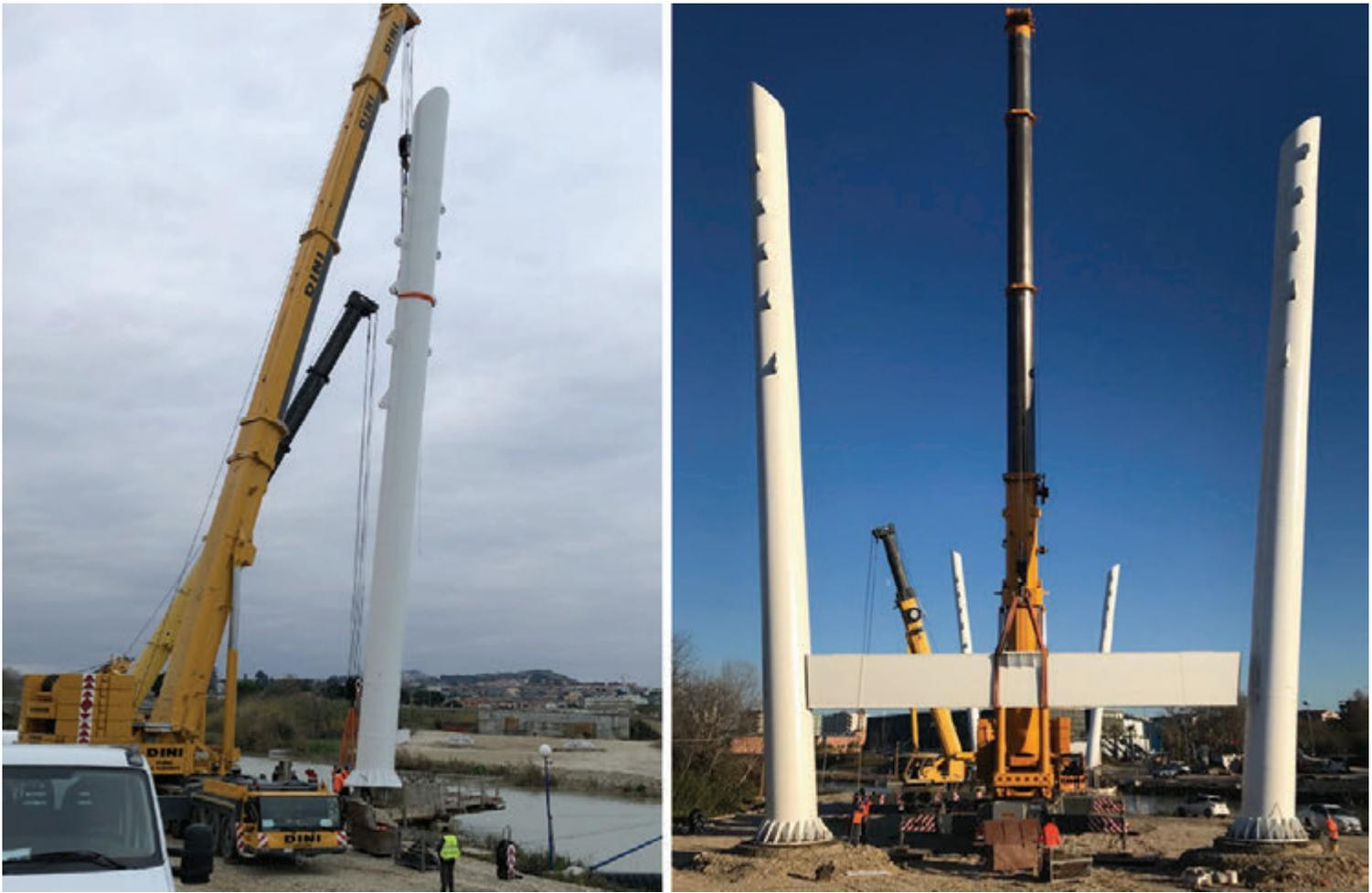
Fig. 17. | Montaggio antenne e traverso
