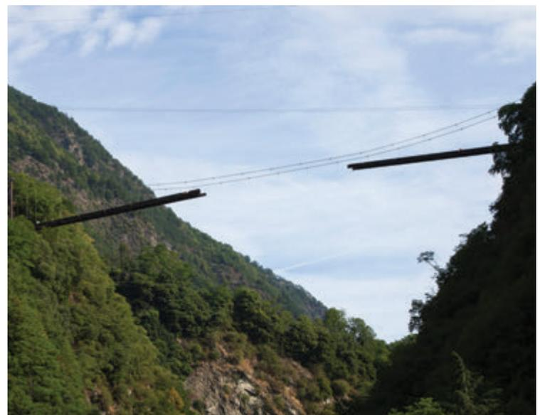
Fig. 20 | Installazione dei conchi di impalcato. Vista laterale
