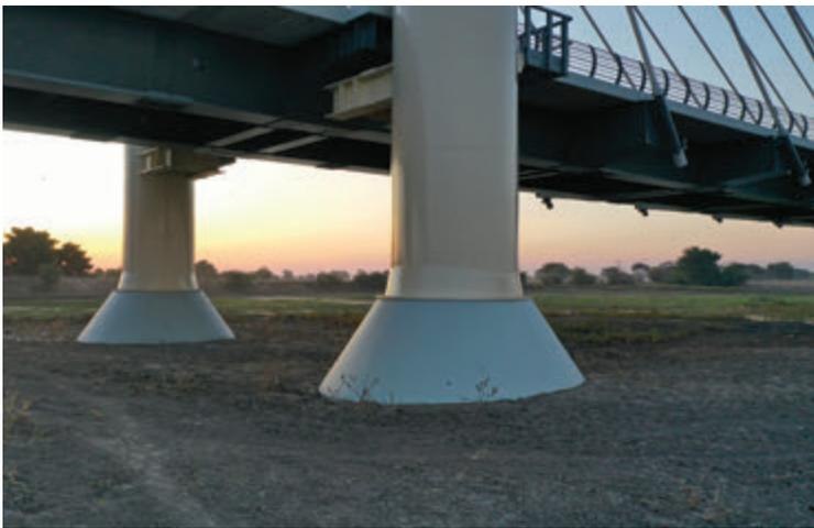
Fig. 11. | Dettaglio dell'incastro di base delle antenne a fine lavori
