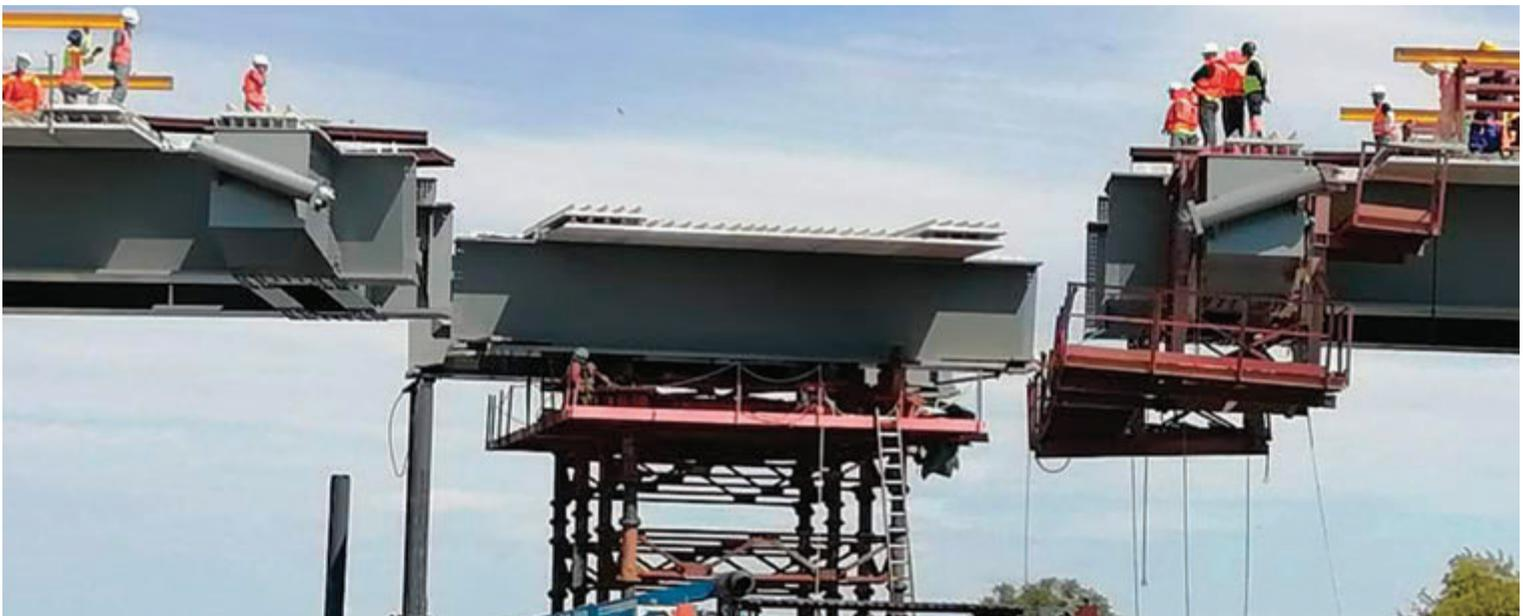
Fig. 20. | La fase di chiusura dell'impalcato sul fiume con il montaggio del concio di chiave
