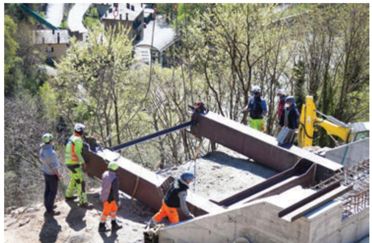
Fig. 12 | Montaggio antenna. Concio di base
