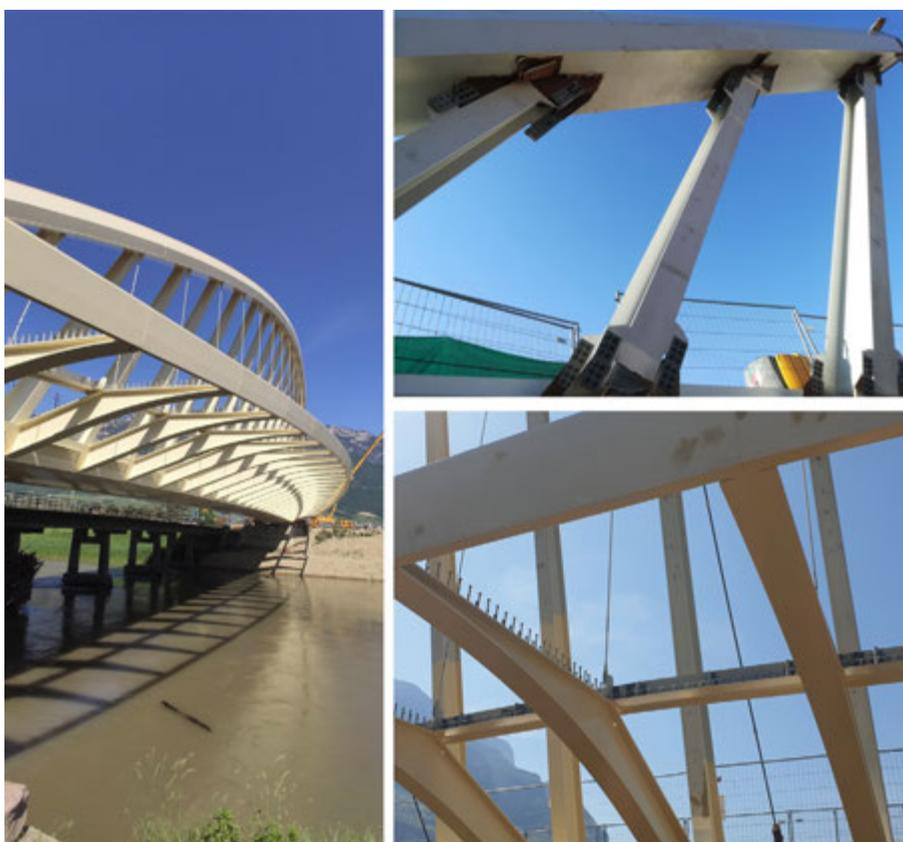
Fig. 12 | Pendini e remi – Assieme (a), dettagli costruttivi (b) (c)
