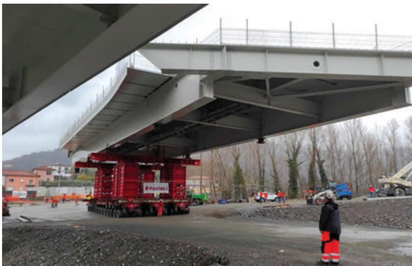
Fig. 13 | Il trasporto del quarto macroconco tra P3 e SpB col lungo traverso di testata in primo piano
