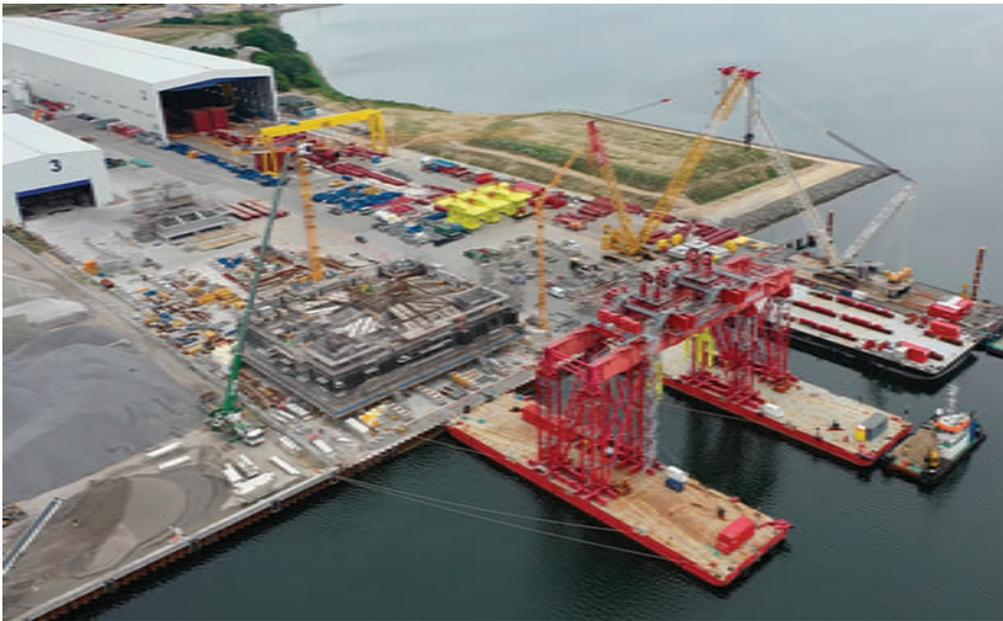
Fig. 10 | Immagine dal cantiere in progress: il plinto F1C dell'antenna del ponte strallato in fase di prefabbricazione a terra e, di fronte ormeggiato, il catamarano per la posa delle fondazioni dei viadotti. Sullo sfondo, verniciati in giallo, i traversi delle Lifting Towers stoccati in attesa del montaggio.
