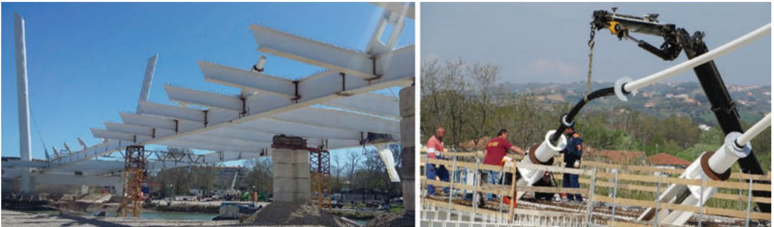
Fig. 18. | Montaggio impalcato e stralli
