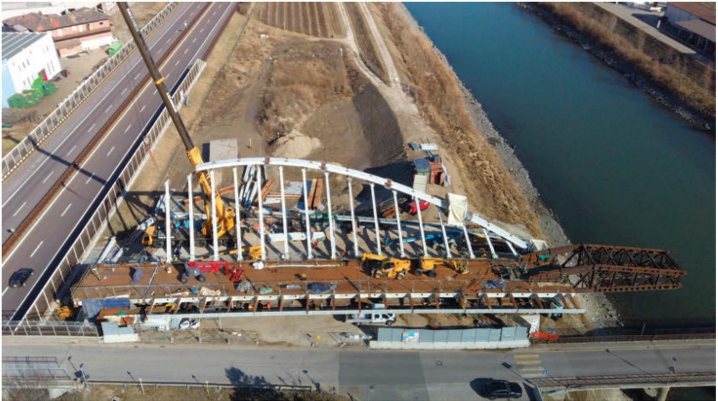
Fig. 25 | Vista delle aree di cantiere durante l'assemblaggio del ponte
