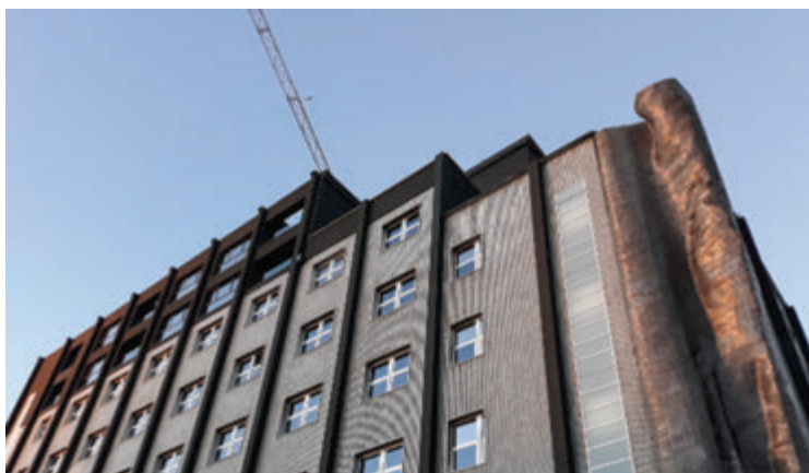
Fig. 10 | Involucro S/R del sopralzo del palazzo residenziale Art Building - Milano zona Greco Pirelli 2017/18
