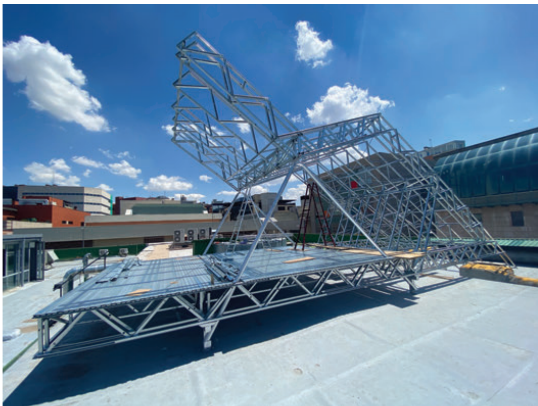
Fig. 11 | Completamento montaggio sottostruttura pannelli 1 © Ignacio Borrego
