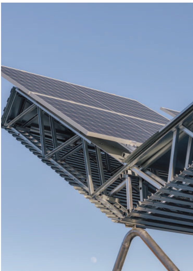
Fig. 4 | Dettaglio struttura 1 © Miguel de Guzmán
