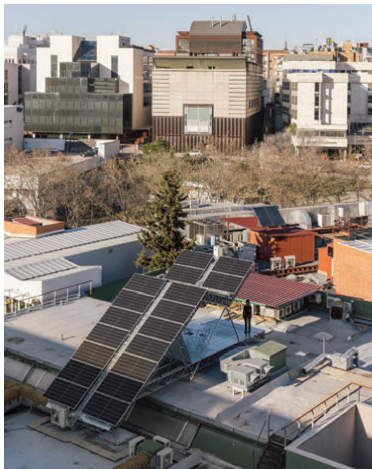
Fig. 1 | Pergola Fotovoltaica - vista dall'alto © Miguel de Guzmán
