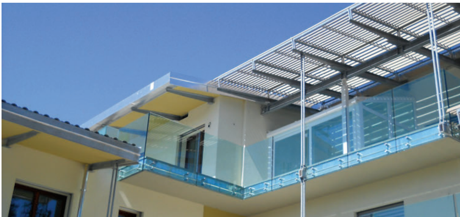
Fig. 16 | Foto sistema d'involucro fronte sud
