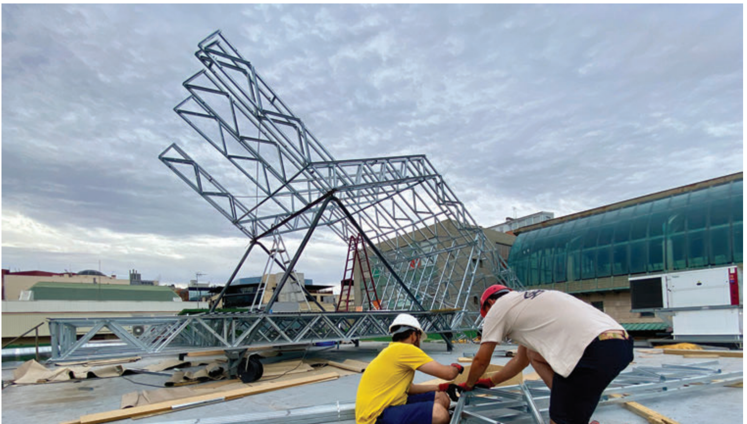
Fig. 10 | Montaggio sottostruttura pannelli 2 © Ignacio Borrego
