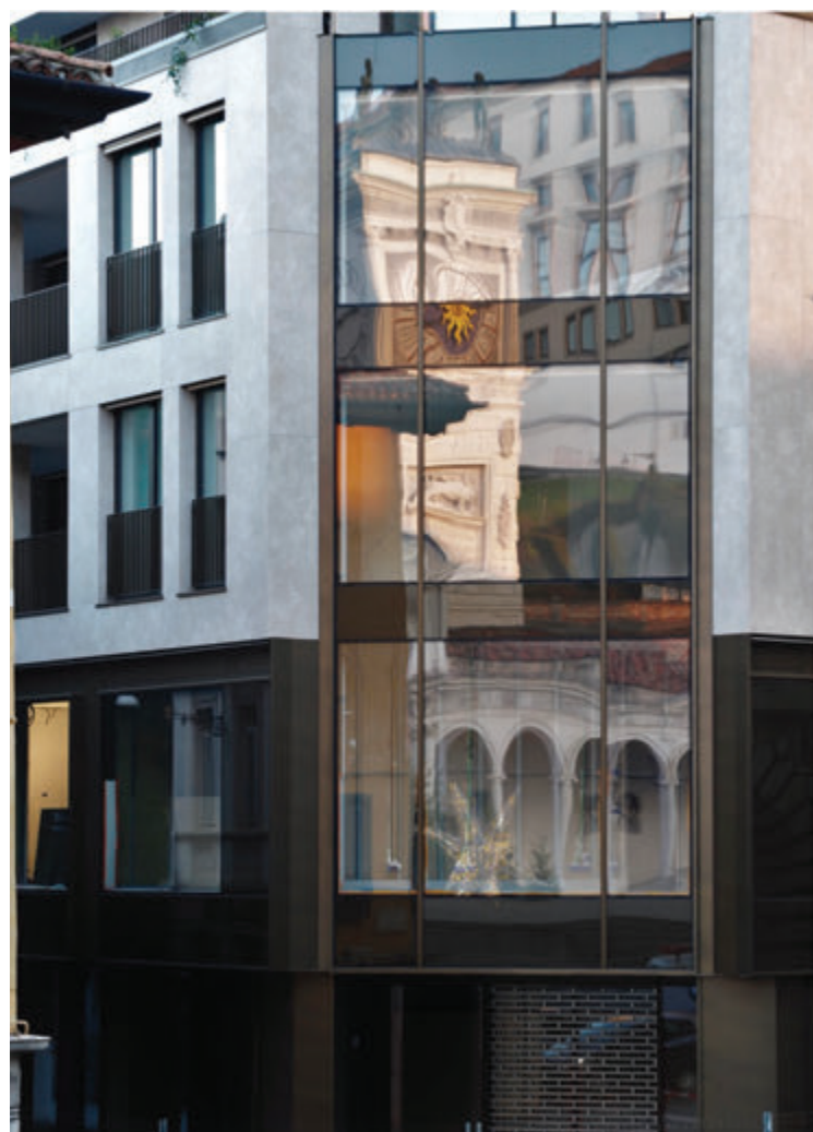
Fig. 4 | Dettaglio dell'angolo dell'edificio che affaccia su piazza libertà
