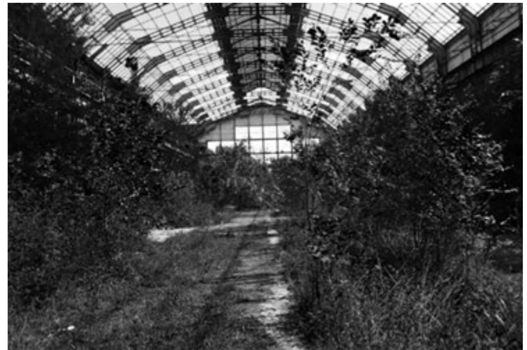
Fig. 69 | L'inesistenza della copertura "Palazzo di Cristallo", Via Rubattino, Milano. Inquadratura della campata, foto eseguita durante il sopralluogo, Aprile 2021
