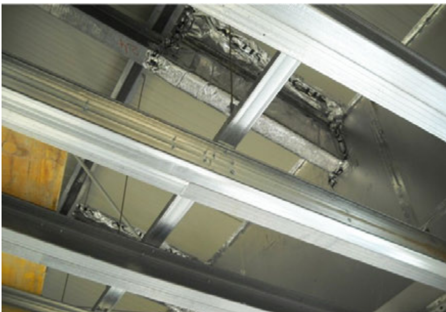
Fig. 19 | Gestione dei ponti termici strutturali mediante fasciatura con iperisolante termoriflettente Actis
