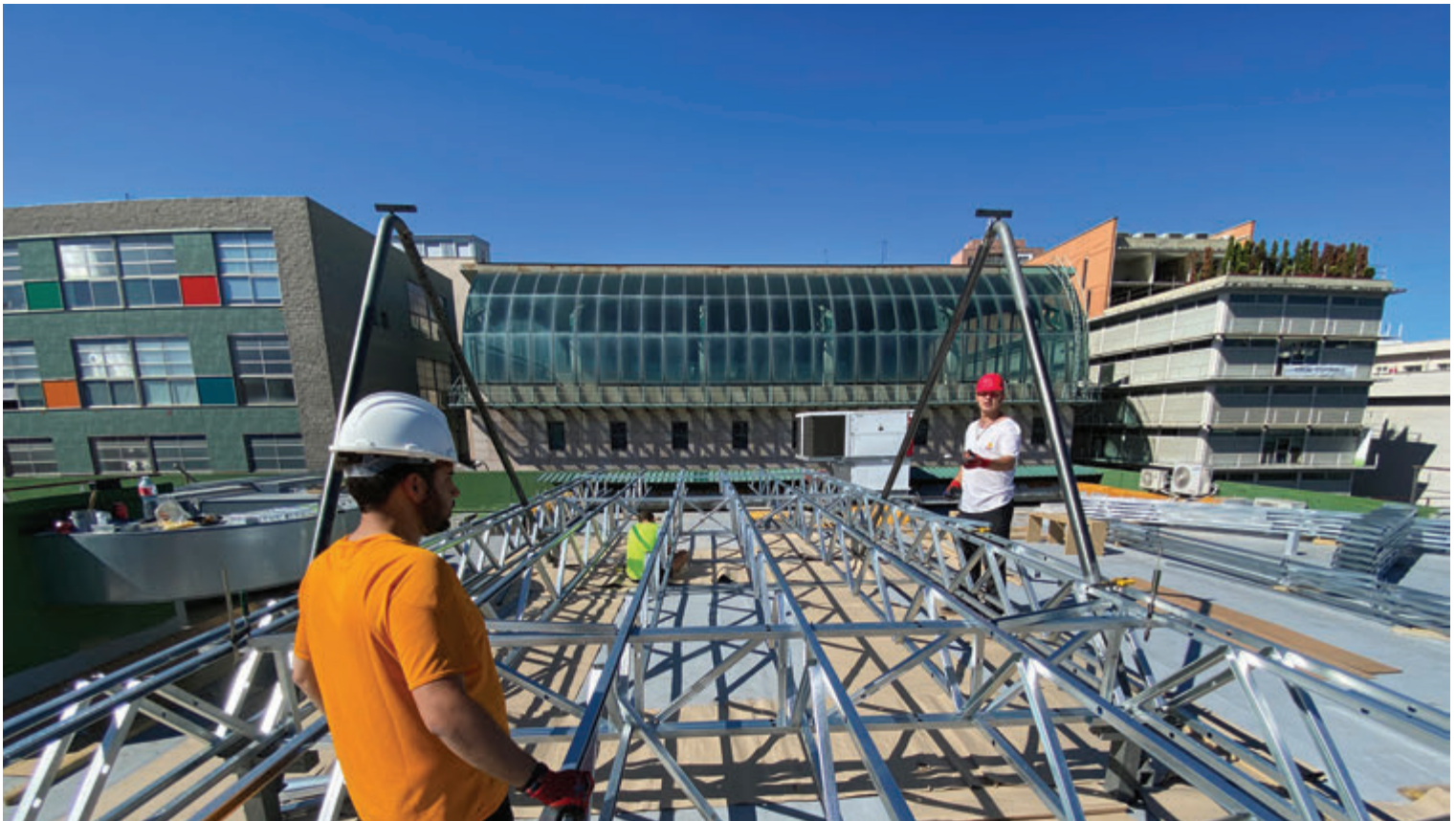
Fig. 8 | Montaggio piattaforma di sostegno © Ignacio Borrego
