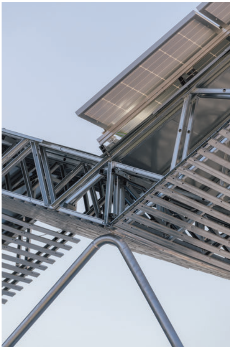
Fig. 5 | Dettaglio struttura 2 © Miguel de Guzmán
