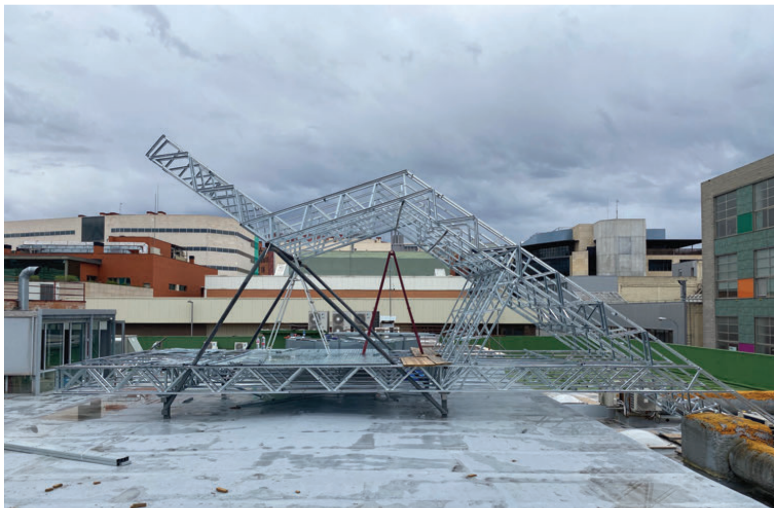
Fig. 12 | Completamento montaggio sottostruttura pannelli 2 © Ignacio Borrego
