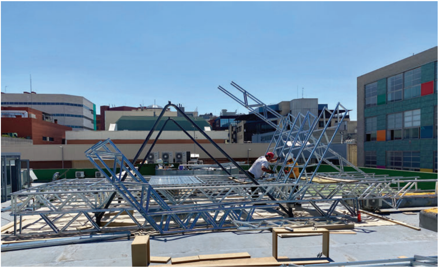
Fig. 9 | Montaggio sottostruttura pannelli 1 © Ignacio Borrego
