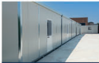
Dormitori da cantiere
