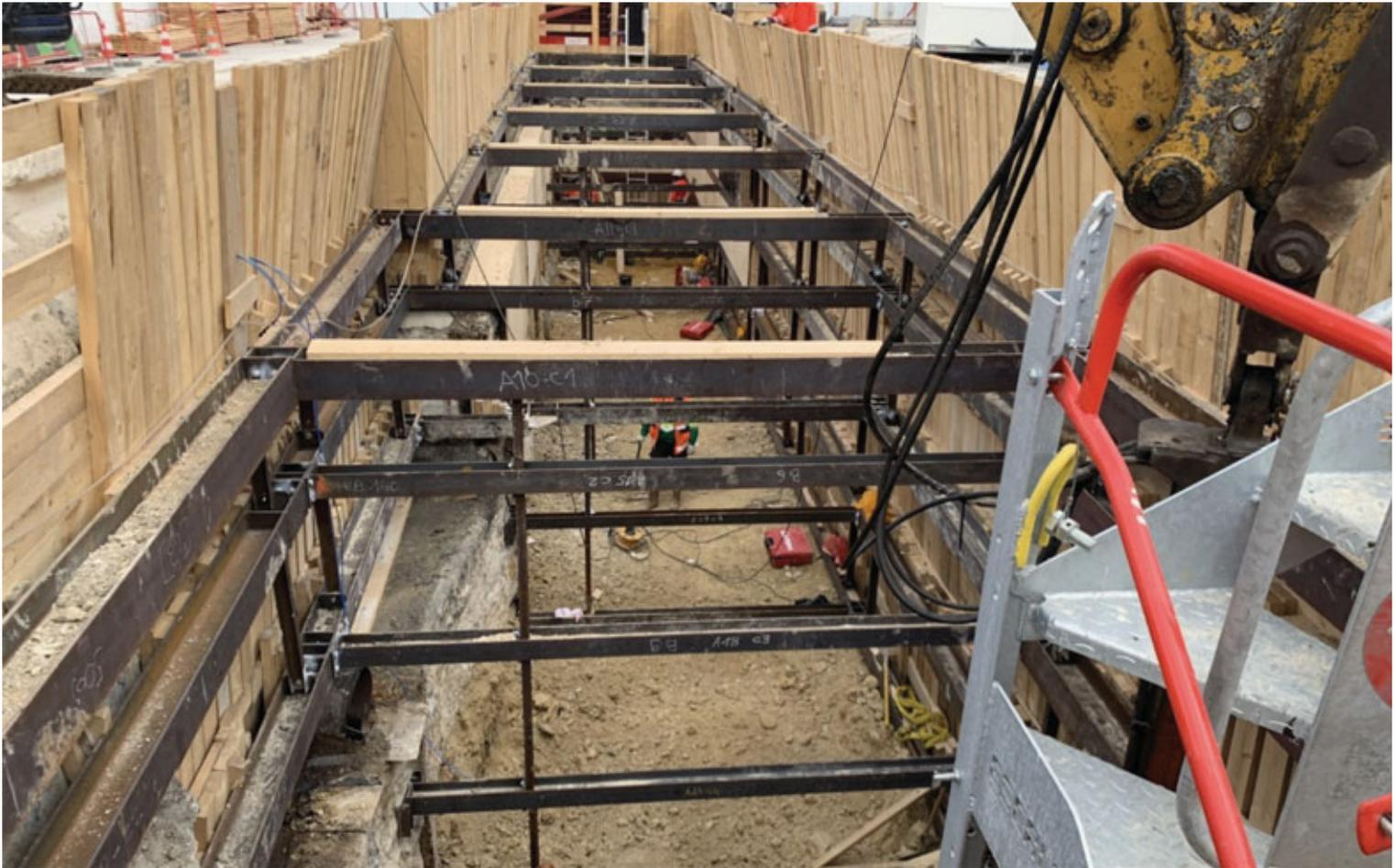
Fig. 21 | Vista di insieme del pozzo della scala esterna della Stazione di Fort d'Aubervilliers
