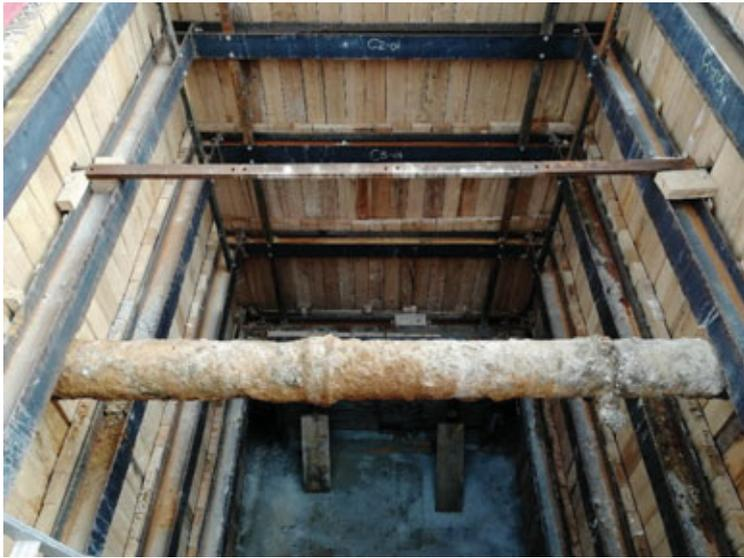
Fig. 3 | Pozzo blindato con telai metallici e palancole di legno nell'ambito del cantiere di deviazione di un collettore ovoidale 200/105 per il prolungamento della linea 11 della metropolitana di Parigi
