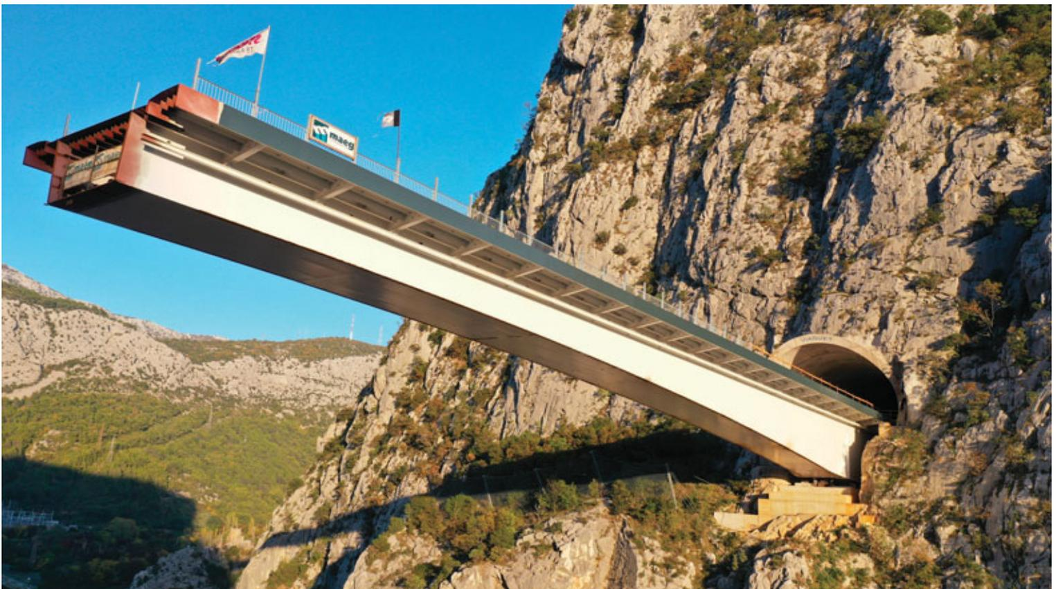
Fig. 12 | Varo di un semi-impalcato completato
