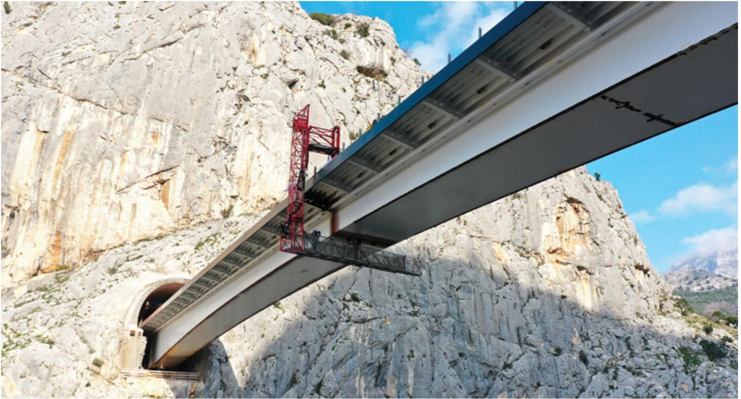
Fig. 15 | Connessione dei due semi-impalcanti mediante saldatura in mezzeria.
