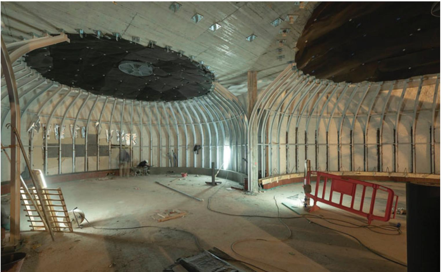
Fig. 22a e 22b | Fase di cantiere con la messa in opera dei profili calandrati in acciaio sui solai in c.a. curvi, che sorreggeranno le lastre di pietra, nelle sale ellittiche ipogee (© Milan Ingegneria).
