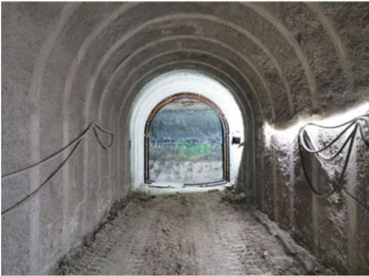
Fig. 6 | Galleria di soccorso PM700 a Meudon, Francia. A sinistra, foto della posa delle cinte con rete elettrosaldata e rivestimento in calcestruzzo proiettato. A destra, foto dell'applicazione della membrana impermeabilizzante.
