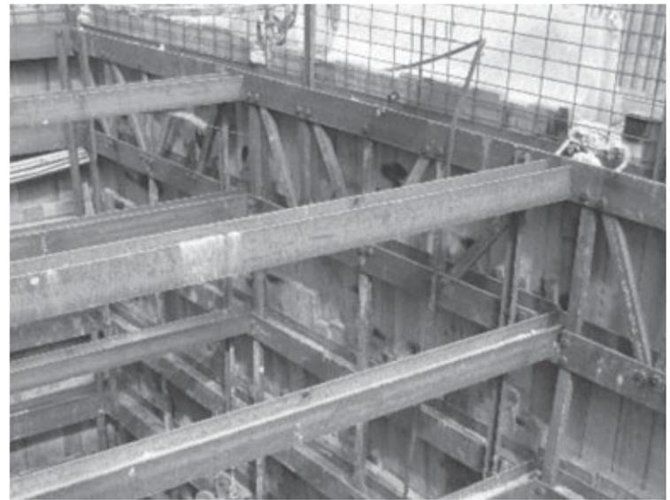
Fig. 12 | Cantiere "Pyramides", uscita di soccorso linea 14 metropolitana di Parigi. Esempio di tiranti di sospensione dei telai e di irrigidimento fra primo e secondo telaio.
