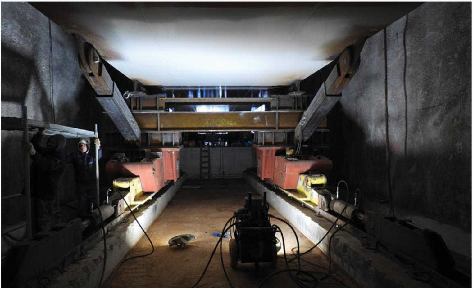
Fig. 9 | Rulliera posteriore mobile in fase di avanzamento dell'impalcato; sono visibili le rotaie di scorrimento
