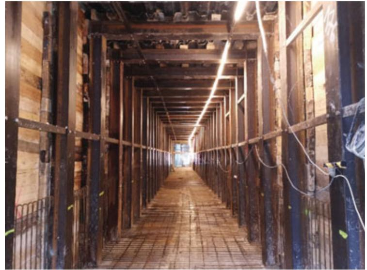
Fig. 4 : Galleria rettangolare con telai metallici e palancole di legno nell'ambito del cantiere di creazione di un sottopasso di servizio all'Aeroporto Charles De Gaulles a Parigi Roissy.
