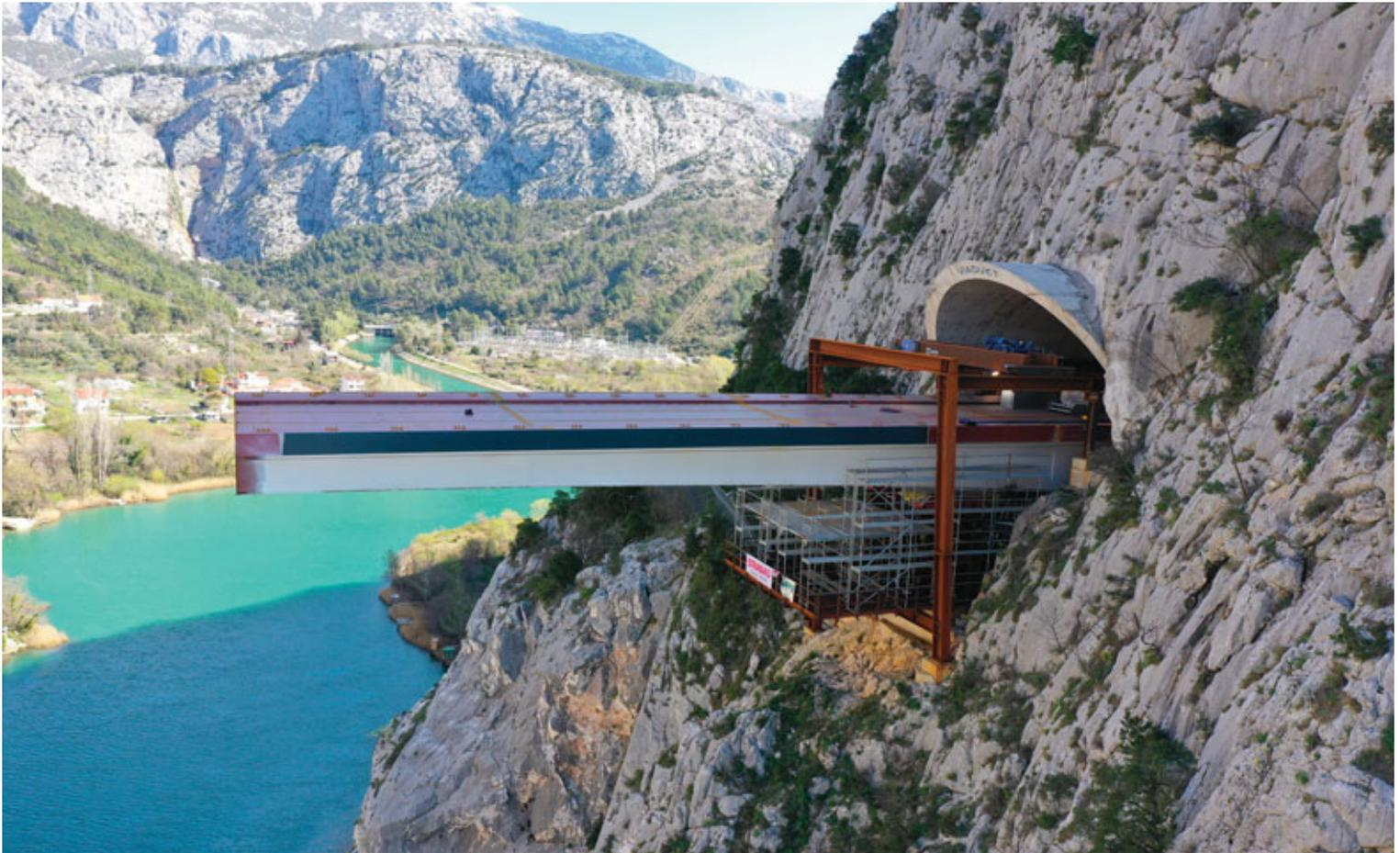
Fig. 11 | Prime fasi di varo di un semi-impalcato
