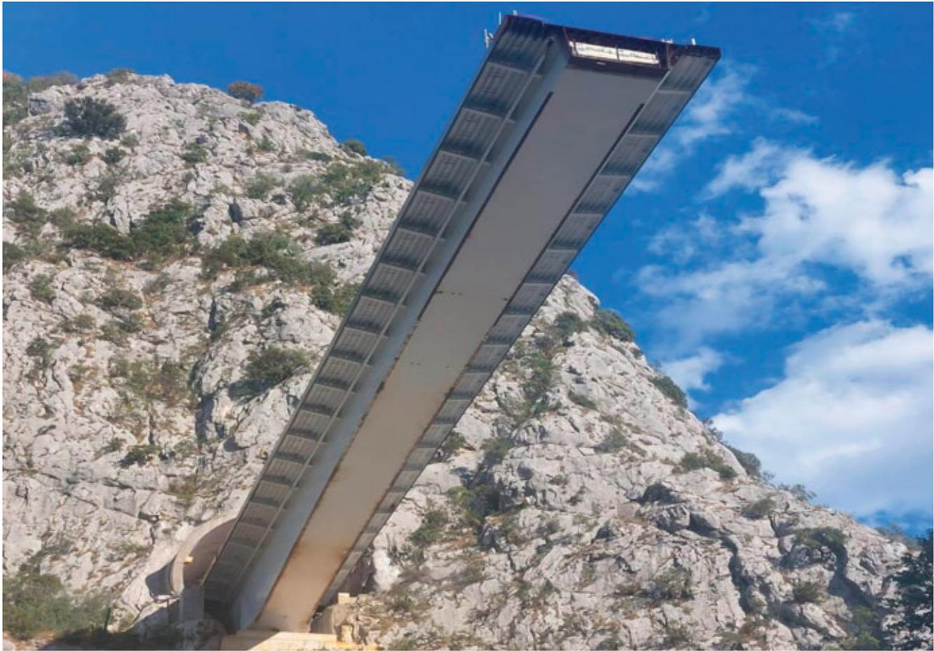
Fig. 13 | Vista da sotto del semi-impalcato in posizione di fine varo
