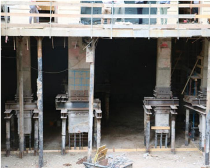
Fig. 17 | Vista dei nuovi pilastri con pali inseriti nel terreno e travi con piastre da cerchiaggio ai pilastri esistenti in c.a. che sono stati separati dalle fondazioni originarie per poter scavare e allungare gli stessi al piano - 2 (© Milan Ingegneria).
