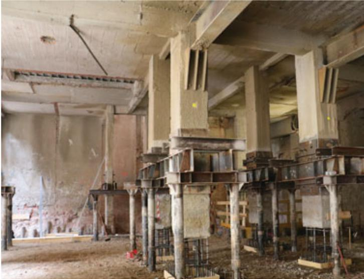
Fig. 19 | Vista dei nuovi pilastri con pali inseriti nel terreno e travi con piastre da cerchiaggio ai pilastri esistenti in c.a., posizionati al centro della pianta dell'edificio esistente, e delle travi in acciaio di rinforzo al solaio esistente del piano terra (© Milan Ingegneria).
