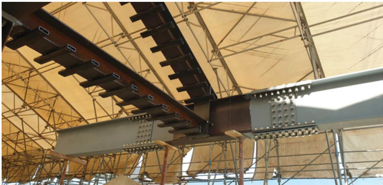
Fig. 27 | Rifacimento del tetto con travi in carpenteria metallica e solaio in X-Lam per alleggerire la copertura rispetto alla precedente (© Milan Ingegneria).
