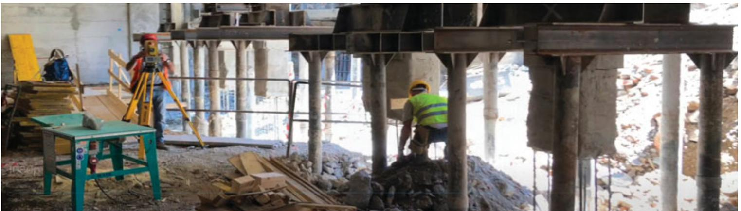
Fig. 21 | Vista della sequenza di pilastri sospesi sul nuovo sistema d'acciaio dei nuovi pilastri temporanei (© Milan Ingegneria).
