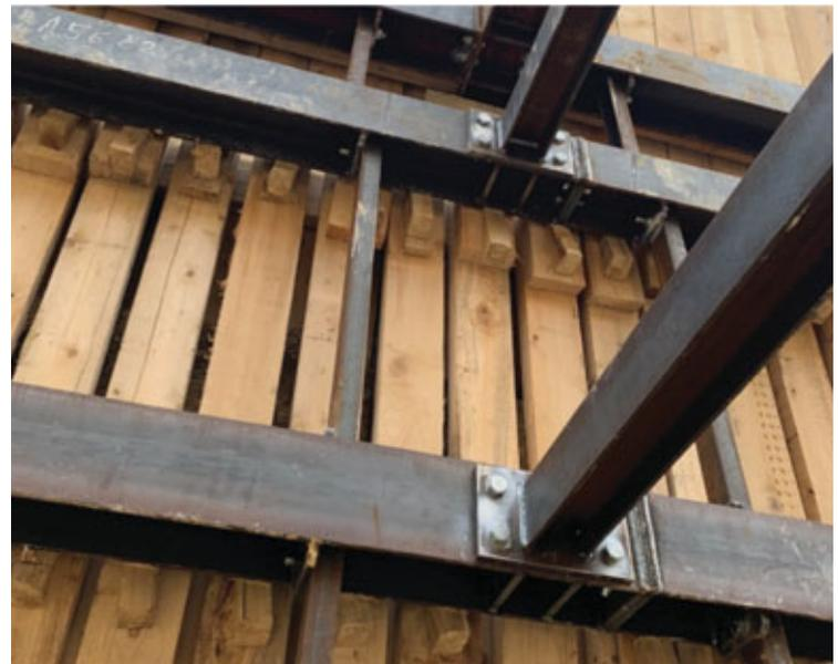
Fig. 8 | Cantiere Stazione Fort d'Aubervilliers - Parigi. Assemblaggio dei puntelli su travi perimetrali. Sostegno secondario in assi di legno.
