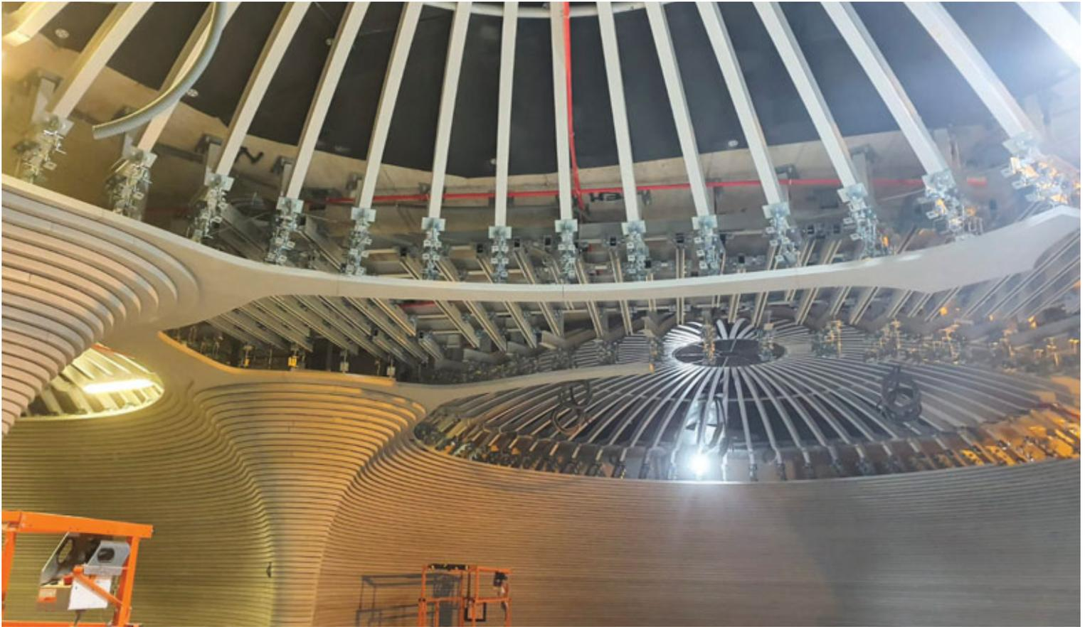
Fig. 23 | Vista interna del cantiere nella fase di messa in opera delle lastre di pietra con il sistema a secco in acciaio (orditura primaria radiale calandrata e sistema secondario puntuale di interfaccia con le pietre) (© Milan Ingegneria).
