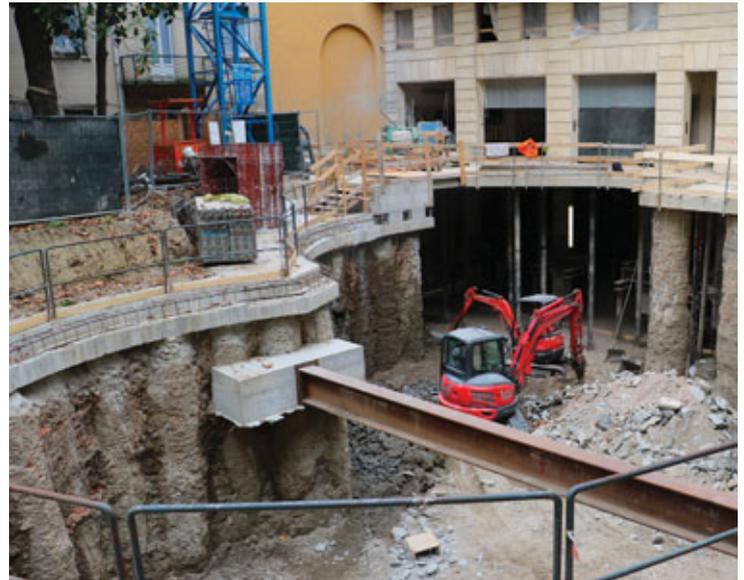
Fig. 18 | Vista del cantiere dello scavo sul giardino con la trave di contrasto fissata sui pali e la "berlinese" per la messa in sicurezza delle aree limitrofe (© Milan Ingegneria).
