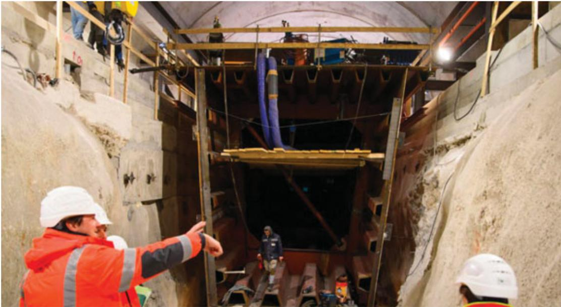
Fig. 7 | Assemblaggio della sezione trasversale "alta" all'interno della fossa in galleria
