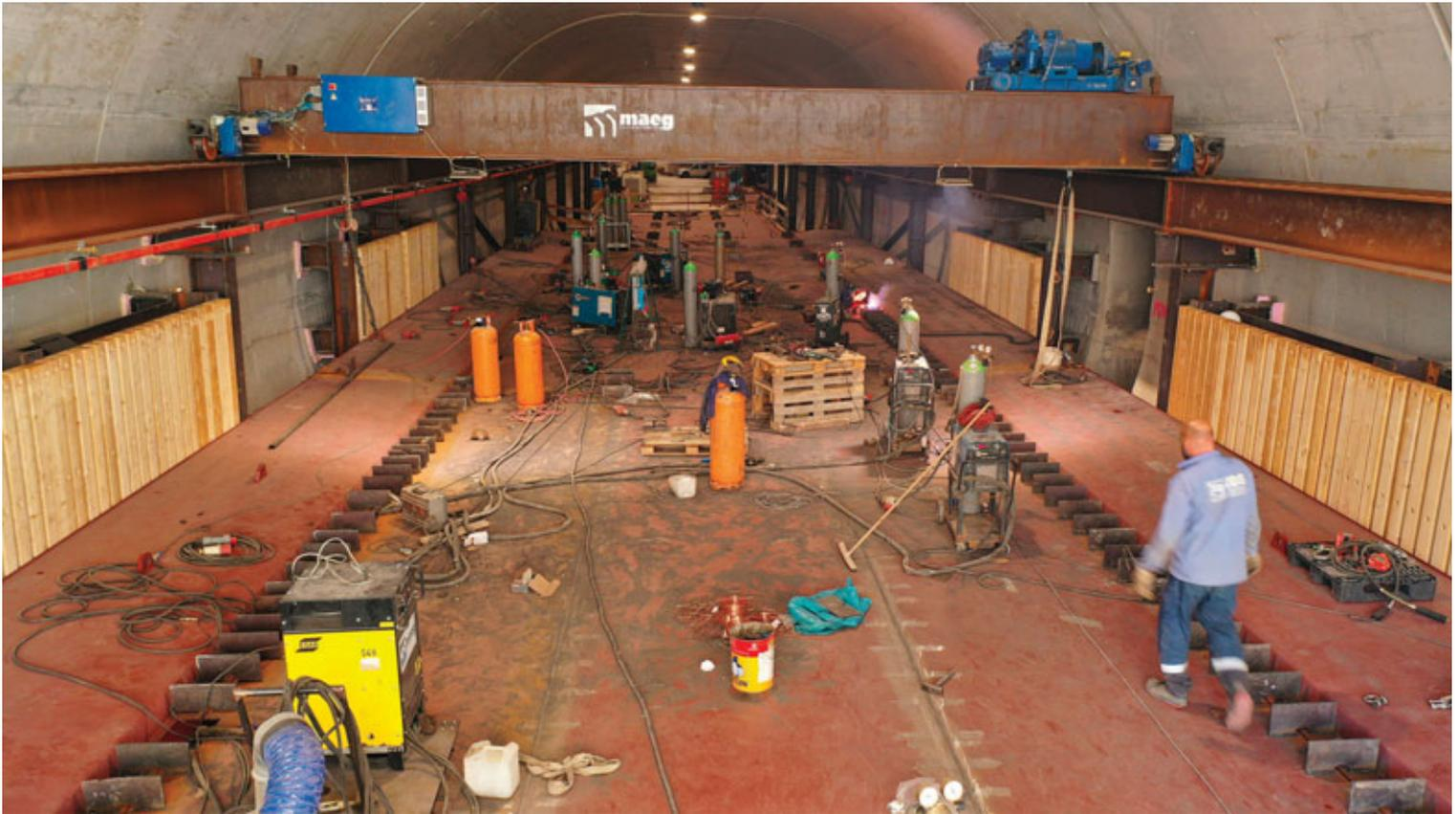
Fig. 8 | Vista dell'estradosso dell'impalcato in campo di montaggio; è visibile la gru a ponte di servizio
