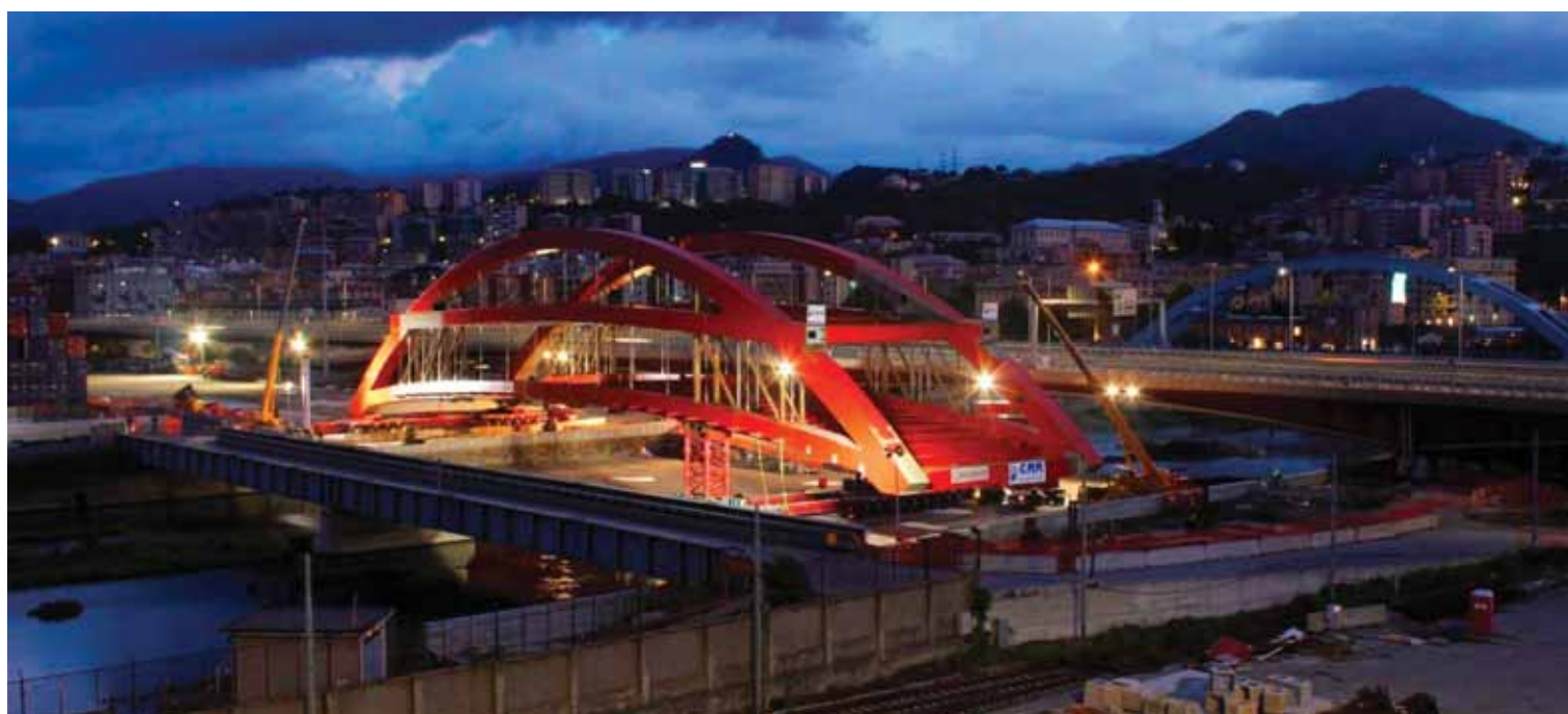
Figura 18 | Foto della porzione ad arco centrale durante le fasi di attraversamento del fiume Polcevera
