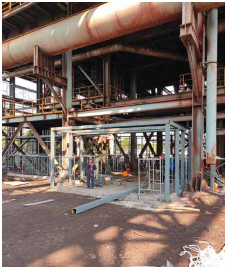
Fig. 26 | Fase di cantiere per la realizzazione del telaio strutturale (© Kokaistudios)
