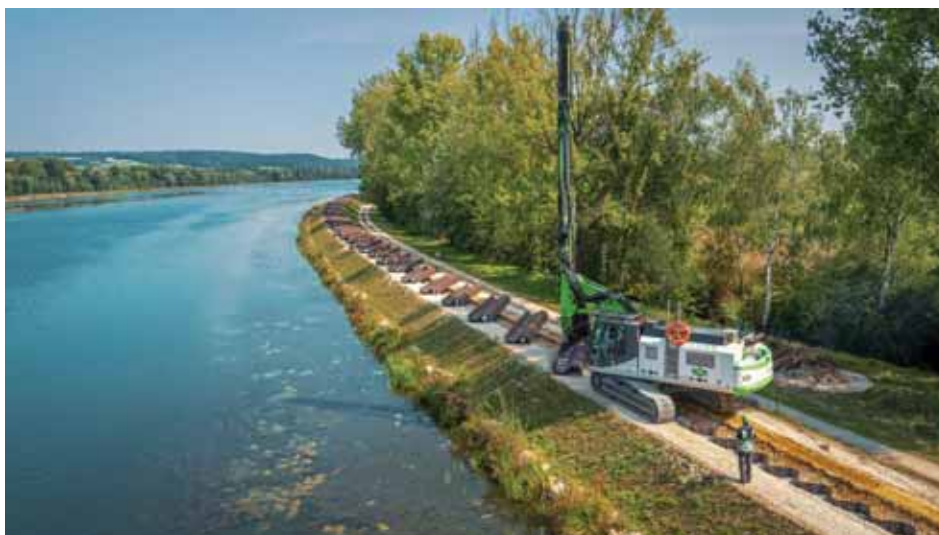
Fig. 2 | Rinforzo di un argine spondale con l'utilizzo palancole in acciaio, Germania ©D&K
