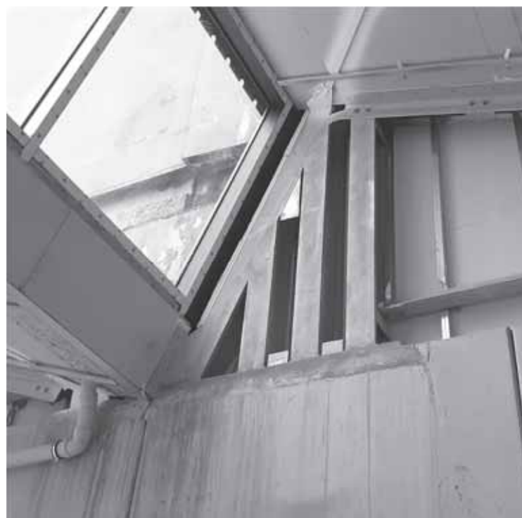
Fig. 11 | Assemblaggio timpani su pre-muri
