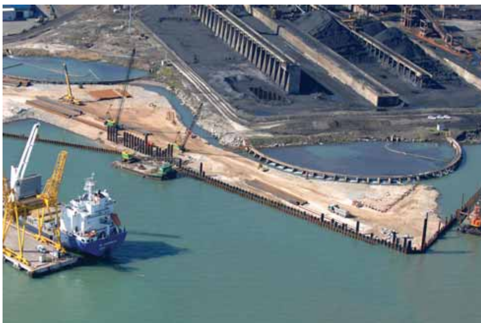
Fig. 1 | Realizzazione di una banchina sita nel porto di Piombino ©ArcelorMittal
