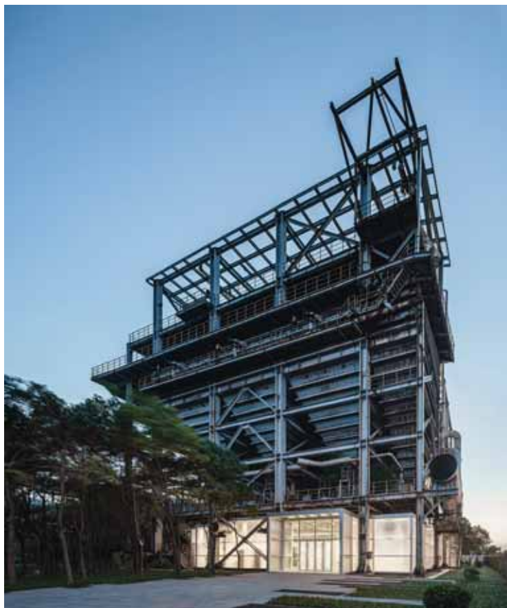
Fig. 27 | Vista d'insieme dell'ingresso est (© Terrence Zhang)
