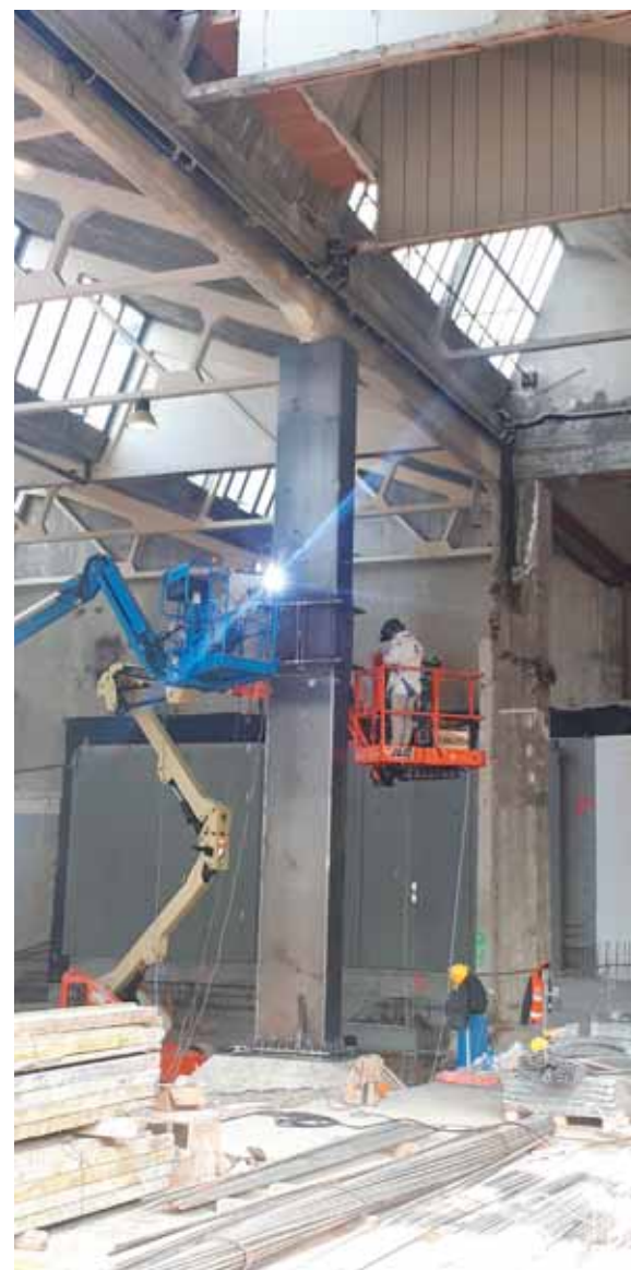
Fig. 7 | Fase di saldatura in opera
