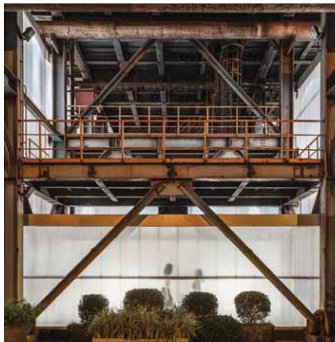
Fig. 24 | Vista di dettaglio del nuovo volume e del rivestimento in polycarbonato (© Terrence Zhang)
