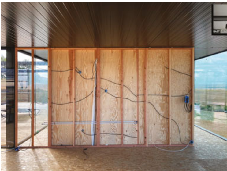
Fig. 23 | Installazione dei travetti in legno.
