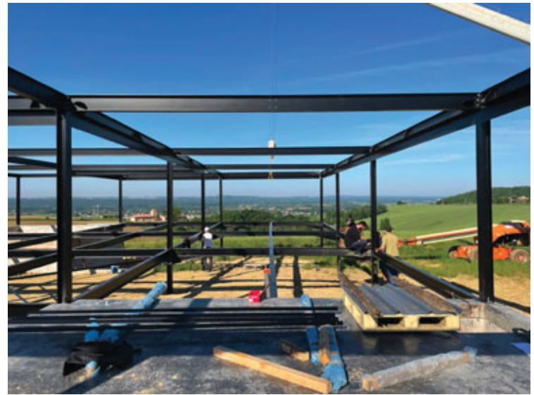
Fig. 19 | Assemblaggio della struttura metallica.
