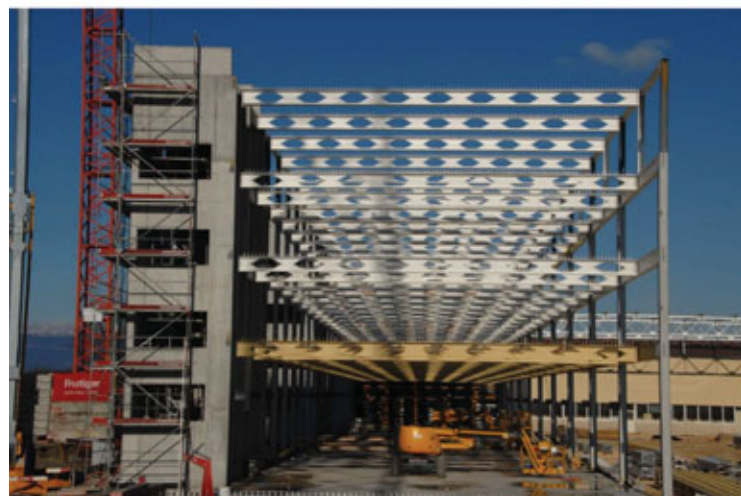
Fig. 7 | Esempi di travi alveolari con fori circolari e sinusoidali per elementi composti con soletta collaborante (fonte ArcelorMittal)
