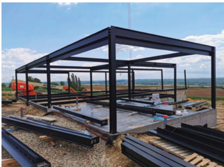
Fig. 10 | Messa in opera della struttura in acciaio.
