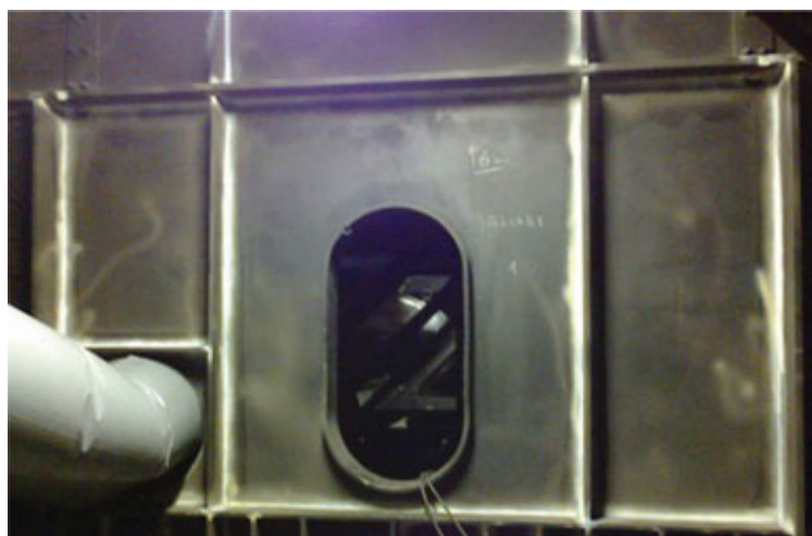
Fig. 8 | Diaframma di pila: nessun difetto rilevato.
