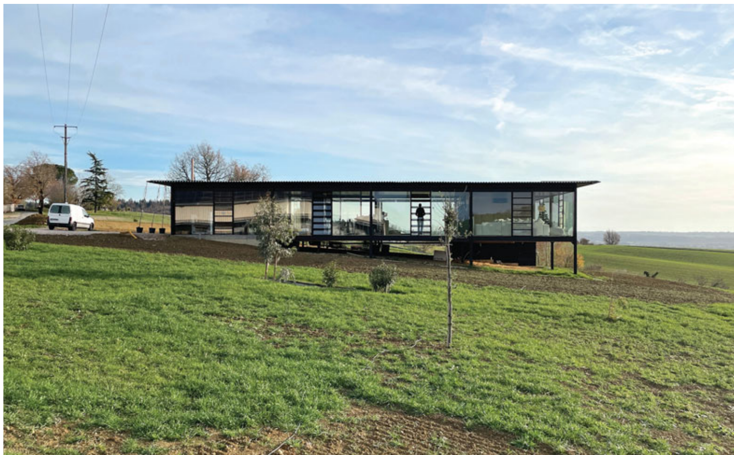
Fig. 1 | Vista complessiva sull'edificio da Nord-Ovest
