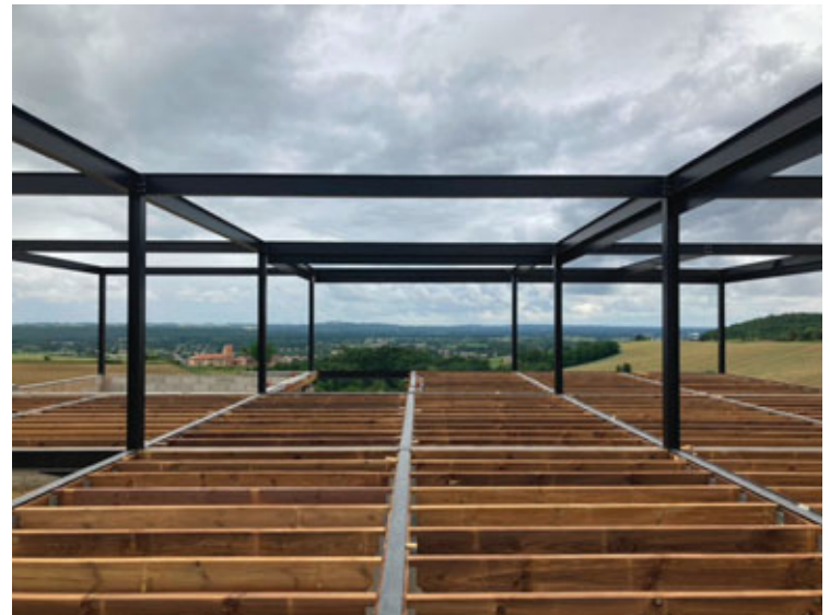
Fig. 24 | Installazione dei travetti in legno.
