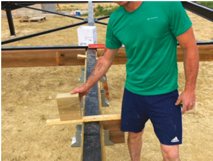
Fig. 22 | Installazione dei travetti e delle staffe metall
