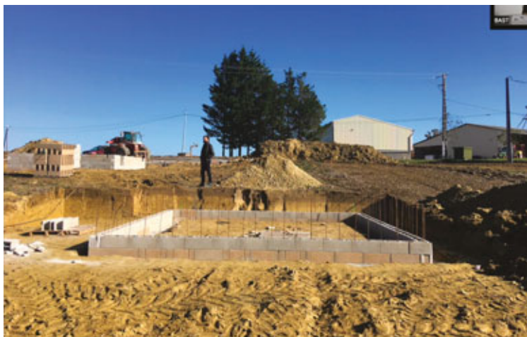
Fig. 9 | Posa in opera dei blocchi in calcestruzzo per la realizzazione dei volumi murari.
