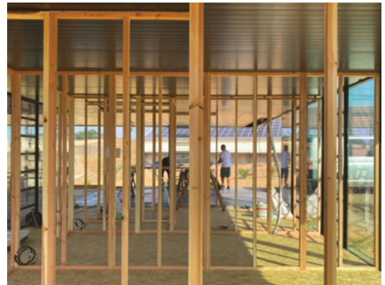
Fig. 25 | Installazione dei pannelli per divisioni interne degli ambienti.
