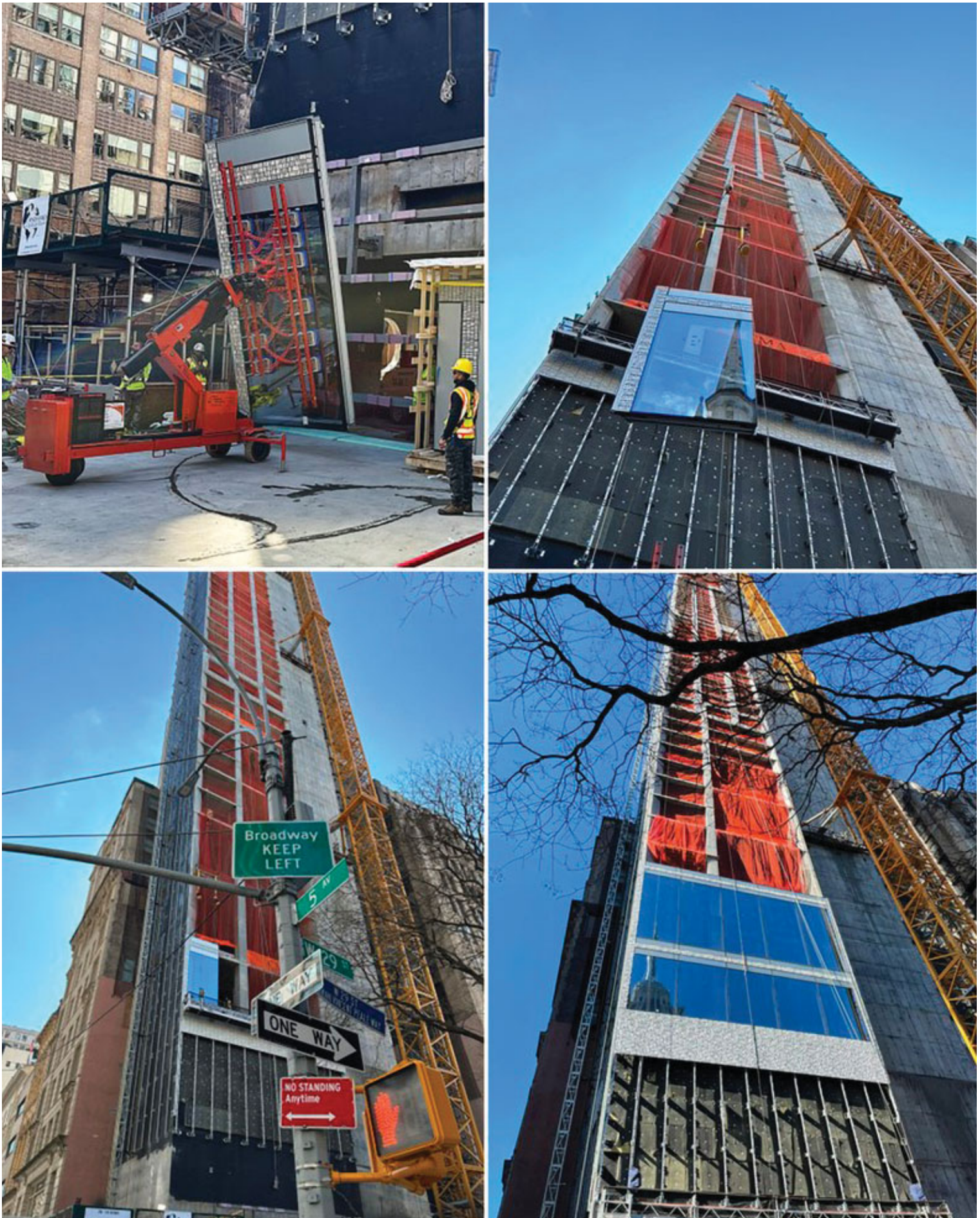
Fig. 4 | Installazione della prima cellula vetrata, prospetto Nord (fine marzo 2024)
