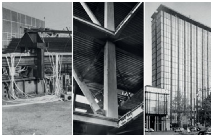
Fig. 16 – Collaborazione tra Centro Carpenteria Dalmine e Cmf (1960-1968): le prove di carico e il montaggio della carpenteria della sede Rai di Torino (Fondazione Dalmine).
