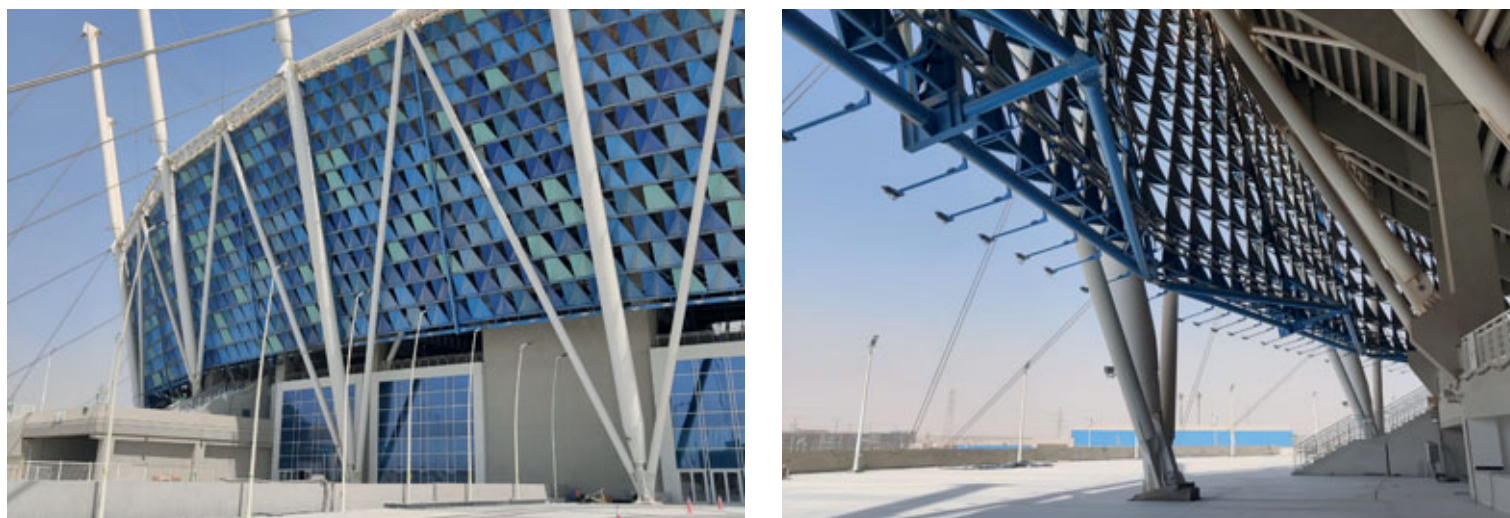
Fig. 11: Rivestimento laterale dello stadio
