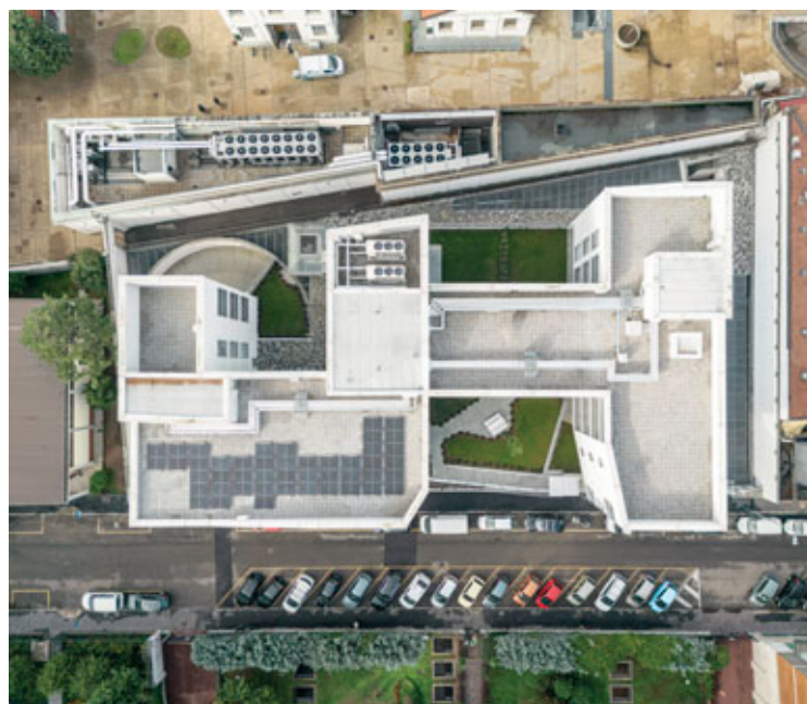
Fig. 2. Vista aerea dell'edificio Pichi 12 e delle corti destinate a verde. © Nicola Colella/Park Associati
