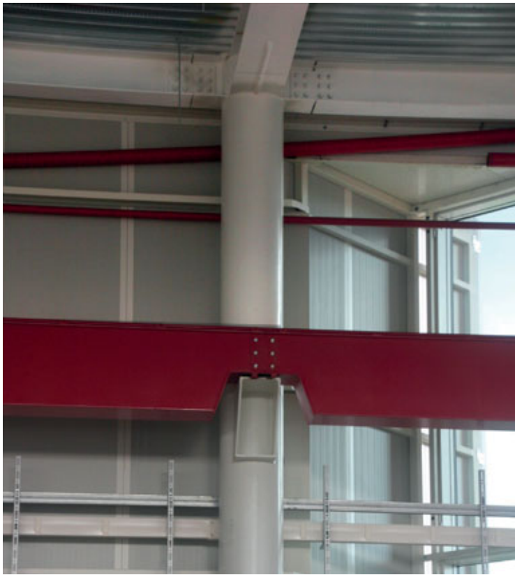
Fig. 11 - Vie di corsa sostenute dalle colonne © Redesco Progetti
