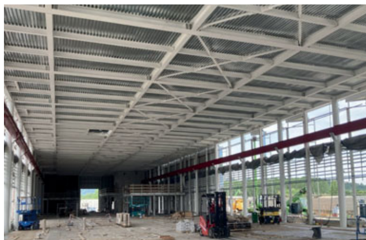
Fig. 7 - Intradosso dell'impalcato del mezzanino © Redesco Progetti
