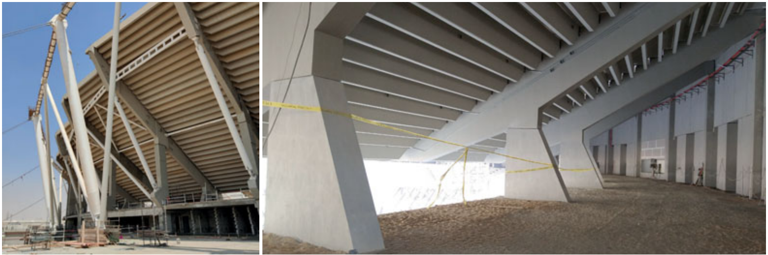
Fig. 4: Immagine delle tribune realizzate in cantiere
