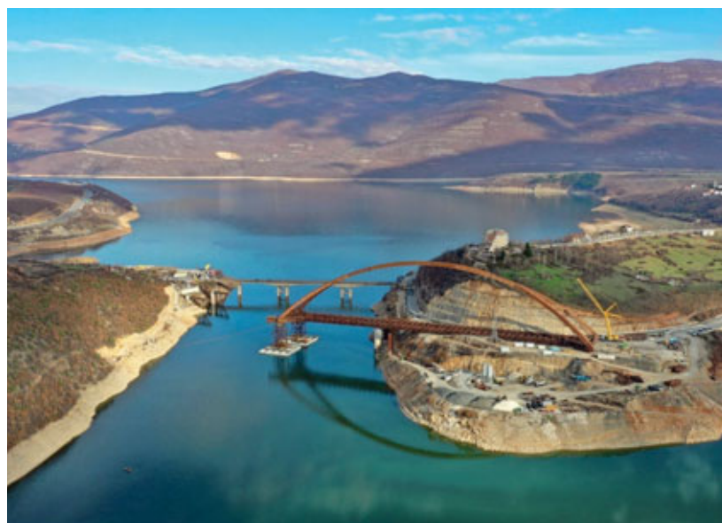
Fig. 6 - Spinta posteriore con tiro inverso di strand-jacks | Rear push with reverse pull of strand-jacks
