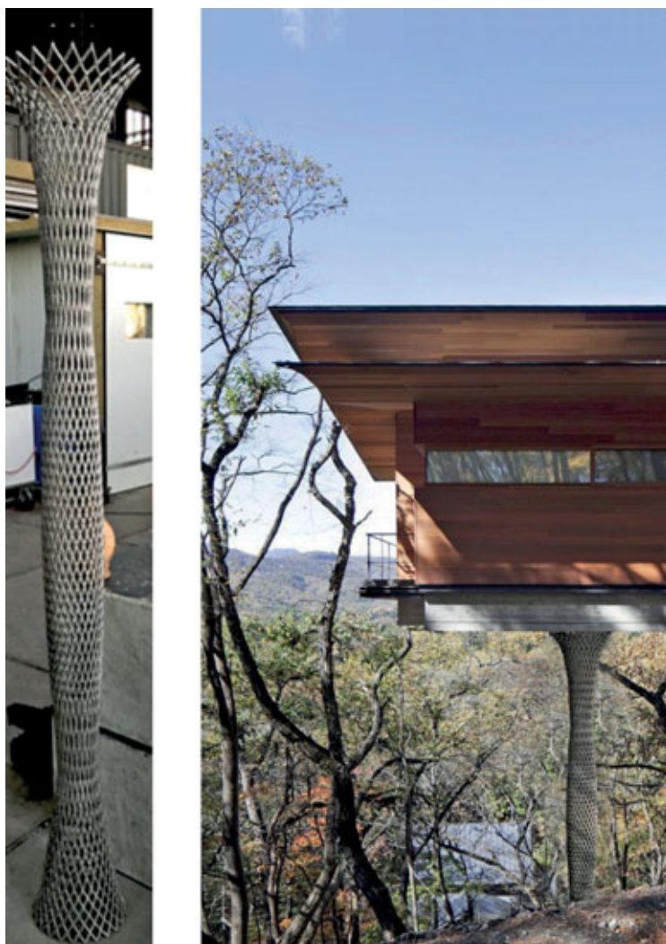
Fig. 11 - WAAM diagrid column realizzata dall'Università di Bologna.
