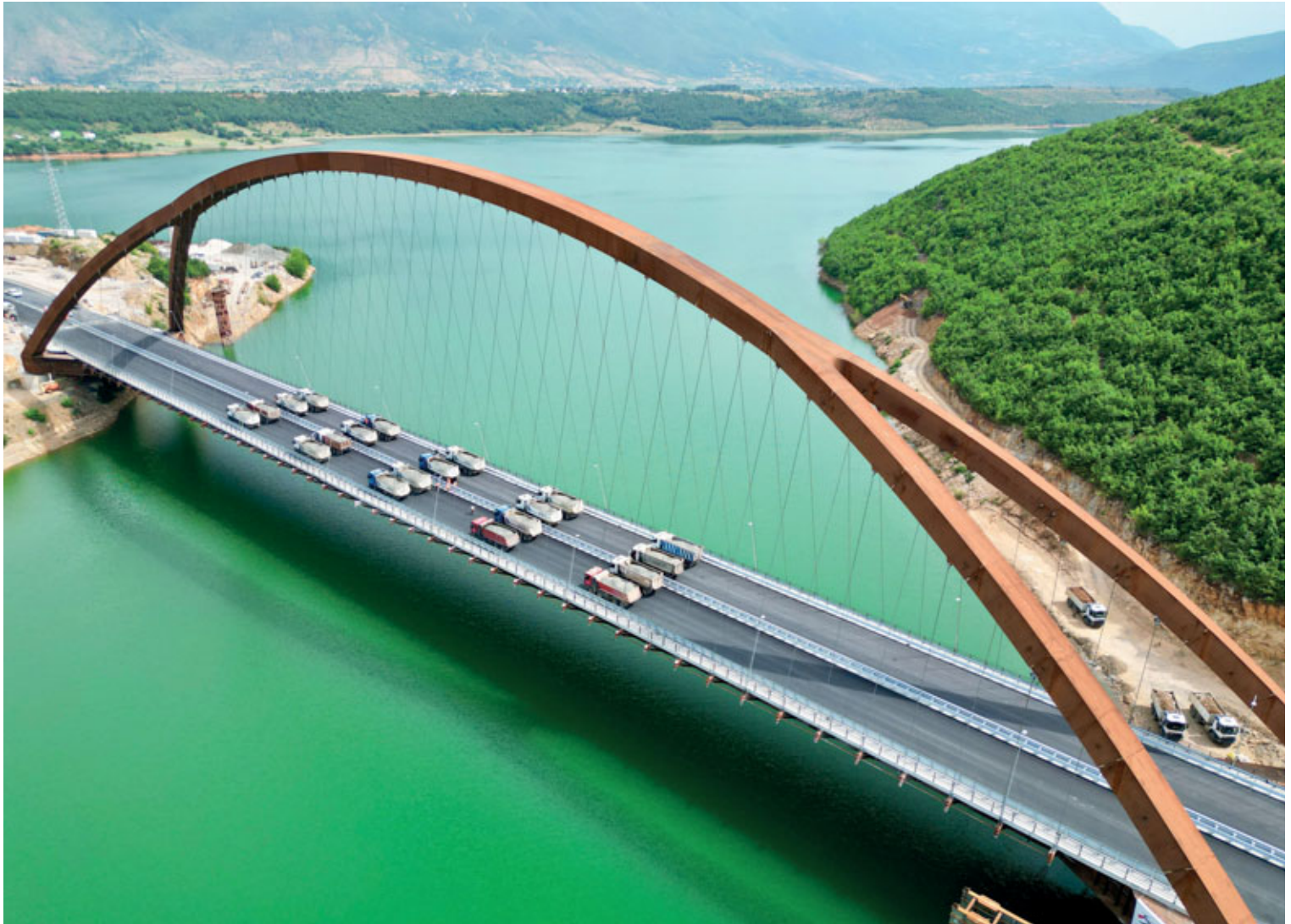
Fig. 1 - Il collaudo - prove di carico | Loading test of New Drini Bridge
