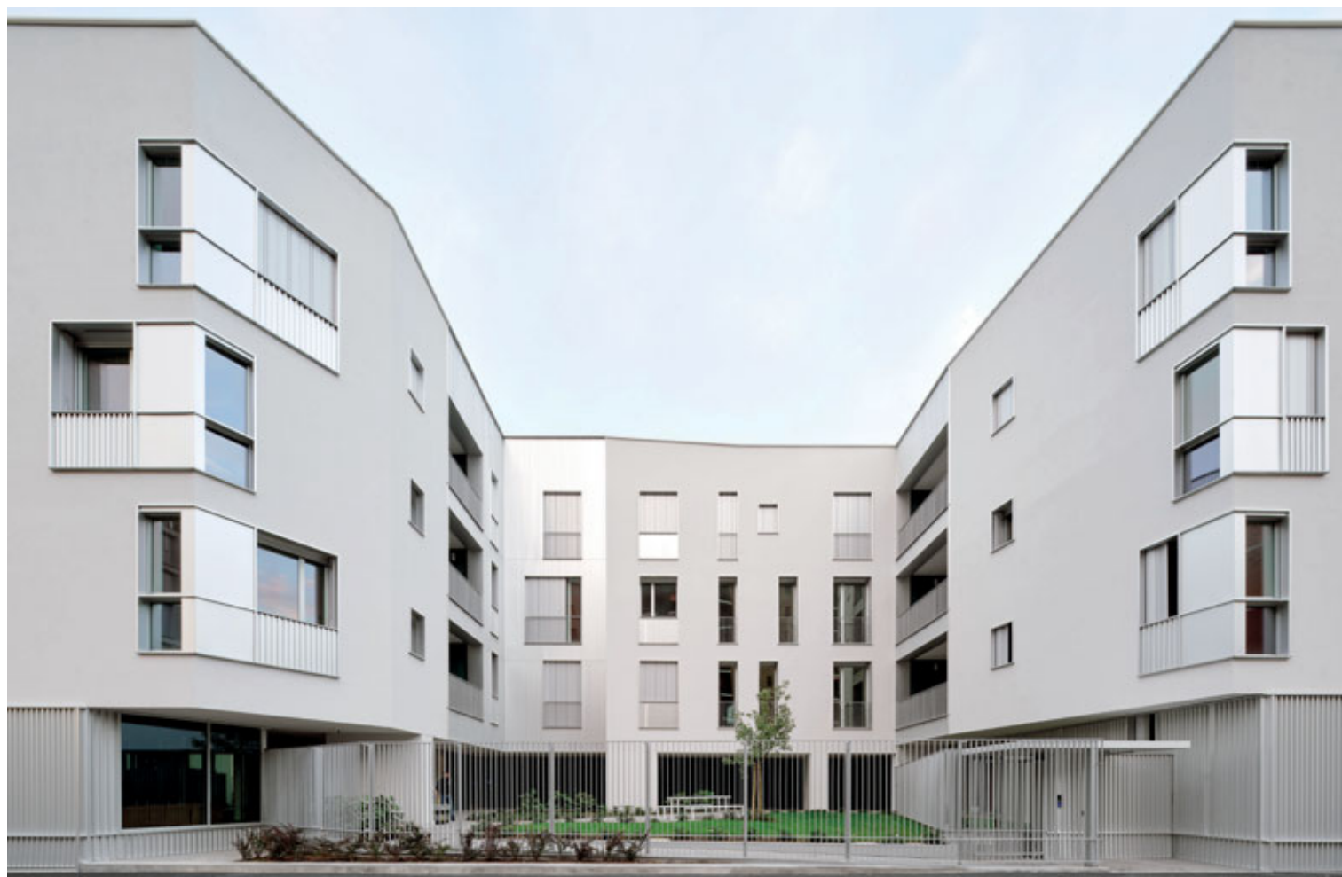
Fig. 1. Edificio Pichi 12, studio Park Associati, prospetto su via Pichi. © Francesca Iovene
