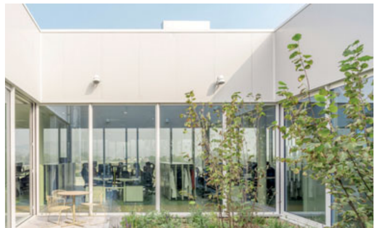
Fig. 3 - Vista di un cavedio sul piano uffici © Studio Campo
