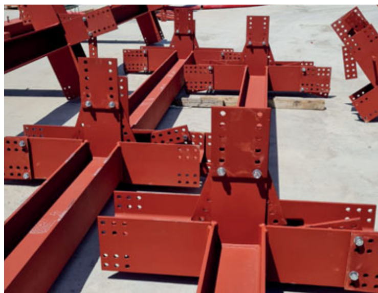
Fig. 25. Assemblaggio della piastra inferiore prima del sollevamento del pilastro. © Carpenteria S.A.C.I.F. Srl
