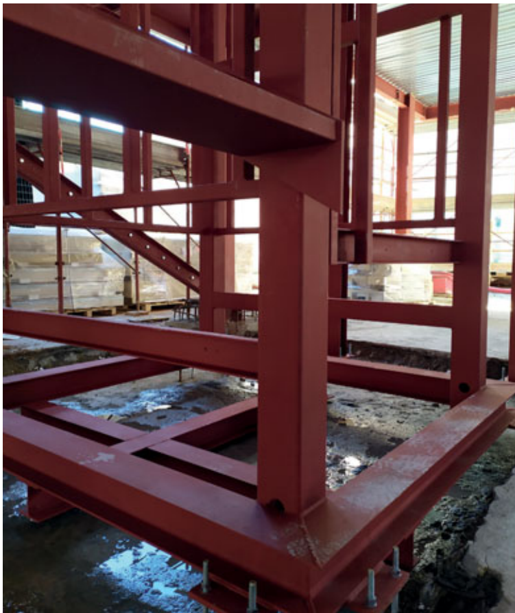
Fig. 39. Attacco a terra della struttura portante del vano ascensore © Carpenteria S.A.C.I.F. Srl
