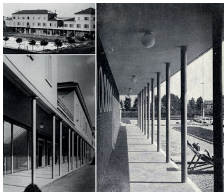
Fig. 3 – Impiego dei tubi Dalmine in edilizia nel primo Novecento (1906-1945): l’impiego delle “Colonne tubolari Mannesmann” in alcuni edifici degli anni Trenta nella company town di Dalmine (Fondazione Dalmine).
