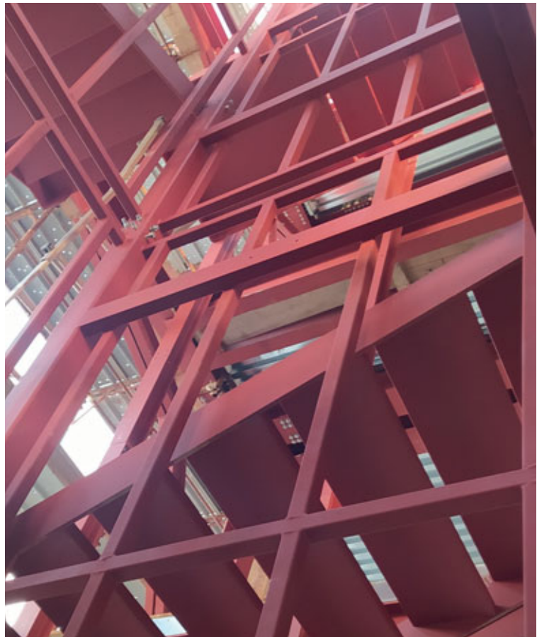
Fig. 38. Struttura portante dell'ascensore e profili a sezione più ridotta a sostegno della chiusura del vano. © Carpenteria S.A.C.I.F. Srl
