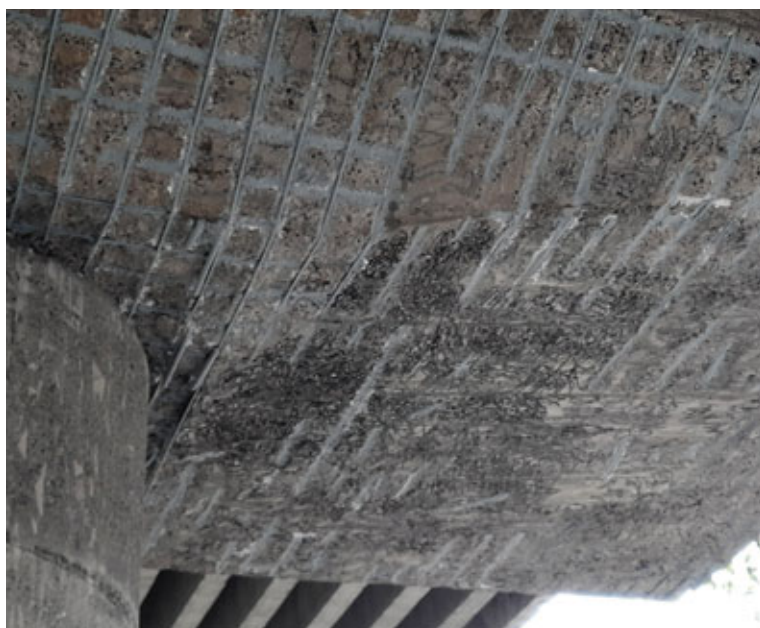
Fig. 3 - risanamento ferri armatura con Zinga - Darfo (BS) SS42
