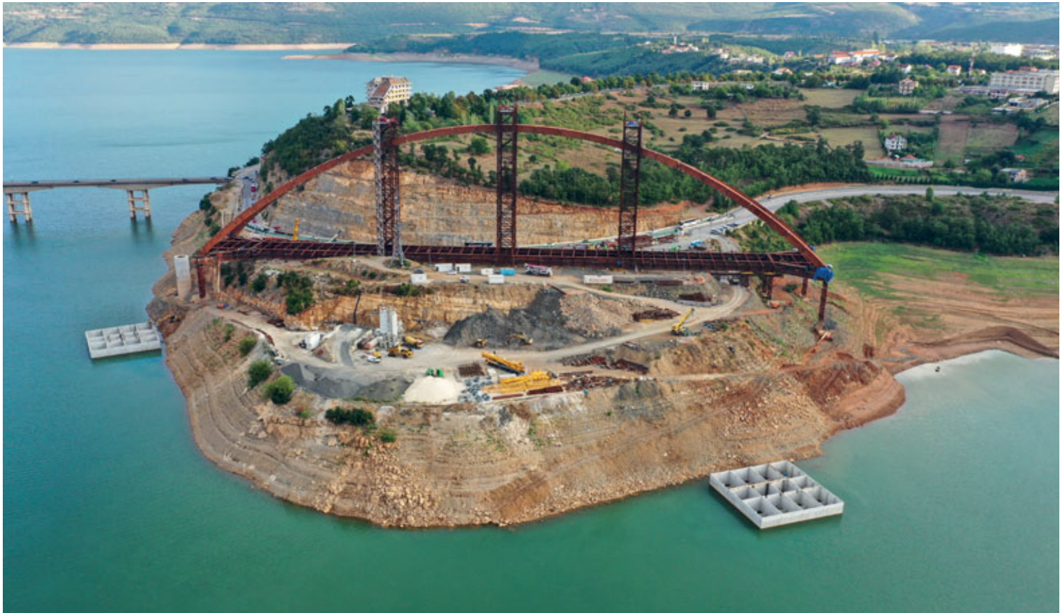
Il cantiere del ponte Drini sul lago Fierza | The Drini bridge construction site on Lake Fierza
