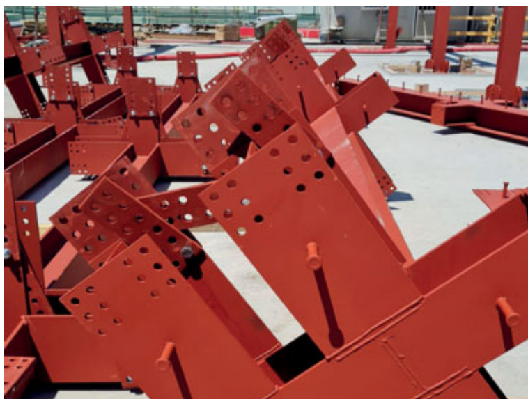
Fig. 24. Nodi strutturali assemblati off-site e trasportati on-site. © Carpenteria S.A.C.I.F. Srl
