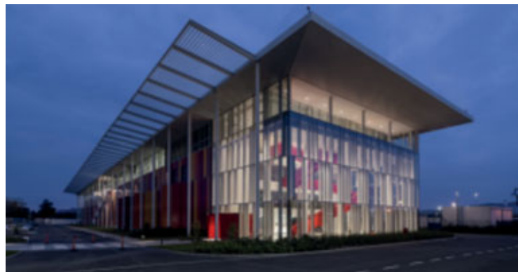
Fig. 15 - Vista dell'edificio completo © E. Cano
