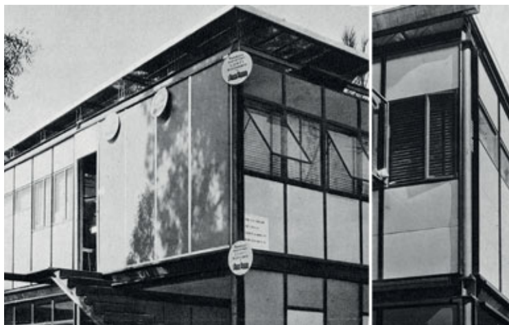
Fig. 15 – Prima fase operativa del Centro Carpenteria Dalmine (1952-1960): il prototipo di un sistema per ossature prefabbricate di edifici multipiano sviluppato con la Feal nel 1959 (Fondazione Dalmine).
