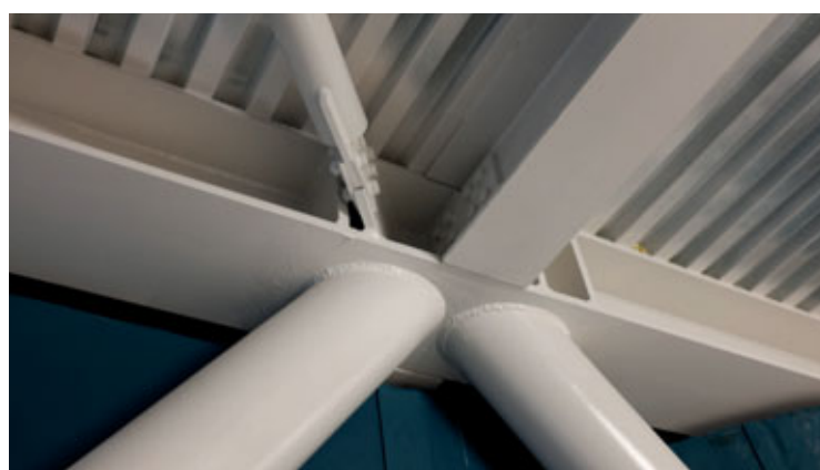
Fig. 6 - Nodo superiore di una trave Warren © Redesco Progetti
