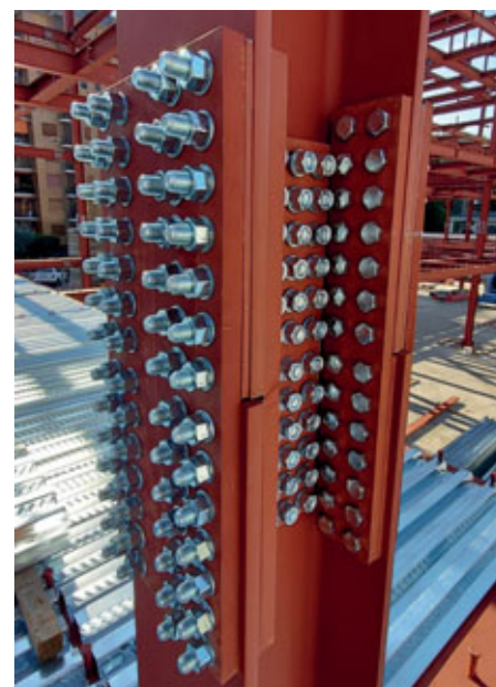
Fig. 32. Giunto a completo ripristino pilastro/pilastro. © Carpenteria S.A.C.I.F. Srl
