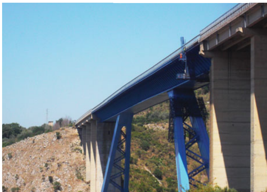
Figura 1 - Viadotto Platano (RA 5)
