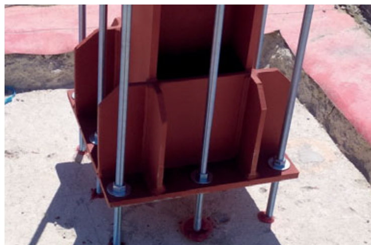
Fig. 15. Fotografia di cantiere del dettaglio della base del pilastro. © Carpenteria S.A.C.I.F. Srl
