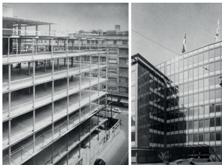
Fig. 14 – Progetto e costruzione della sede della Sidercomit (1958-1960): il sistema resistente con i solai in latero-cemento e la realizzazione dell'involucro (Fondazione Dalmine).
