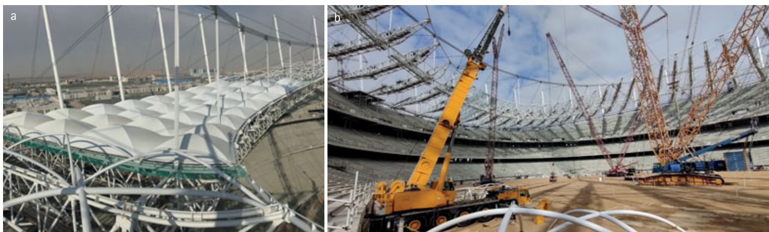
Fig. 10: a) Membrana, b) Archi di supporto
