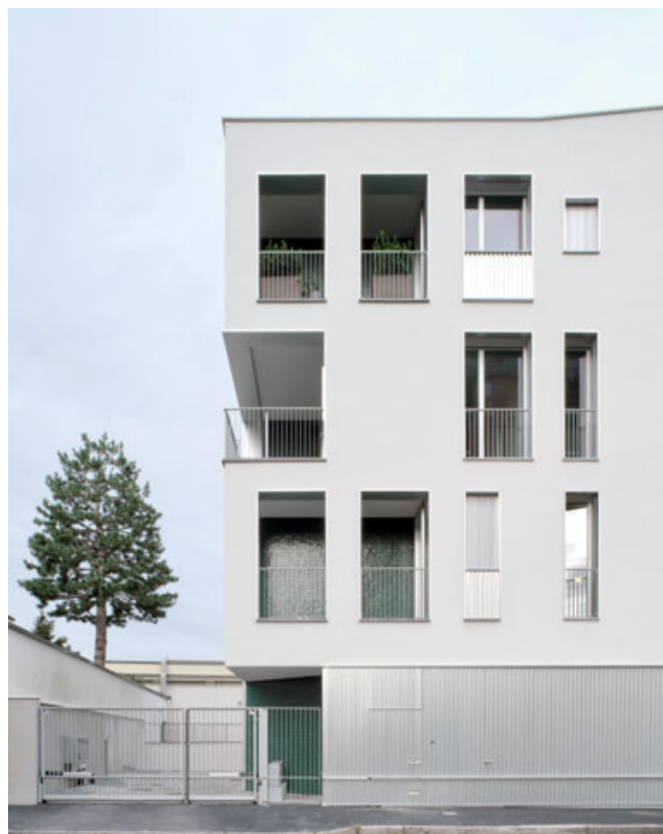
Fig. 9. Pieni e vuoti della facciata; rivestimenti interni delle logge. © Francesca Iovene
