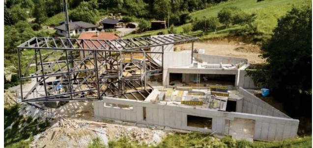
Cantiere in fase di costruzione
