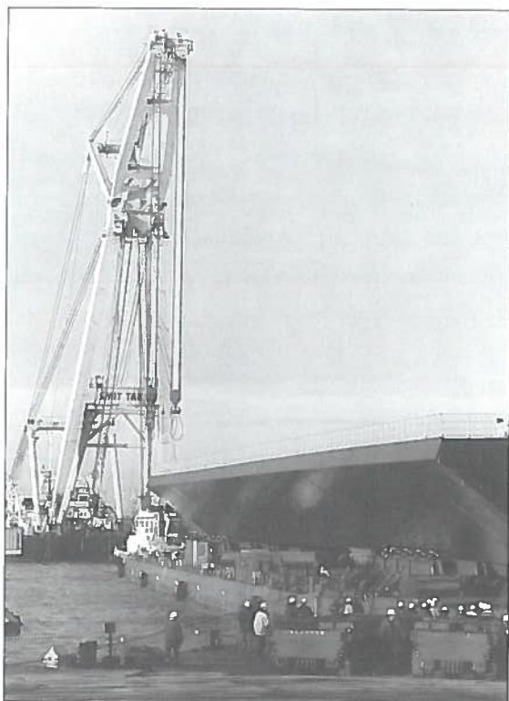
Fig. 6 a,b,c,d,e Installazione della travata n. 2.
