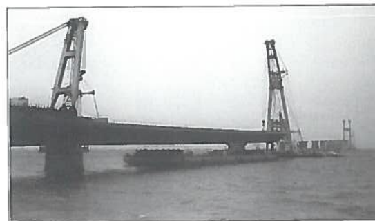
Fig. 5 Fasi di sollevamento di una travata del viadotto lato Halskov.
