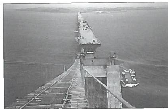
Fig. 12 Il viadotto lato Halskov prima dell'installazione della travata n. 14.
