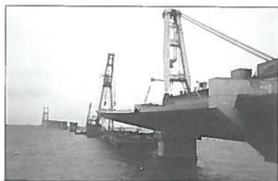
Fig. 8 Sollevamento della travata n. 14, travata di arrivo sul blocco d'ormeggio.
