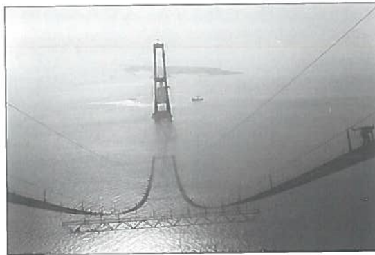
Fig. 15a,b,c,d,e Fasi di installazione della passerella di servizio (catwalks), della sella di bloccaggio dei cavi (cable clamps) e dei tiranti di sospensione (hangers).
