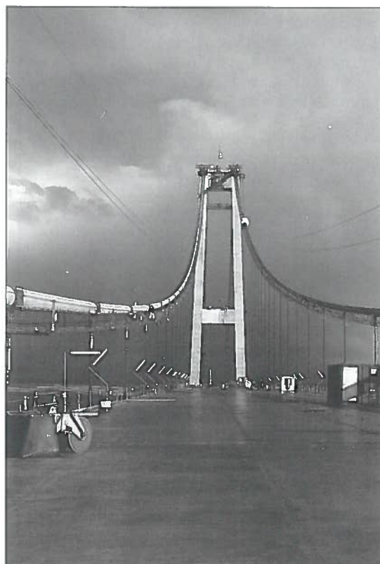
Fig. 23a, b Apertura dei giunti delle lamiere di fondo indotti dalla curvatura (verso l'alto) dell'impalcato nelle prime fasi di montaggio.
