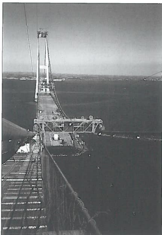
Fig. 16a, b, c Fasi di installazione di un concio della travata del ponte sospeso.
