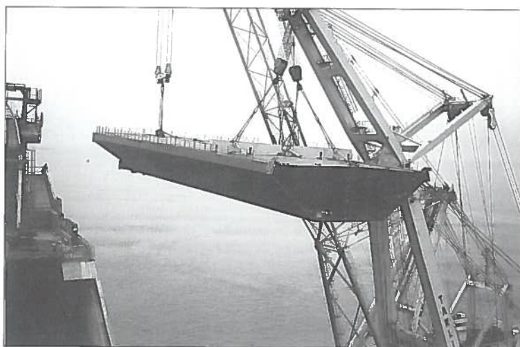
Fig. 8 Sollevamento della travata n. 14, travata di arrivo sul blocco d'ormeggio.
