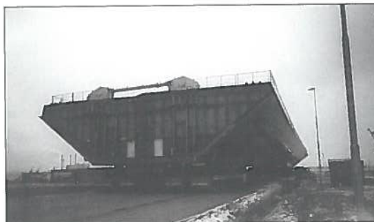
Fig. 3 a, b Trasporto a terra di una travata.
