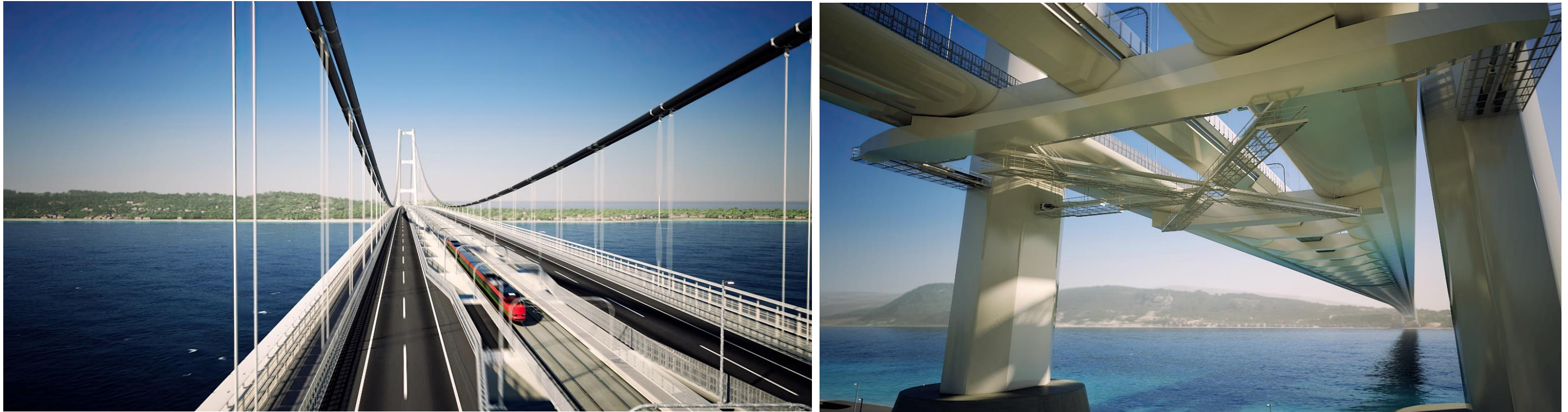
Figura 1-5 A sinistra: la sezione del nuovo ponte sospeso (esternamente le carreggiate stradali, al centro i binari ferroviari); a destra: Vista dal basso dell'impalcato in corrispondenza della torre con evidenza dei percorsi per l'ispezione e la manutenzione degli elementi strutturali
