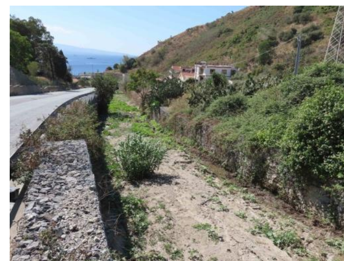
Foto 1 – Particolare del corso d'acqua in cui si prevedono interventi di miglioramento/ripristino dell'Habitat 3290
