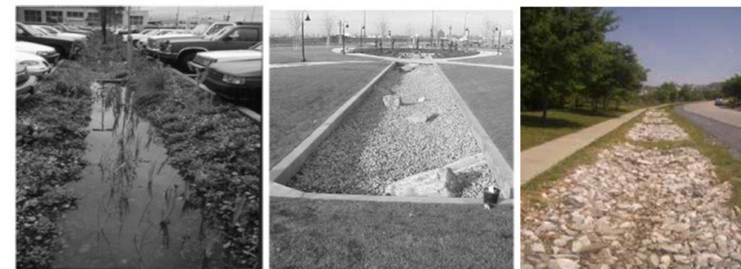
Tipologico di trincea d'infiltrazione
