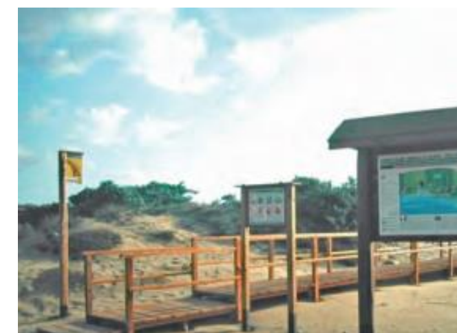
Foto 6 - Esempio di realizzazione di strutture informative per il corretto accesso ed uso della spiaggia (Foto Bovina G. in Onori L. (a cura di), 2009.)
