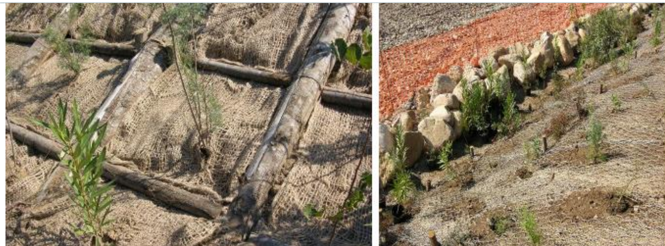
Foto 3 – Esempi di interventi di consolidamento delle rive con tecniche di bioingegneria (piantumazione in grate di legno a sinistra e piantumazione con plantule radicate e talee) (Angelini P., et al., 2009)
